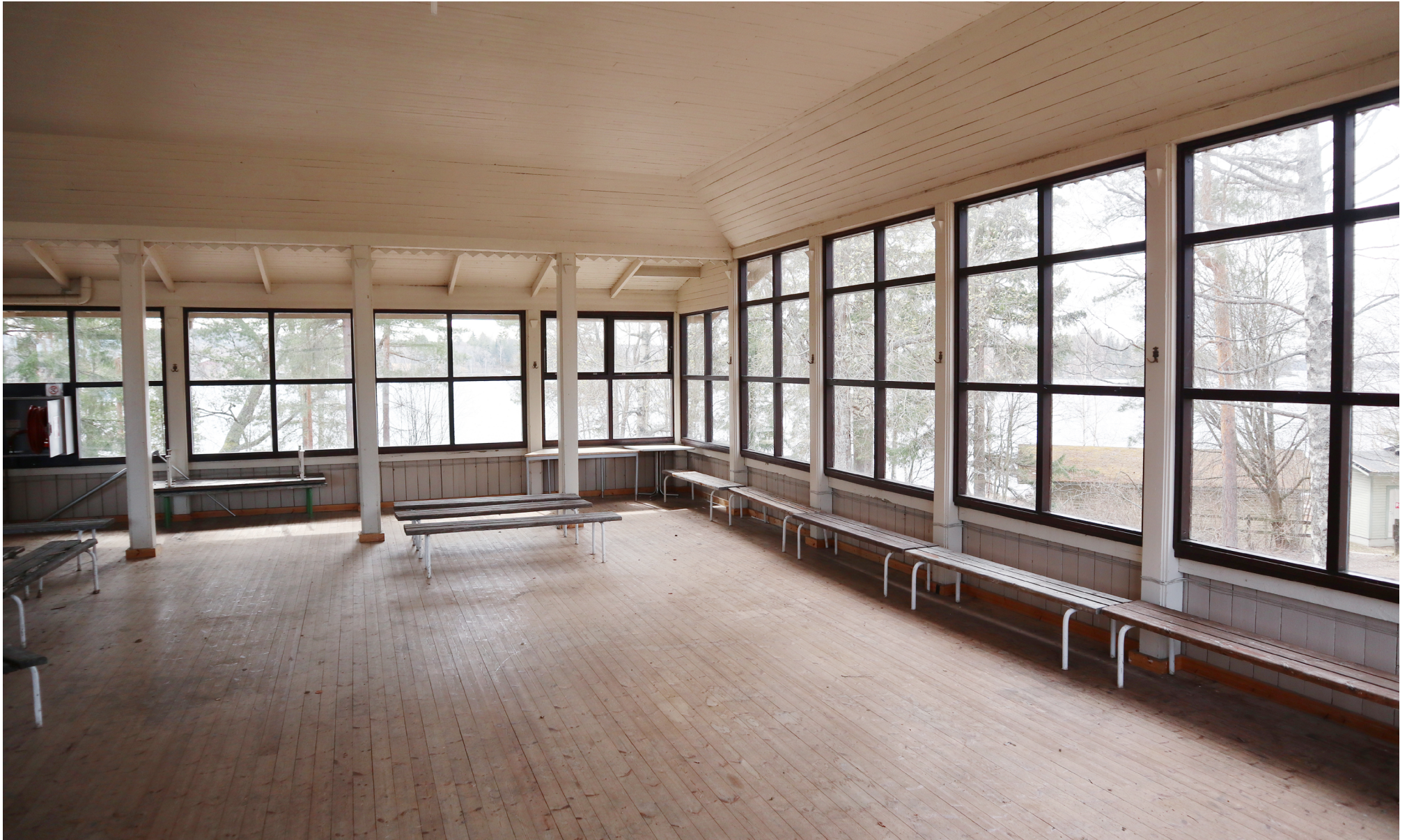
Tanssisalin lautakatto on maalattu valkoiseksi, lattia on uusittu 2000-luvulla ja ikkunat asennettu 1970-luvulla
