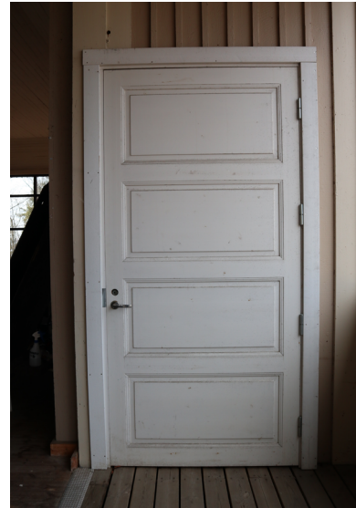
Hissiä varten rakennettu ovi lännen puoleisessa kassassa
