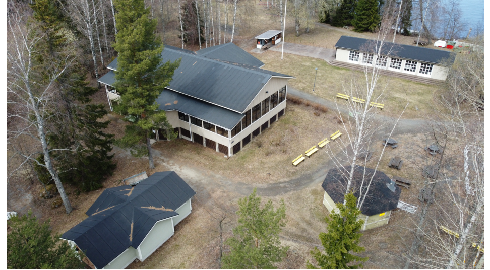
Näkymä kaakosta - paviljongin eteläpuolella jätevarasto (2007) ja itäpuolella kioski (1988)
