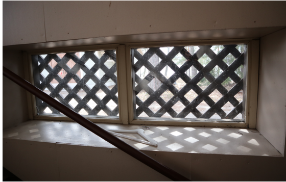
Kiinteä yksilasinen ikkuna kellarin portaan kohdalla
