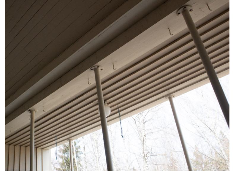
Sisäänkäynnin yläpuoliseen palkkiin kiinnitetty koukkurivistö
