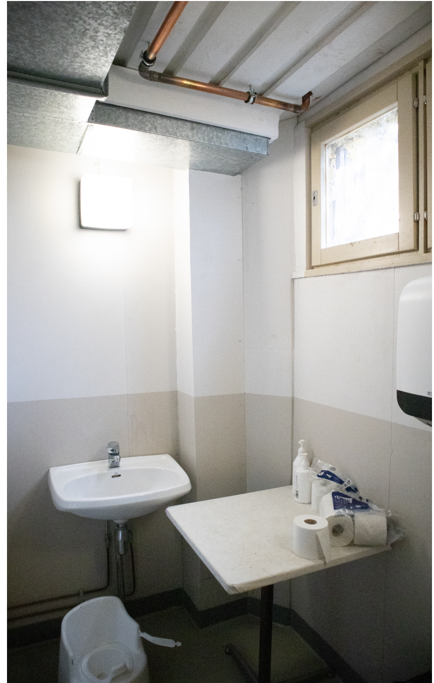
Ikkunallinen wc-tila kellarissa
