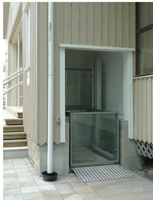
Lipunmyyntikassan paikalle rakennettu invanostin. TPA.
