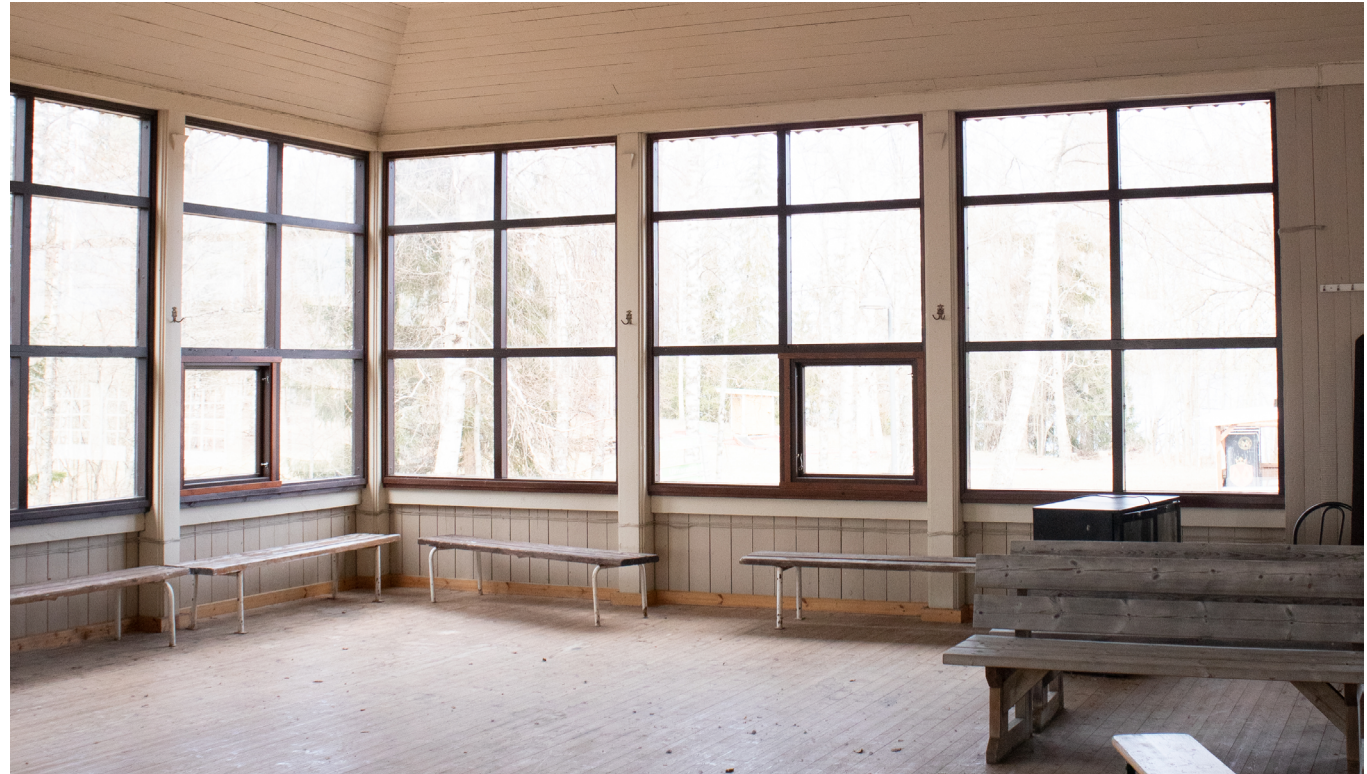
Osassa 1970-luvulla asennetuissa ikkunoissa on avautuva tuuletusikkuna
