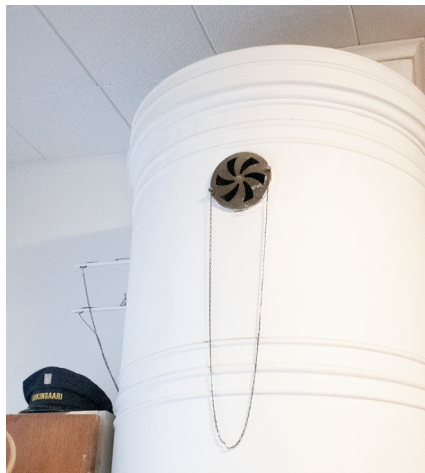
Läntisen huoneen uunin teräksinen tähtiventtiili.
