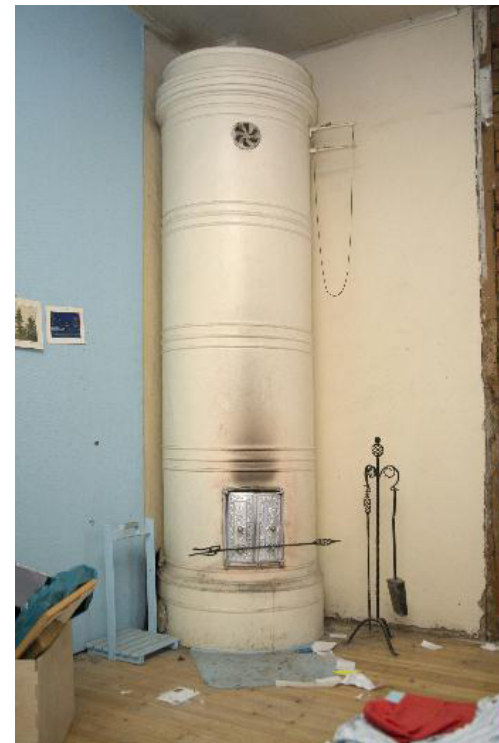
Vertailun vuoksi valokuva 1920-luvulla rakennetusta puutalosta Tampereella: Rautatieläisten vanhan asuntokasarmen (Vellamonkatu 2 B 5) peltikuoriuuni eli pönttöuuni. Marika Tamminen 2009. VKA.
