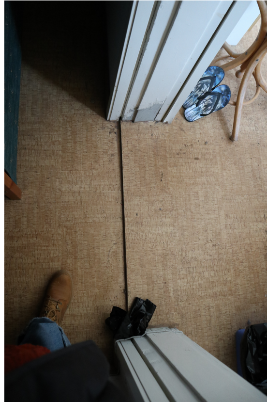
Huoneiden lattiat on päällystetty kauttaaltaan muovimatoilla, arviolta 1980-luvulla. Muovimaton alla on todennäköisesti alkuperäinen lautalattia 1890-luvulta.
