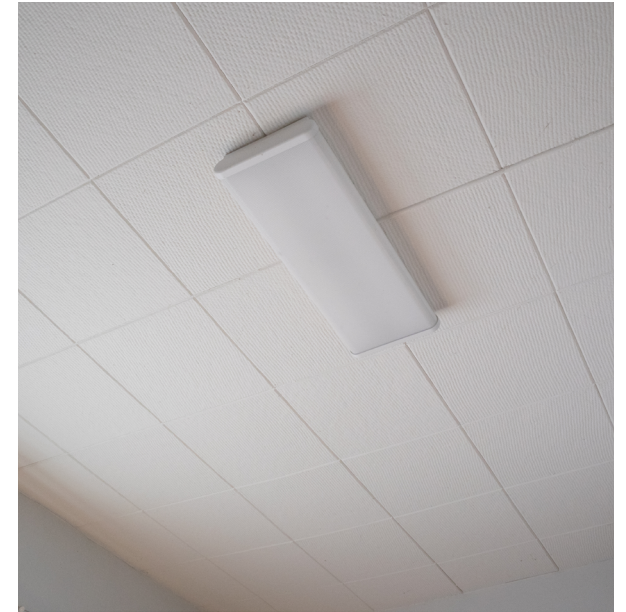
Asuinkerroksen kattopinnat on levytetty, arviolta Halltex-levyä 1980-luvulta
