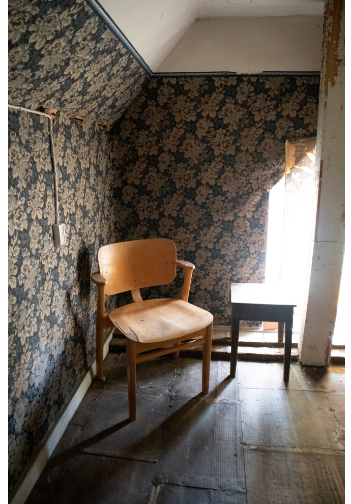
Ullakolle on rakennettu erillinen varastotila eteläjulkisivun ikkunan kohdalle. Tummat kukkatapetit muistuttavat 1920-luvun tapettityyliä ja tila on mahdollisesti rakennettu silloin.
