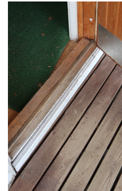
Rakennuksen ulko-ovi on uusittu todennäköisesti 1980-luvulla
