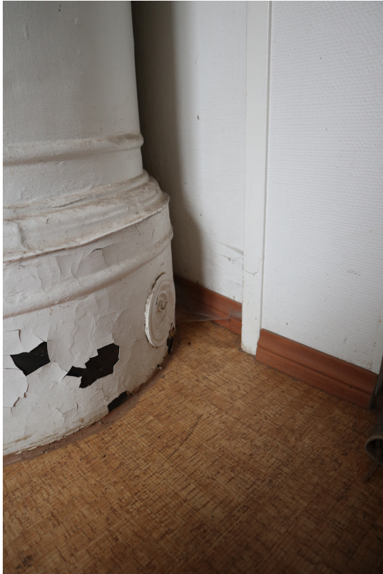
Peltikuoriuuni on jälkeinpäin maalattu synteettisellä maalilla josta on irronnut isoja paloja.
