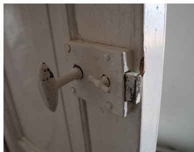
WC- ja pesuhuoneen:n peiliövi, alun perin säiliöhuoneen ovi. Tyyllillisesti kartiosaranoita käytettiin 1800-luvun lopulta 1950-luvulle asti. Avainlukkoa ei ole upotettu vaan on asennettu oven pintaan, kuten varhaiset lukot yleisesti tehtiin. Ainoastaan ovenkarmit on uusittu.
