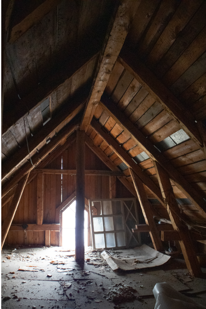
Ullakkokerros on tuulettuva tila jota ei ole lämpöeristetty. Tila on varastokäytössä.
