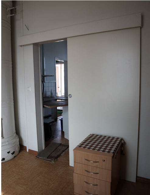
Asuinhuoneiden 104 ja 105 välille rakennettu moderni liukuovi
