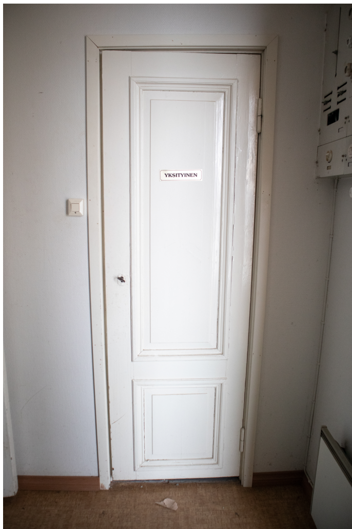
WC- ja pesuhuoneen:n peiliövi, alun perin säiliöhuoneen ovi. Tyyllillisesti kartiosaranoita käytettiin 1800-luvun lopulta 1950-luvulle asti. Avainlukkoa ei ole upotettu vaan on asennettu oven pintaan, kuten varhaiset lukot yleisesti tehtiin. Ainoastaan ovenkarmit on uusittu.
