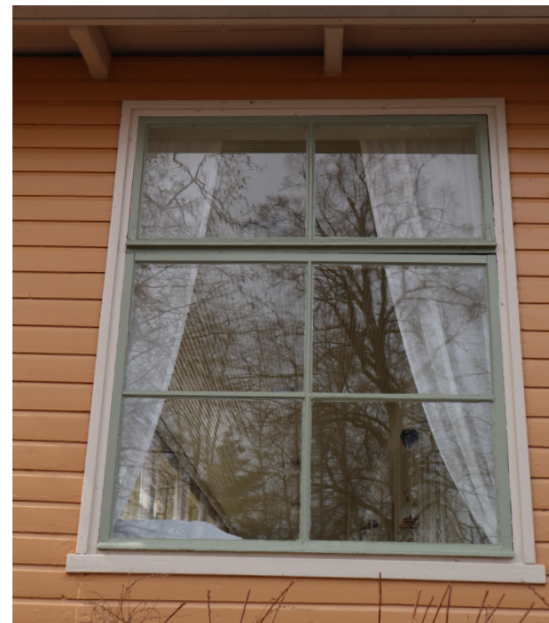
1950-luvun ikkuna eteläkuistilla
