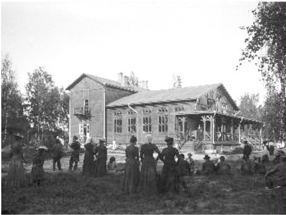
Vasta rakennetun ravintolan länsijulkisivua. Kuvassa näkyy alkuperäisiä, mutta jo purettuja elementtejä: länsijulkisivun parveke ja eteläinen avoin kuisti. Berndt Blom 1900-1903. VKA.
