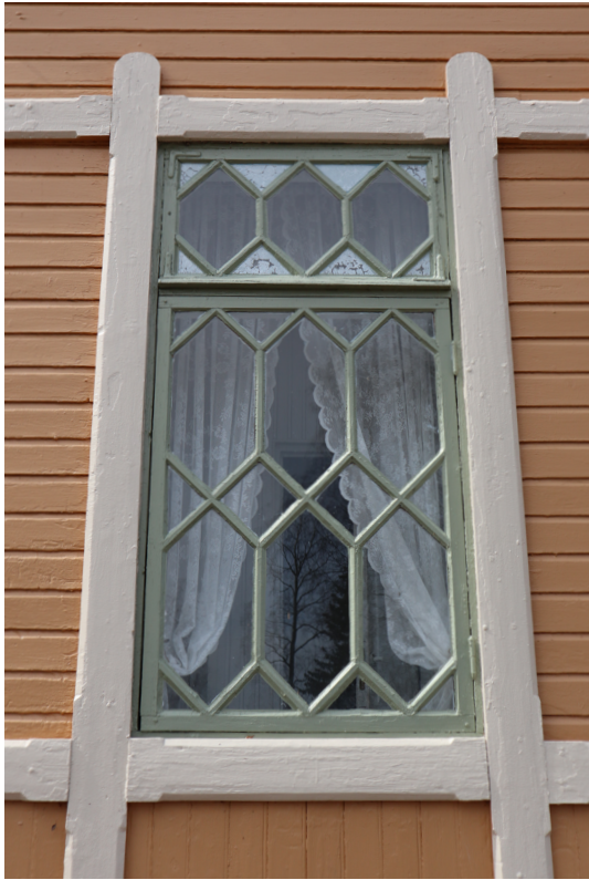
Alkuperäinen ikkuna itäjulkisivulla
