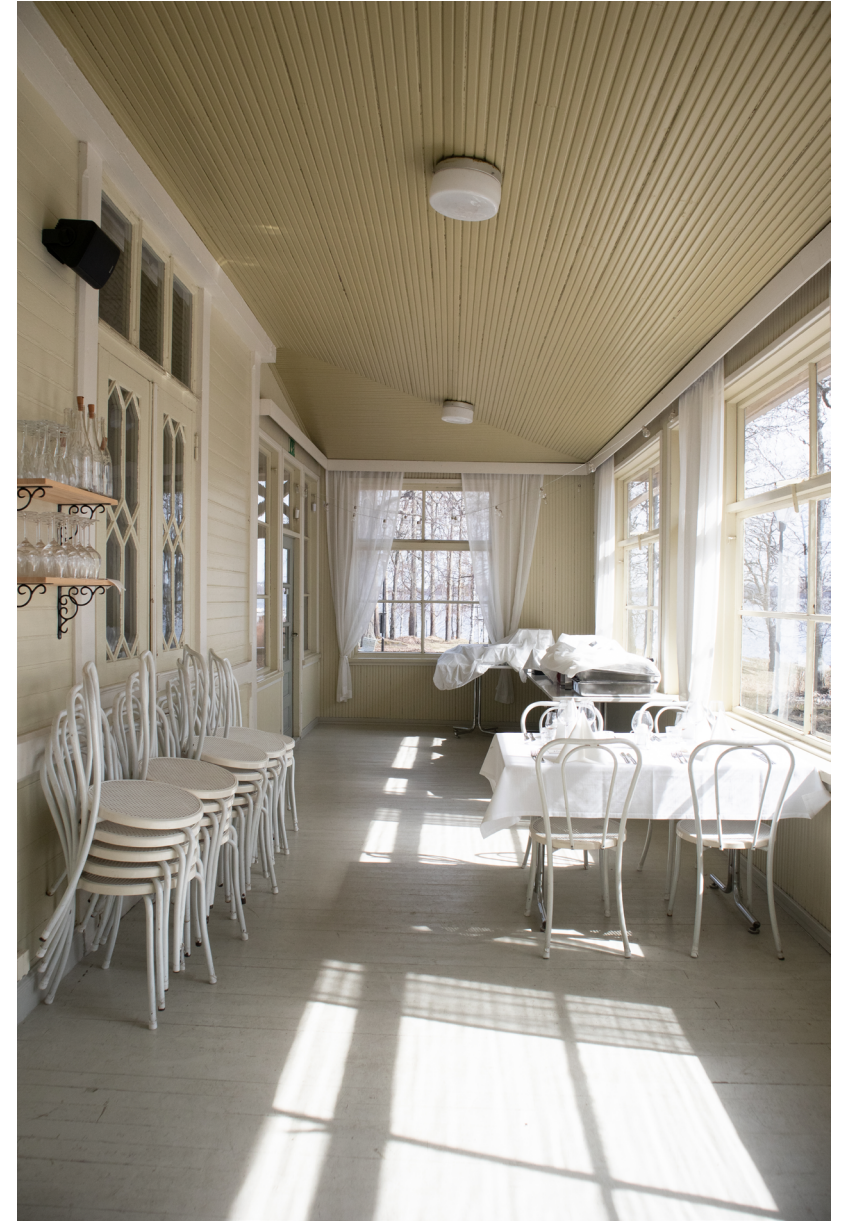
Eteläinen kuisti rakennettiin umpinaiseksi ja ikkunalliseksi tilaksi 1950-luvulla.
