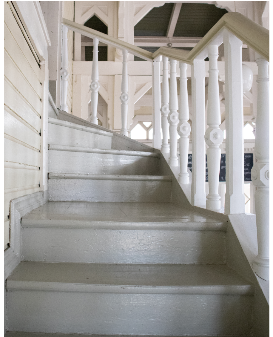
Toiseen kerrokseen johtava puinen porras on pysynyt alkuperäisessä asussaan. Porras entisöintiin 1970-luvulla. Kaiteiden balusterit ja vinotuet ovat niin ikään koristeellista nikkarityyliä.
