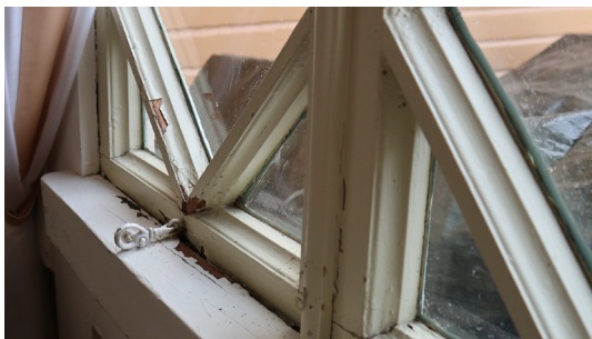
Vuonna 1900 rakennetut ikkunat ovat kiinni sormihakoilla
