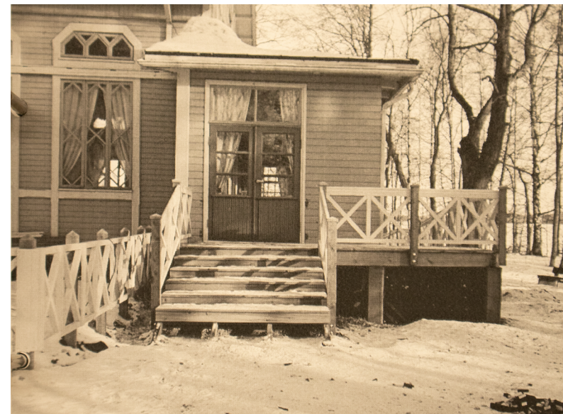
Vanha ja jyrkkä luiska purettiin ja uusi rakennettiin nousemaan eteläjulkisivun suuntaisesti.
