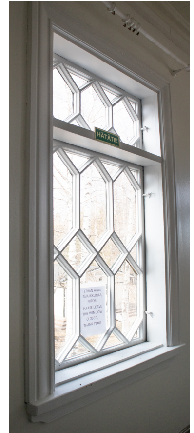
Parvekkeen tilalle rakennettu ikkuna sisäpuolelta. Ikkunan karmit ja laudat eroavat hieman vuonna 1900 rakennetuista ikkunoista.
