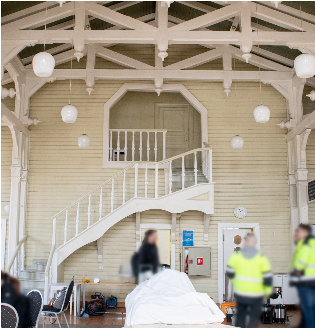
Toiseen kerrokseen johtava puinen porras on pysynyt alkuperäisessä asussaan. Porras entisöintiin 1970-luvulla. Kaiteiden balusterit ja vinotuet ovat niin ikään koristeellista nikkarityyliä.
