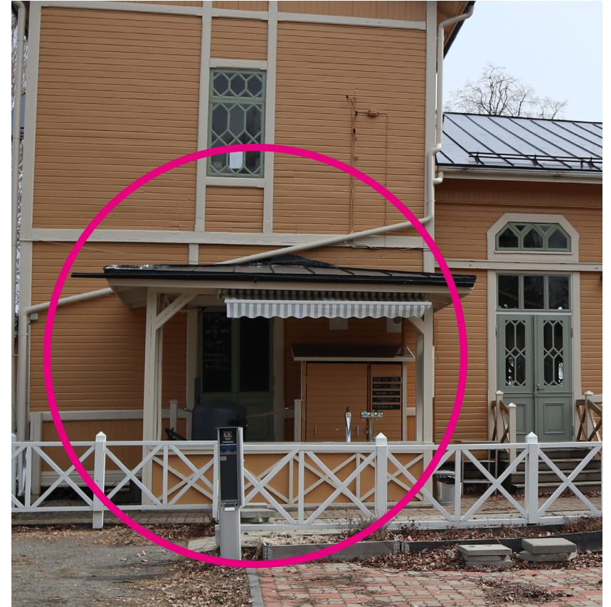
Sama paikka länsijulkisivulla vuonna 2022.
