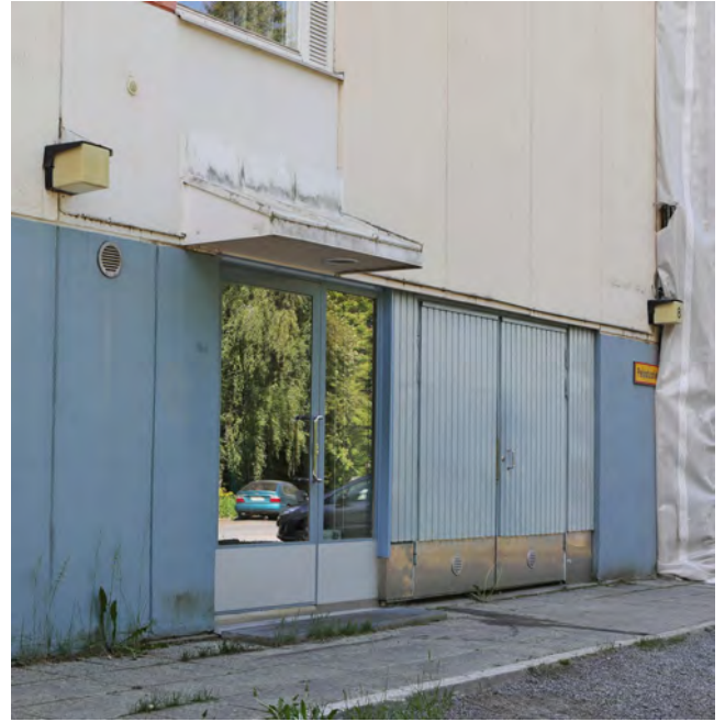
Kuva 25. Tornin 4 (8D) pesulan metalliovi ja valkoinen kattolippa.
