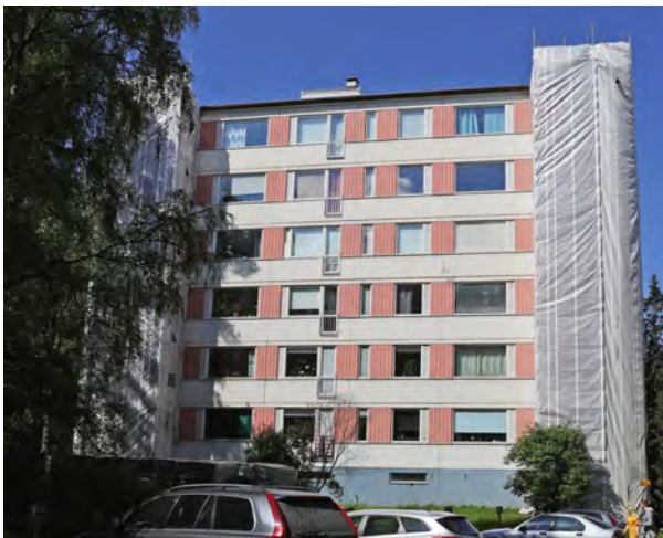
Kuva 34 Torni 4 (8D) idästä kuvattuna 2021.
