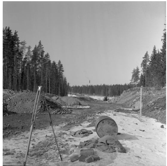
Kuva 5. Teiskontie rakentuu vuonna 1965. (Siiri-kuvatietopalvelu)
