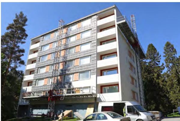
Kuva 35. Torni 5 (10E) lännestä kuvattuna 2021. Julkisivuremontti on käynnissä.
