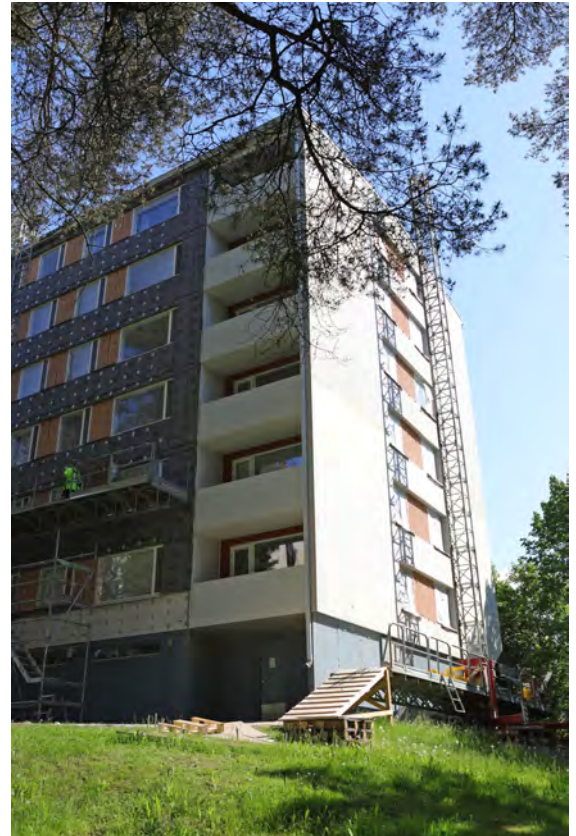
Kuva 61. Tornin 5 (10E) julkisivun korjaustyö on käynnissä.
