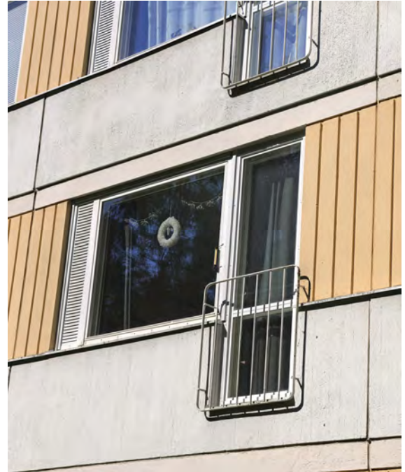
Kuva 36. Ranskalaisen parvekkeen pinnakaiteet tornissa 1 (2A).
