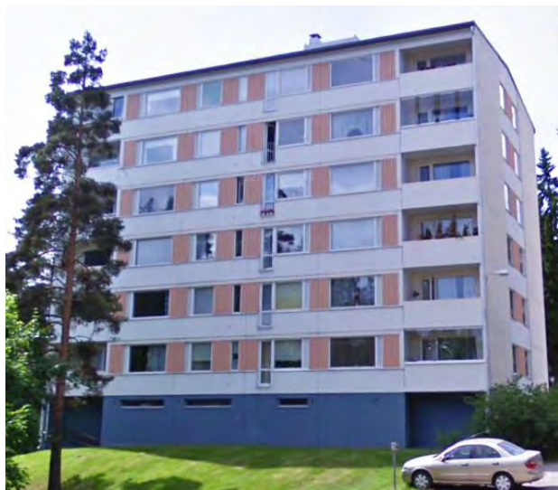
Kuva 66. Tomi 5 (10E) ennen julkisivukorjausta vuonna 2019. (Google Maps)
