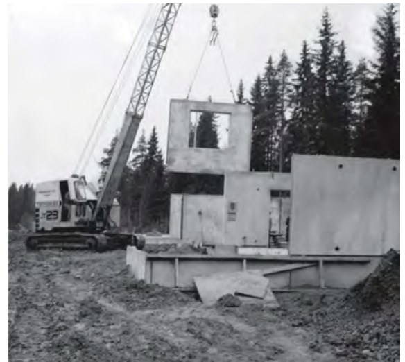
Kuva 8. Täyselementtirakenteinen pientalo rakentumassa. (lähde: Aarre Mattisen valokuvakokoelma / Rakennusliike Mattinen & Niemelä Oy)
