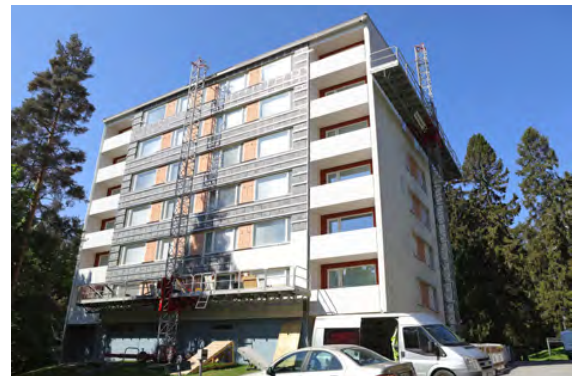
Kuva 63. Tornin 5 (10E) julkisivua korjaustyön aikana idästä.
