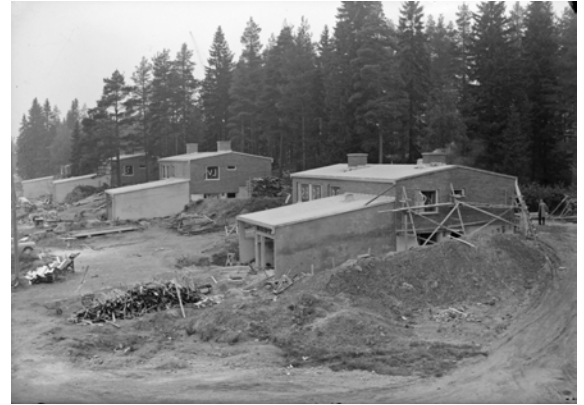
Kuva 7. Täyselementtirakenteisia pientaloja tiiliverhouksella rakentuu Ruotulan etelän puoleisille tonteille Tornimäenkadulle vuonna 1963. (Siirikuvatietopalvelu)
