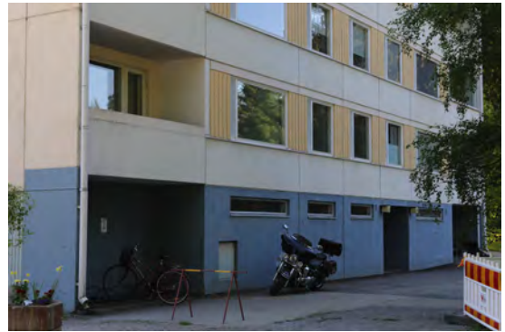
Kuva 29. Pyöräteline parvekkeiden alla, maantasokerroksen leveät ikkunat sekä leveät vesipellit ikkunoiden alla tornissa 1 (2A).
