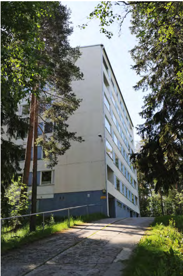
Kuva 28. Tori 2 (4B) pohjoisesta kuvattuna 2021.
