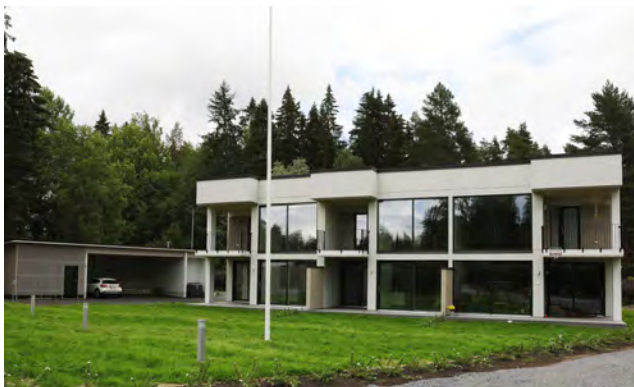
Kuva 49. As Oy Ruotujaakon julkisivu länteen.
