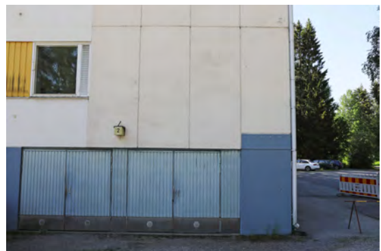
Kuva 30. Autotallin ovet ja pykällys sokkelissa tornissa 1 (2A).
