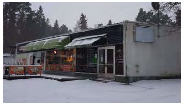
Kuva 52. Ruotulan liikekeskus vuonna 2017. Rakennus on purettu uudisrakennuksen tieltä. (BST-Arkkitehdit Oy)
