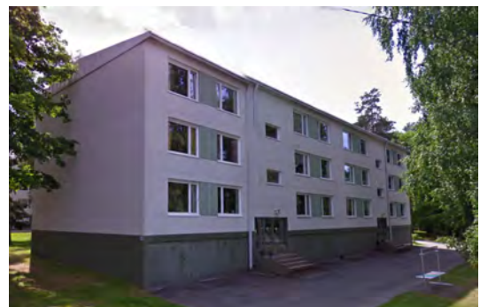
Kuva 15. Laalahdenkadun talo Ruotulassa. (Google Maps) Kokonaisuuden talot rakennettu vuosina 1965-1966.
