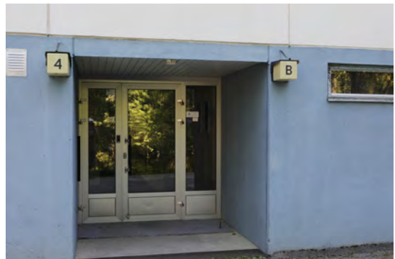
Kuva 31. Sisäänkäyntisyvennys ja uusittu ulko-ovi tornissa 2 (4B).
