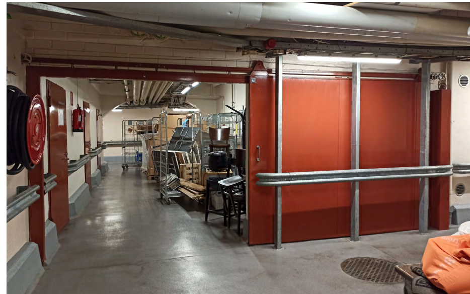
Käytävä 006B, palo-oven takana kärryjen säilytys- ja puhdistustila.
