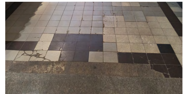
Rikkoutuneita ja korvattuja laattoja itäsisäänkäynnin tuulikaapin edustalla.
