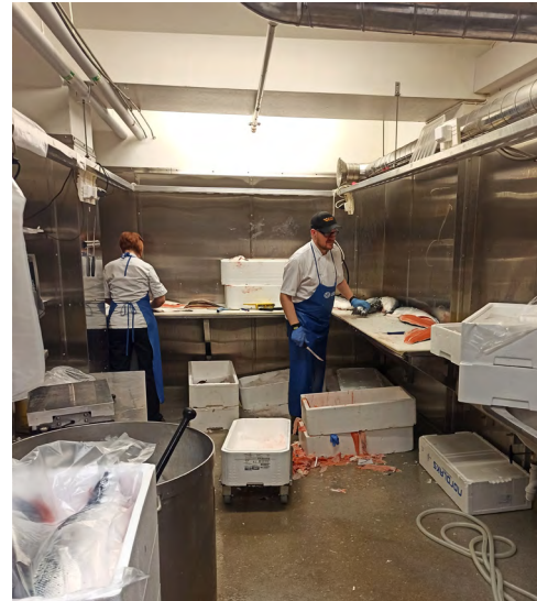
Kalanperkaustilassa 016 seinillä on rst-levytystä.
