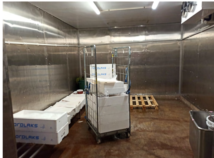
Suunnitelman mukaan livekalakellarin seinät ovat hapon kestävää terästä.
