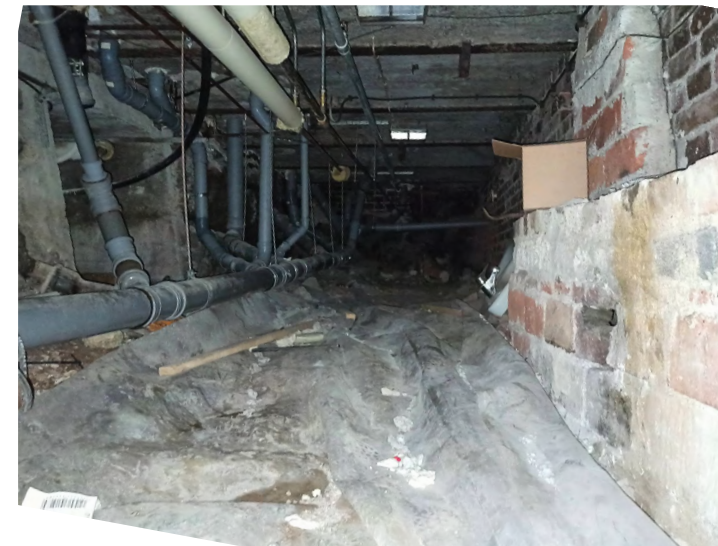
Pohjoispään tekninen tila 010A. Pohjaa on muovitettu laajalta alueelta.
