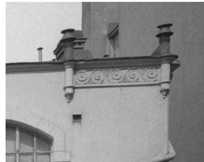
Räystään yli nousevat sauvat ja aaltoköynnösornamentti ovat vielä paikallaan. Ote sivun 61 kuvasta.
