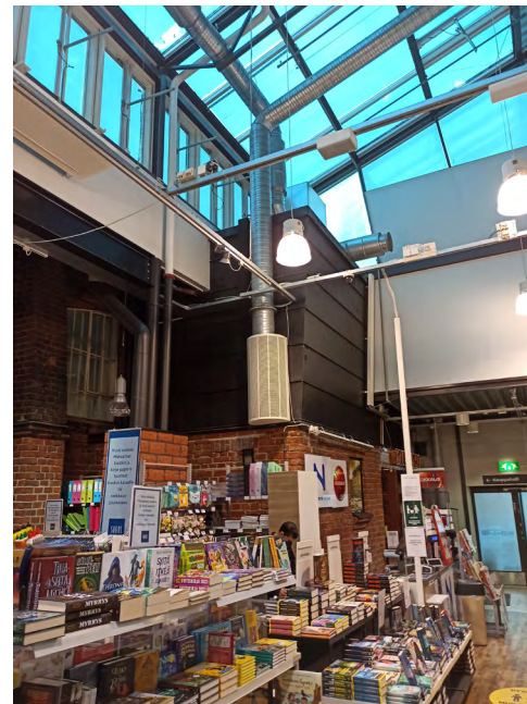
Mustaksi pellitetty iv-konehuone on jäänyt lasikatetun alueen sisään.
