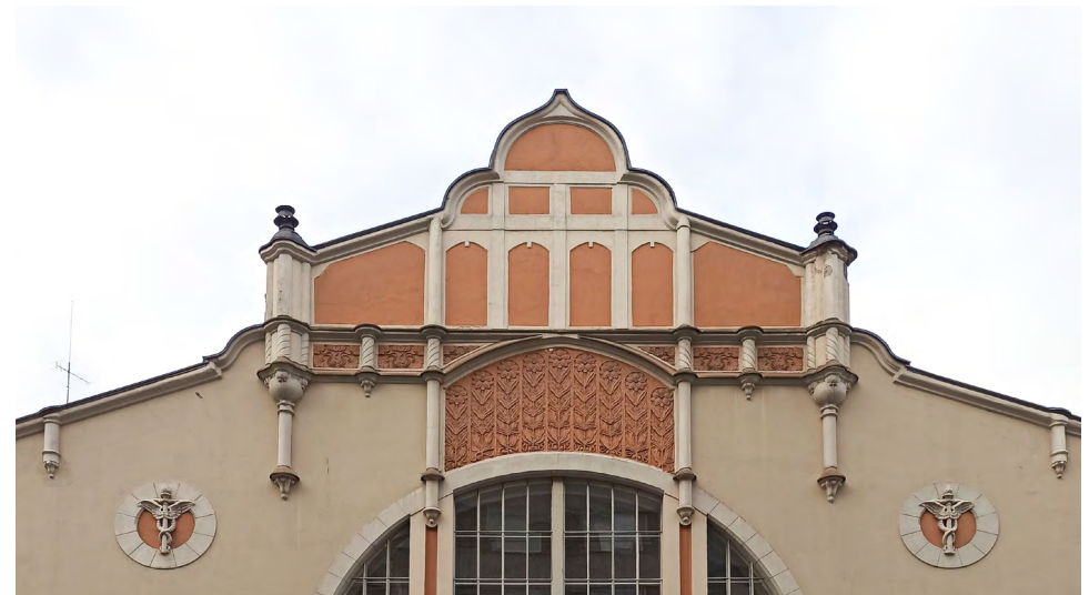
Ote Åbergin eteläjulkisivusta vuodelta 1899. Alla valokuva nykytilanteesta. Yläosan rapatut kentät ovat jääneet ilman koristeita. Räystäslinjan yli nousevat sauva-aiheet on oudolla tavalla katkottu. TKA.
