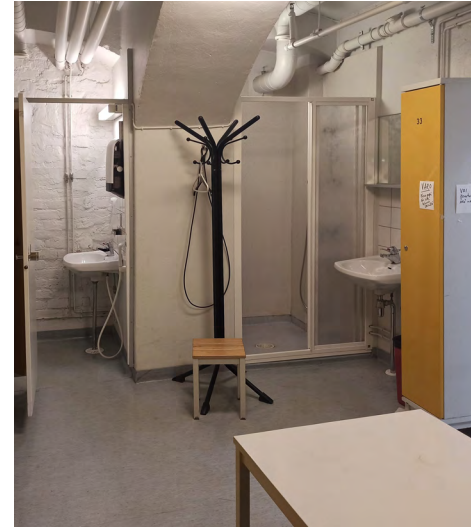
Sosiaalitila 075, entisen kahvilan wc-tilat on muokattu sosiaalituloiksi. Lattiasa ja suihkun seinissä on muovimattoa.
