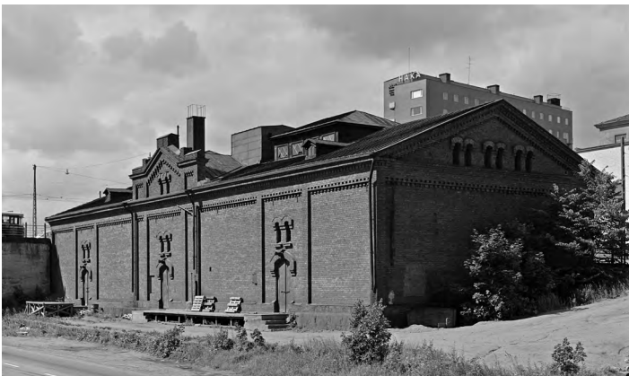
Sörnäisten Kruununmakasiini (1892) edustaa Åbergin punatiiliarkkitehtuuria. Kuvaaja: Kari Hakli, 1969. Alkuperäislähde: Helsingin kaupunginmuseo. MV.
