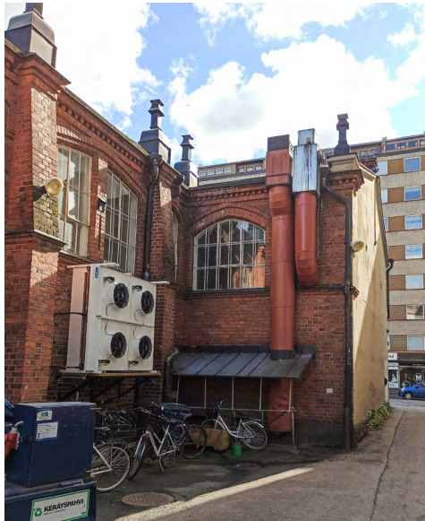
Nurkassa on katettu kellarin porras, jossa kulkua hankaloittaa räystäään yläpuolelle nouseva hormi.
