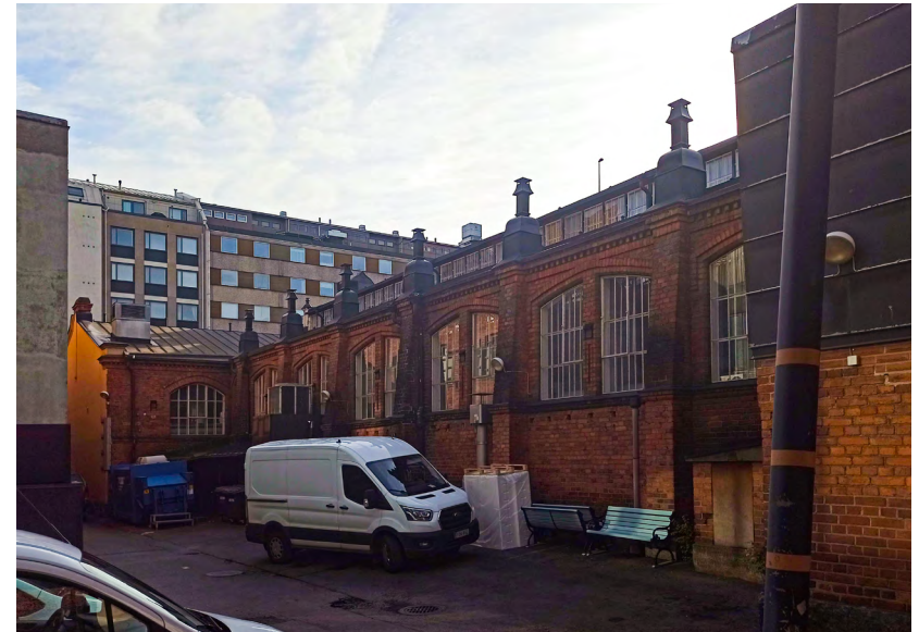
Itäpihan punatiilijulkisivua. Piha toimii huoltopiha ja parkkipaikkana. Pakettiauton taakse jää katettu kellarin porras ja kevytrakenteinen varasto.
