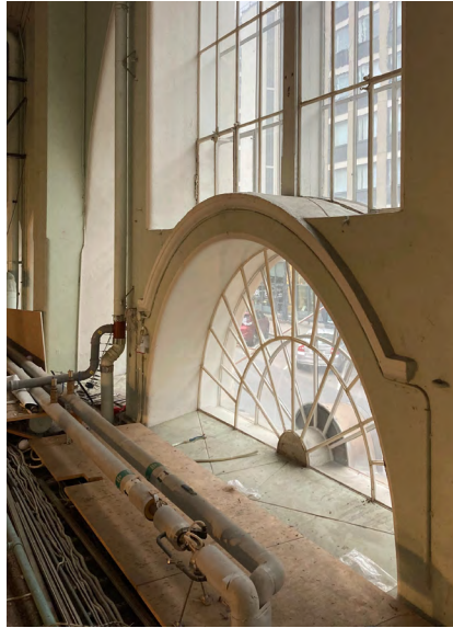
Lunetti-ikkuna sisäpuolelta. JM.
