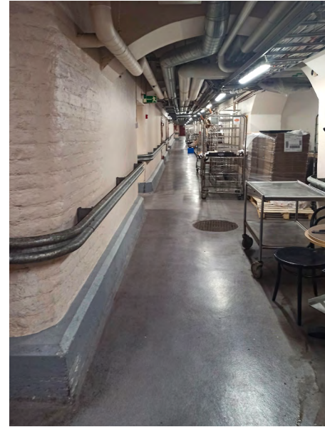
Lännenpuoleista käytävää käytävältä 008 kuvattuna.
