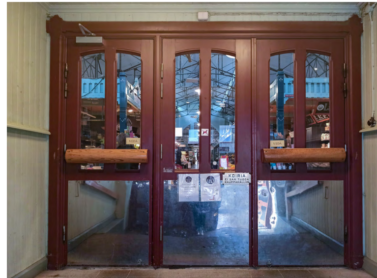
Pääsisäänkäynti hallituskadulla. Jugend-puuovet on korvattu moderneilla teräsovilla. Tuulikaapin puiset sisäovet (alla) ovat säilyttäneet vanhan ilmeensä.
