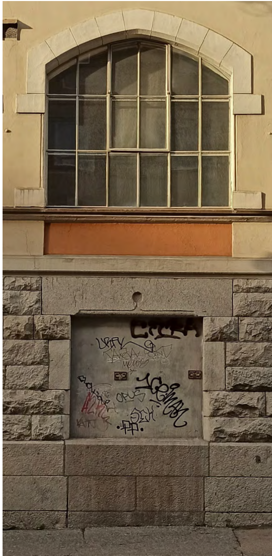
Metalli-ikkuna tuuletusikkunoineen sekä poistettu sisäänkäynti eteläjulkisivussa.
