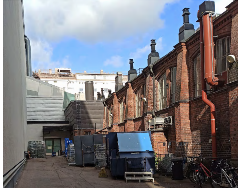
Länsipiha toimii huoltopiha ja pyöräparkkina. Perällä lasikattoinen laajennus. Sisäänkäynnin edusta on sidekivetty.
