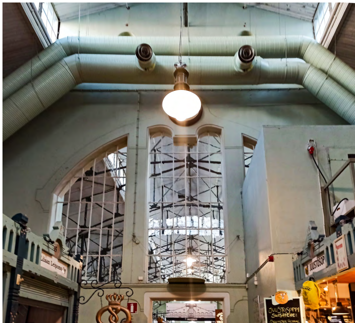
Väliseinän suurta kolmiosaista ikkunaa peittää hissin konehuone. Kattoikkunoiden valoa varjostavat iv-hormit.
