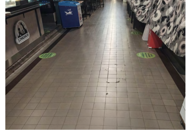
Keskikäytävän laatoitusta takahallissa.
