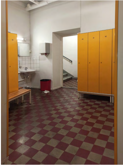
Sosiaalitulassa (077-78) vanhasta kellarikahvilasta on jäljellä ruutulaatoitus ja käytöstä poistetut portaat pihalle. Tasoite-pintaaiset, puhtaaksimuuratut tai lasikuitutapetoidut seinät on maalattu valkoisiksi. Altaiden taustat on laatoitettu.
