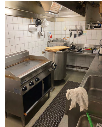
Keittiötilassa 009 on laatoitetut seinät ja massalattia. JM.
