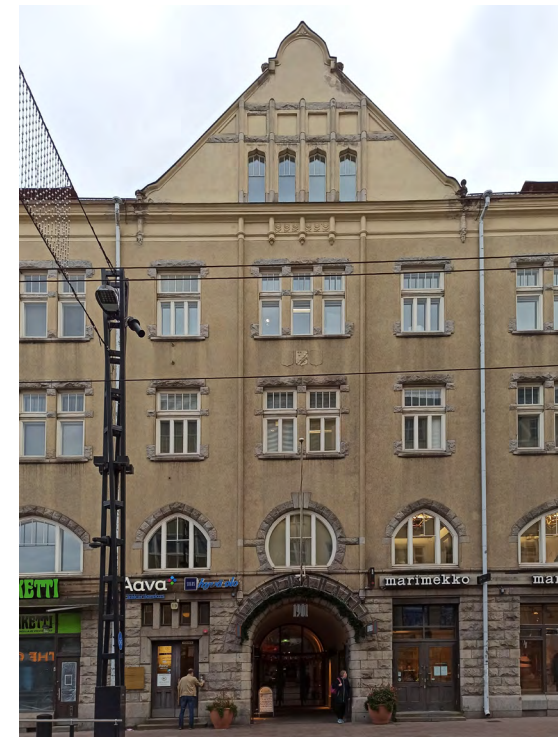
Kauppahallin sisäänkäynti Hämeenkadulta virastotalon porttikäytävän kautta.
