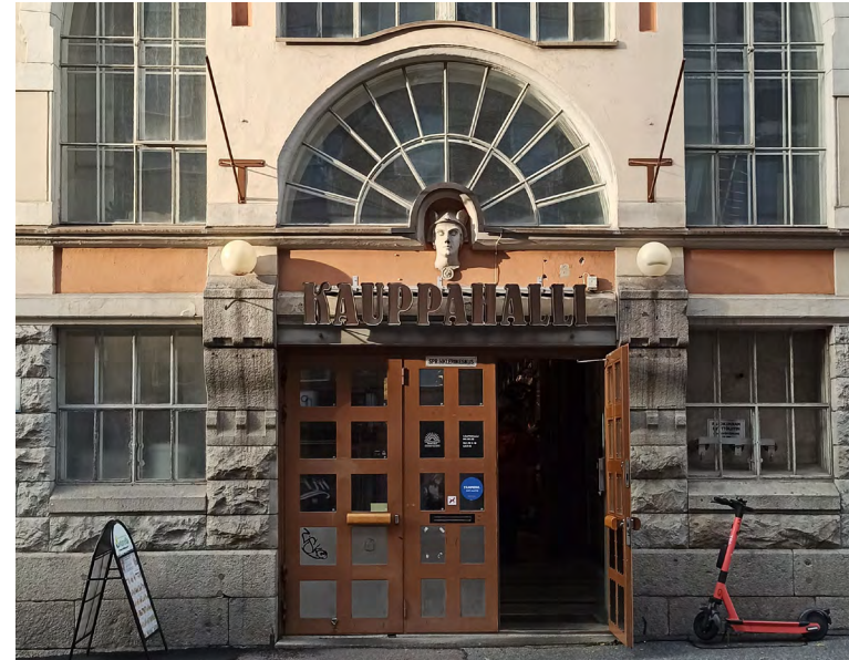
Pääsisäänkäynti hallituskadulla. Jugend-puuovet on korvattu moderneilla teräsovilla. Tuulikaapin puiset sisäovet (alla) ovat säilyttäneet vanhan ilmeensä.
