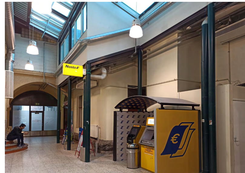
Lasikatettu käytävä. Perällä holvikäytävän yllä 2. kerroksen sos.tilalaajennus. Oikealla hallin pohjoisjulkisivua.
