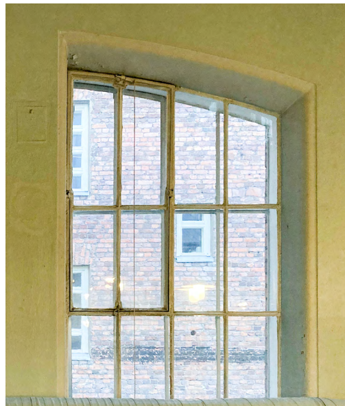
Tuuletusikkunoiden avautumista sää- dellään alhaalta vaijerilla. JM.
