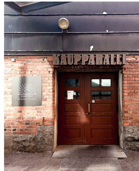
Sisäänkäynti itäpuolelta. Puuovet samaa mallia kuin lännen puolella.
