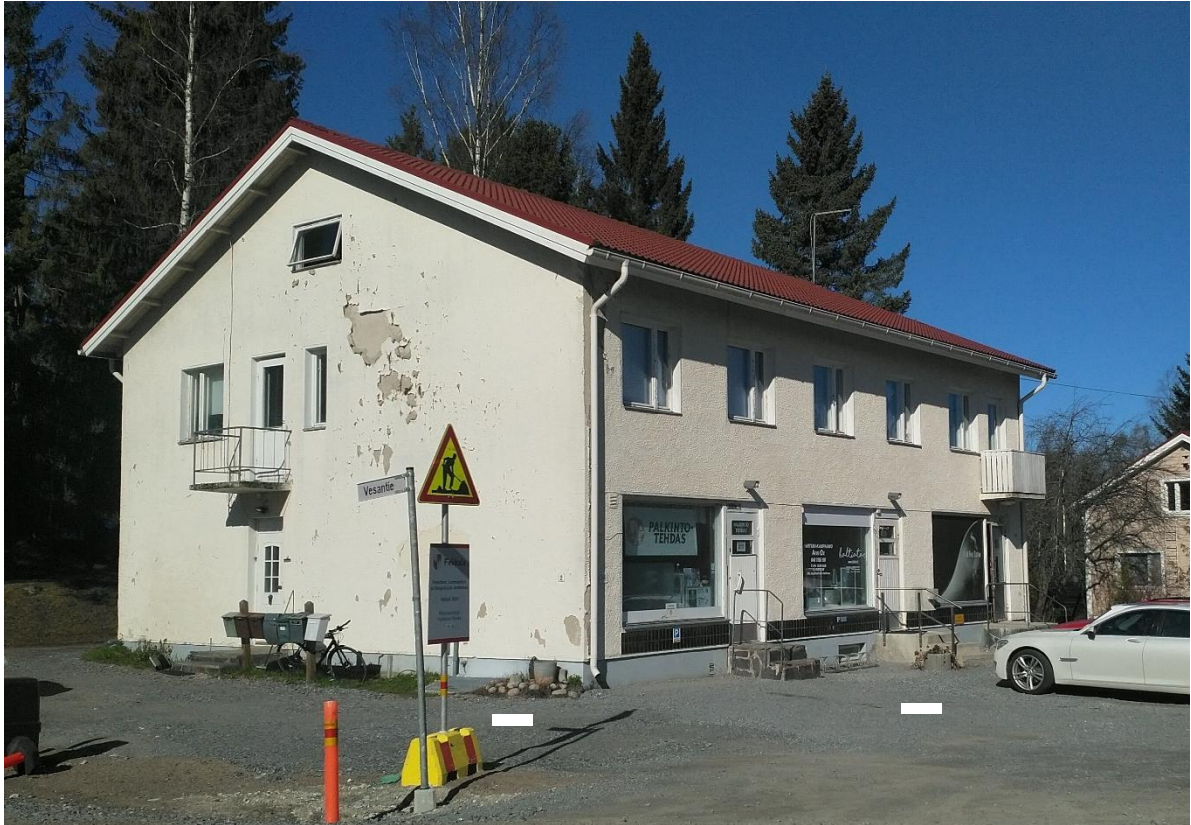
Kuva 36. Alueen toinen vanha liikerakennus Killontorintien varrella.
