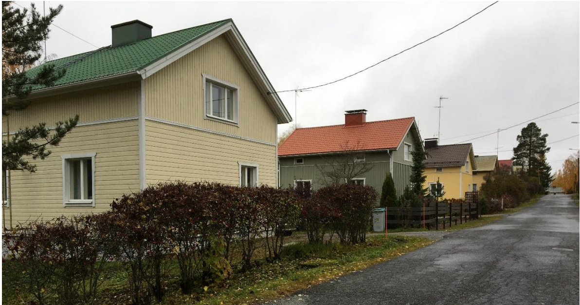
Kuva 7. Killontien 1,5-kerroksiset tyyppitalot rivissä, päätyjulkisivut katua kohden.
