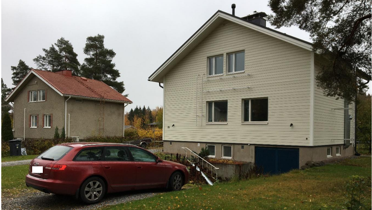
Kuva 29. Tyypilliset julkisivumateriaalit, lautaverhous sekä rappaus, edustettuna Pirkantiellä. Pirkantie rakentui melko myöhäisessä vaiheessa Killon alueelle, mikä näkyy rakennusten suuremmassa runkosyvyydessä.
