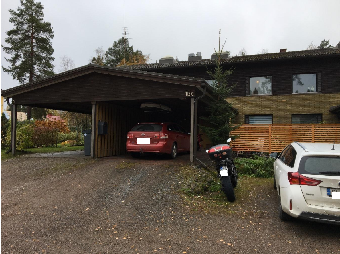
Kuva 33. Selvitysalueella sijaitsee yksi rivitalo, joka on kaksikerroksinen ja neliasuntainen. Se on rakennettu vuonna 1977.
