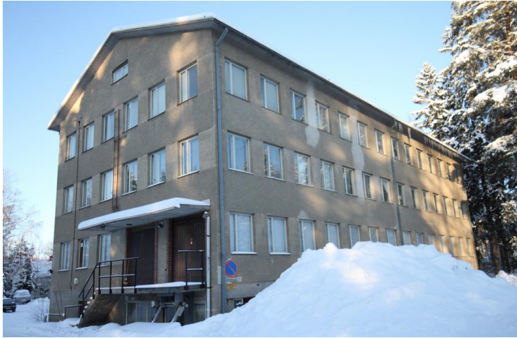
Kuva 30. Pienteollisuustalon etelä- ja itäjulkisivu. Rakennuksen ulkonäköä on kuvattu edellä tekstissä.
