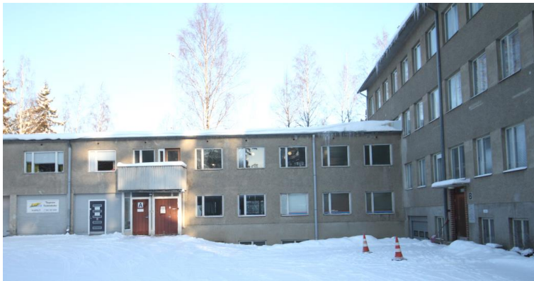
Kuva 31. Pienteollisuustalon pihajulkisivut. Kuvan vasemmassa reunassa näkyy kaksikerroksinen lisäsiipi ja oikeassa reunassa alkuperäisen rakennusosan pihanpuoleinen julkisivu. Kumpaankin osaan on sisäänkäynnit pihan puolelta.
