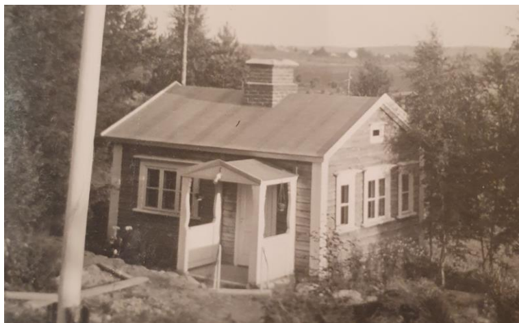
Kuva 54. Vanha ajoittamaton mustavalkoinen valokuva kohteen pihapiirin eteläreunalla olleesta saunarakennuksesta. Rakennus on myöhemmin purettu. Kuvassa näkyy saunan pohjoisjulkisivu ja länsijulkisivu. Pohjoisjulkisivulla on avo-kuisti. Rakennuksessa on pienet ruutuikkunat ja huopakate. Taustallan näkyy vielä rakentamaton Takahuhdin peltoaukea ja Messukylänharjulle sijoittuvaa asutusta. Kuvälähde: kohteen omistajien hallussa oleva vanha valokuva. Kuvan ottaja on tuntematon.
