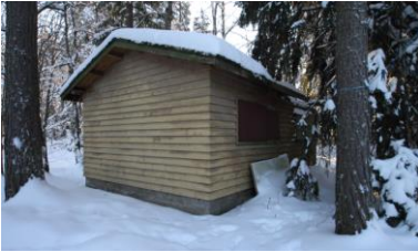
Kuva 50. Entisen maatilan tilakeskuksen talousrakennus.
