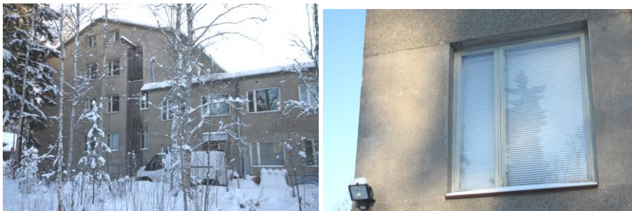
Kuva 32. (vasemmalla). Pienteollisuustalon pohjoisjulkisivu. Kuvassa vasemmalla näkyy rakennuksen alkuperäinen osa ja päädyssä kolmannessa kerroksessa oleva lastausovi. Oikeassa reunassa näkyy lisäsiipi. Rakennuksen pohjoispuolella on puustoinen puisto, jonka läpi kulkevalta kävelytieltä pienteollisuustalo näkyy kasvillisuuden lomasta.
