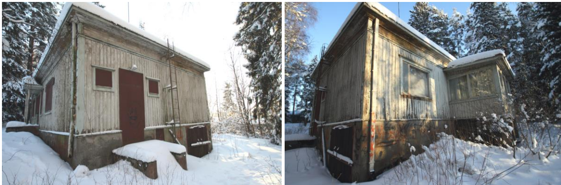
Kuva 59 vasemmalla. Asuinrakennuksen länsijulkisivu. Kuvassa näkyy sivusisäänkäynnin rakennuslevyillä peitetty ulko-ovi ja sen molemmiin puolin olevat pienet ikkunat. Betoniportaikko jää lähes lumen alle. Rinteeseen sijoittuvan rakennuksen kivijalka on länsijulkisivulla korkeampi kuin pohjoisjulkisivulla. Kuvassa näkyy myös kellariin tehdyn autotallin ovi.
