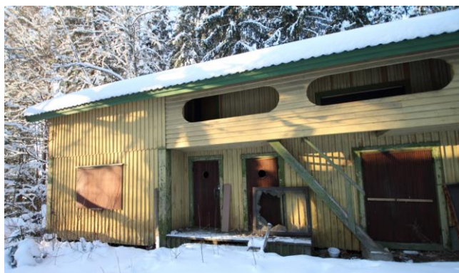
Kuva 57. Luhtiaitan pihan puoleinen itäjulkisivu. Kuvan vasemmassa reunassa näkyy rakennuksen eteläpäädystä oleva entinen asuintila. Sen ikkunat on peitetty rakennuslevyillä. Asuinosa on runkosyvyydeltään luhtikäytävän verran syvempi kuin muu aitta. Kuvan oikeassa reunassa näkyy aitan luhtikäytävä.
