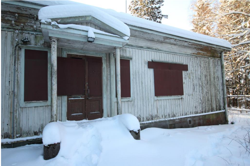
Kuva 58. Asuinrakennuksen pohjoisjulkisivu. Kuvassa näkyy klassistinen avokuisti sisäänkäynnin edustalla sekä rakennuslevyillä peitetyt ikkunat. Betoniportaikko jää lumen alle piiloon, samoin vesikatteen materiaali.
