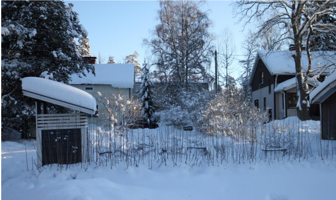
Kuva 66. Pienteollisuustalo häämöttää Yli-Huikkaantielle jälleenrakennuskauden asuintalojen välistä. Asuintalojen ton-teilla oleva kookas kasvillisuus kuitenkin peittää pienteollisuustaloa myös talvella.
