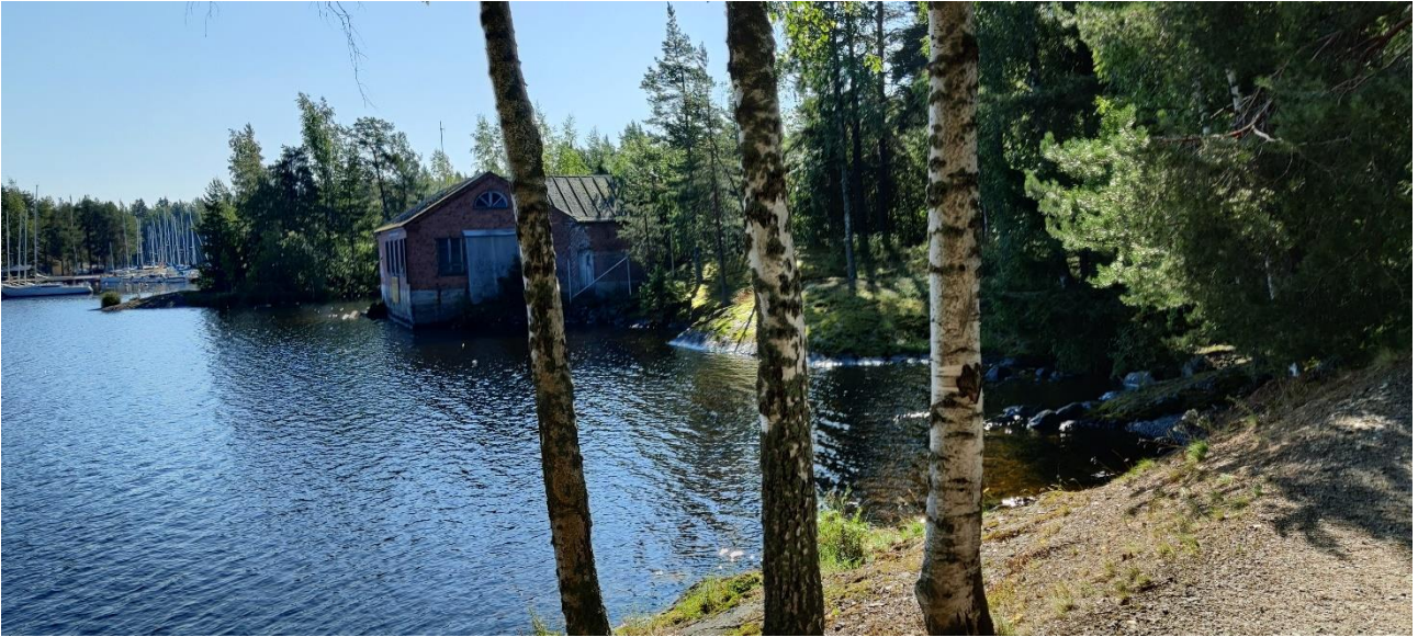
Kuva 58. Rantapolun miellyttävästä kohdasta aukeaa näkymä pumppuhuoneelle.
