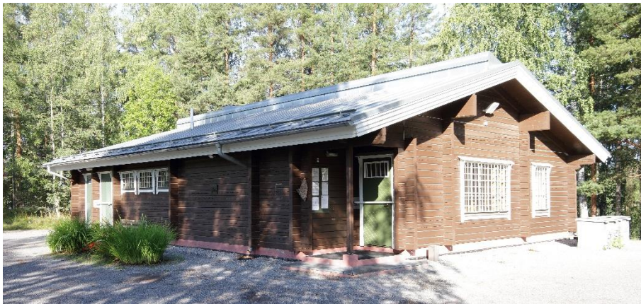
Kuva 63. Suomensaaren saunan etelä- ja itäjulkisivut. Eteläjulkisivulla on ovet huoltotiloihin ja pukuhuoneiden matalia ikkunoita. Itäjulkisivulla rakennuksen päädyssä on saunatuvan ikkuna.
