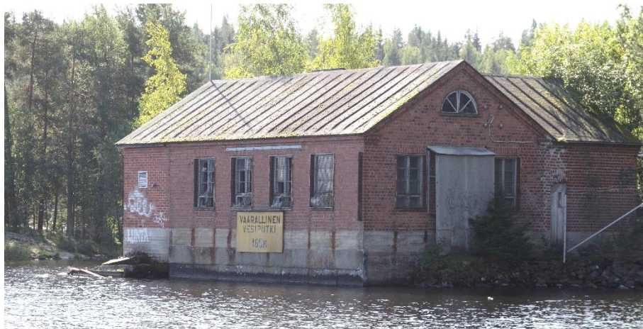
Kuva 67. Kuvassa raakavedenottamon pumppuhuoneen järvenpuoleinen pohjoisjulkisivu ja länsijulkisivu. Rakennuksen ulkonäköä on kuvattu edellä tekstissä.
