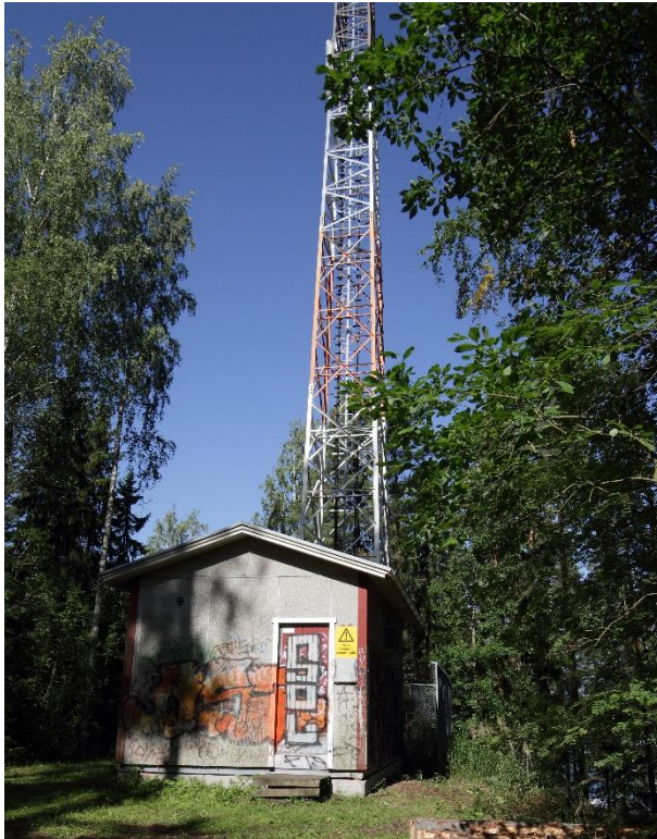
Kuva 70. Matkapuhelinmasto ja sen yhteydessä oleva konehuone. Rakennuksen ulkoasua on kuvattu ylempänä tekstissä.
