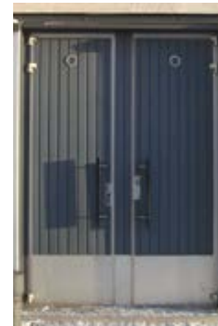
Vanhan mallin mukaan uusittu paneliovi, alkuperäisiä vetimiä, moderni alumiinilasiovi, vanha huolto-ovi ja alumiinirungolle rakennettu paneliovijäljitelmä.
