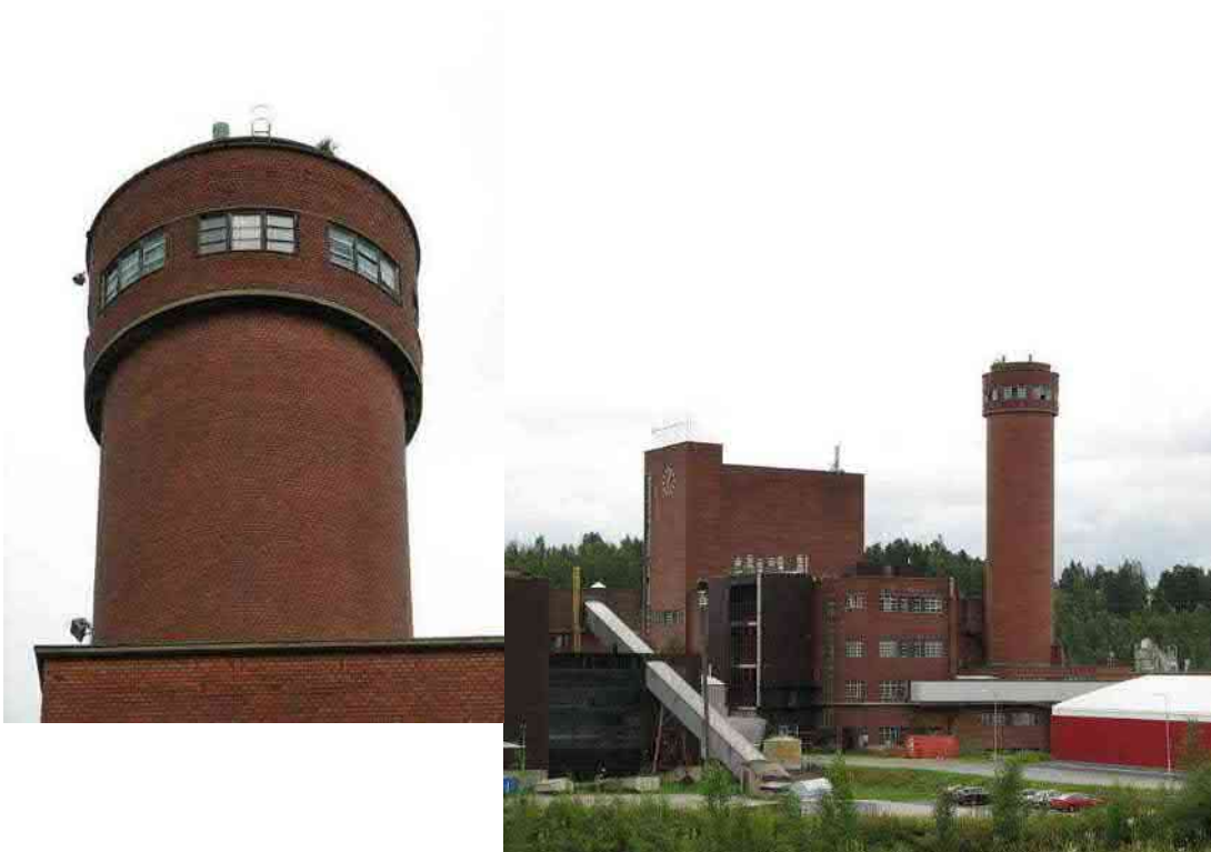
Kuvat: Happotornien suojarakennus
