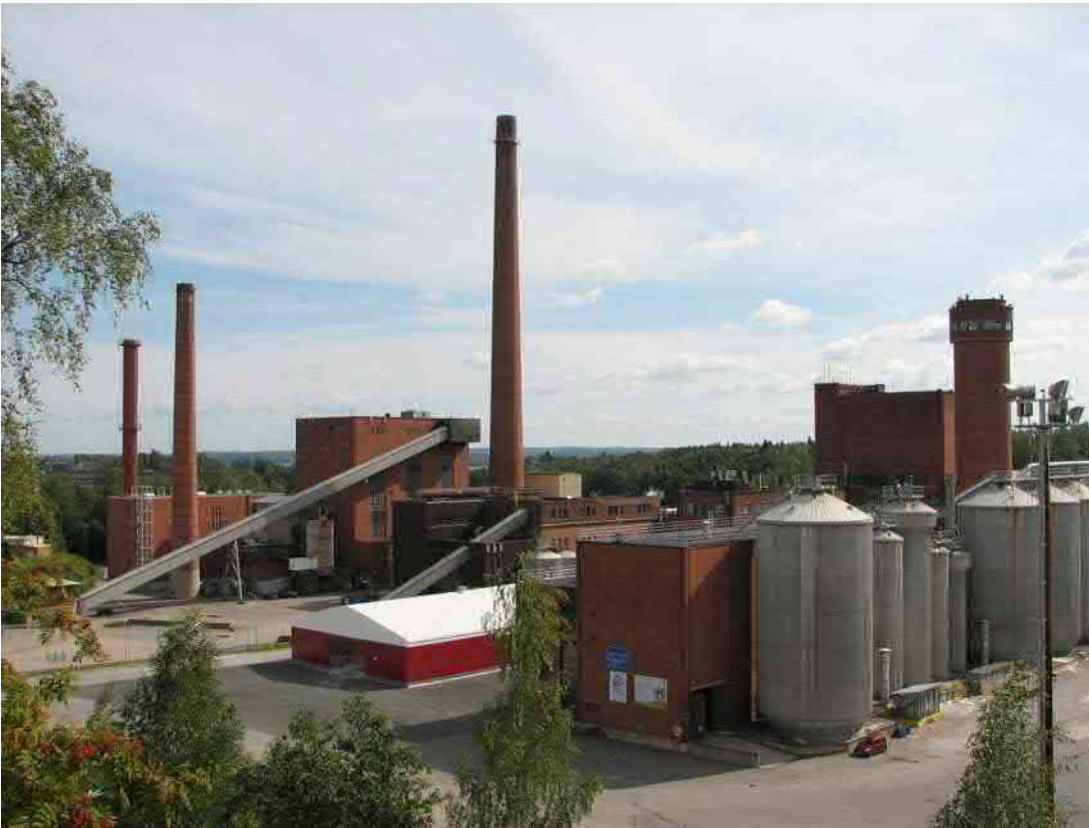
Kuva: Voimalaitoksen ja selluloosatehtaan rakennuksia
