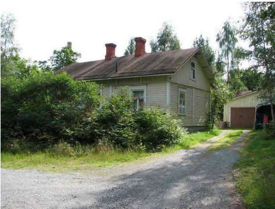
Kuva: Asuinrakennus ja talousrakennus.
