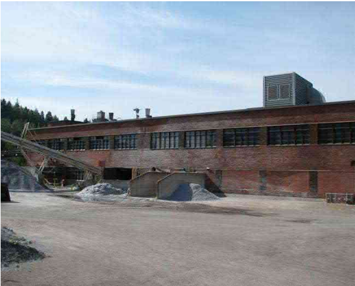
Kuva: Sellun ylösotto- ja varastorakennuksen itäjulkisivua. Vuoden 1956 vaiheilla valmistuneen rakennusosan ensimmäisen kerroksen ikkuna-aukot on muurattu umpeen.
