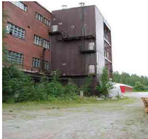
Kuva: Tislaamon ikkunat purettiin niiden alkaessa putoilla.
