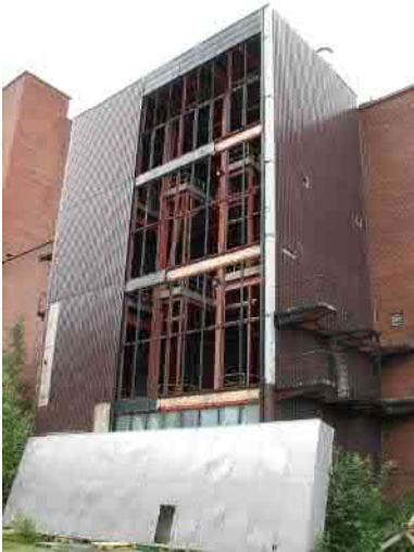
Kuva: Tislaamon ikkunat purettiin niiden alkaessa putoilla.
