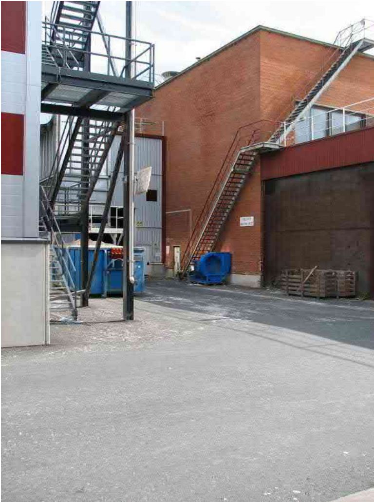
Kuva: Koepaperihallin pääty, profiilipeltinen julkisivu näkyy P12 ja P5 välissä.
