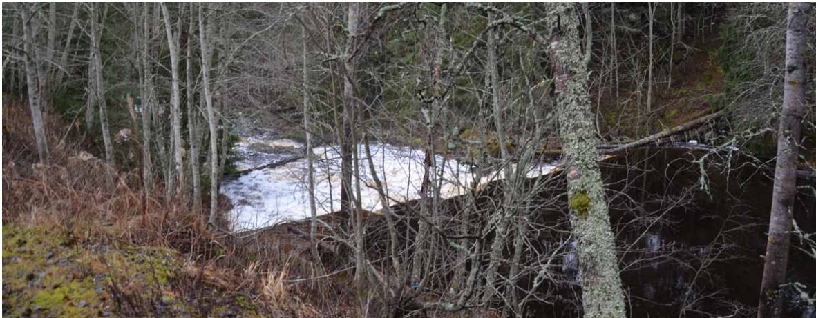
Kuva, sahan tasoitetun penkereen päältä otettu kuva, etualalla myllylampi ja pato.
