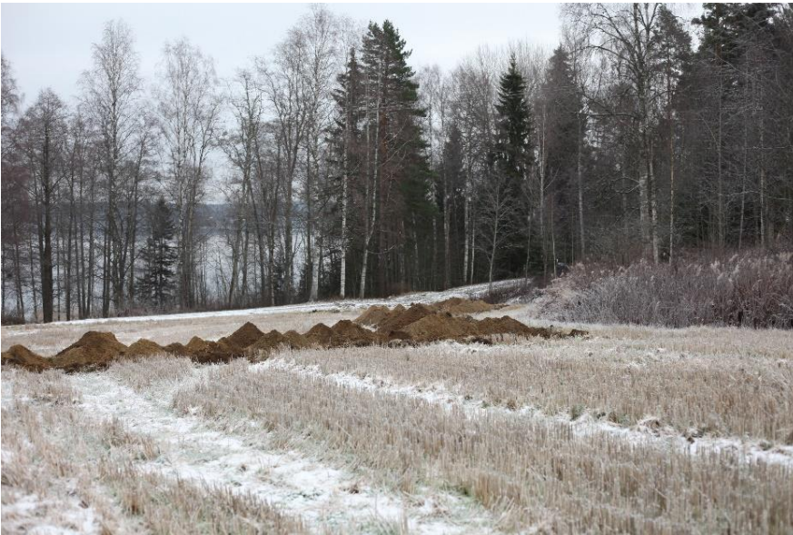
AKDG6152:2. Myllyoja, valvotun kaapelikaivannon itäosa ja vanha tielinja. Kuvattu lännestä. Kuvaaja Tuija Väisänen.
