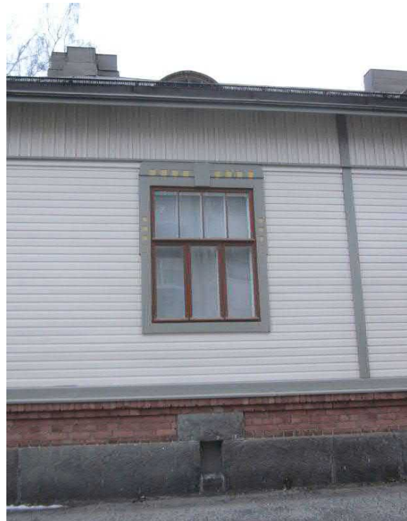
KYY 172 : 155 Asunto Oy Puuseppien Talon Kankurinkadun puoleisen julkisivun ikkunan koristelut ovat jugendille tyypillisiä. Mirrku Haapasaari 31.01.2016
