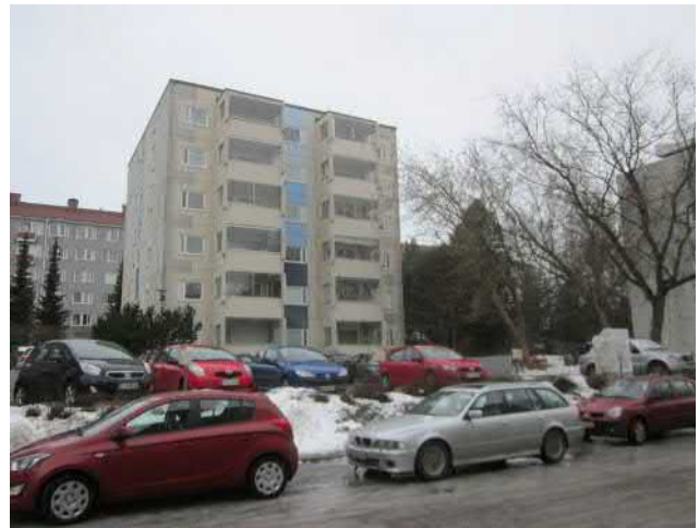
KYY 172 : 138 Asunto Oy Amurinmäki, A-rakennus ja sen edustalla Kankurinkadun puolella oleva parkkialue. Mirkku Haapasaari 31.01.2016
