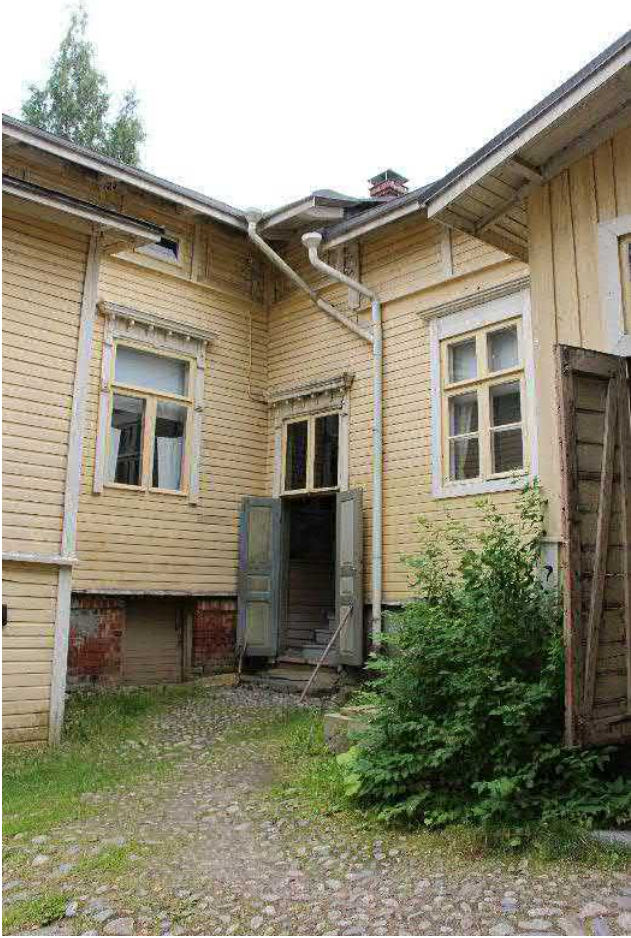
Asunnot vuosilta 1911-1939, sisäpiha, Makasiininkadun ja Mariankadun kulma Kuvattu luoteesta Miia Ryttyläinen
