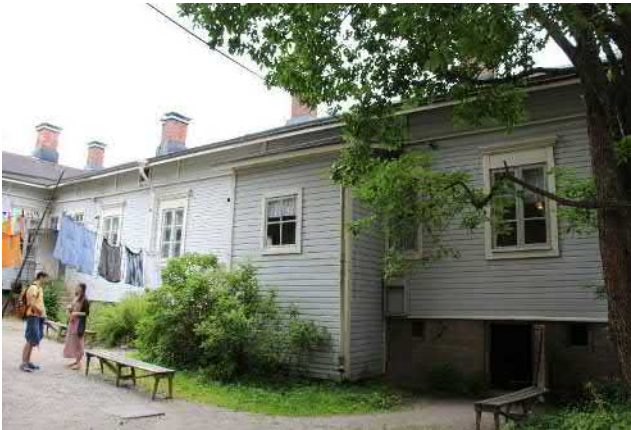
Asunnot vuosilta 1932-1973, sisäpiha, Saarikujan puoli Kuvattu koillisesta Miia Ryttyläinen
