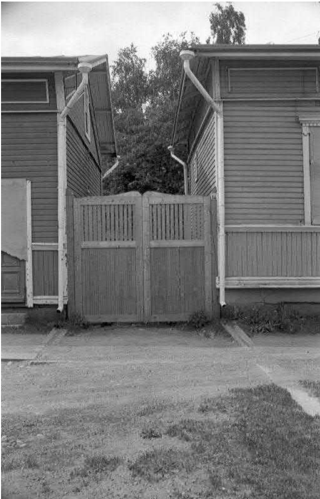
48 : 1 Amurin työläismuseokorttelin pohjoisten tonttien rakennuksia ennen korjaustöiden alkua, portti Mariankadulle
