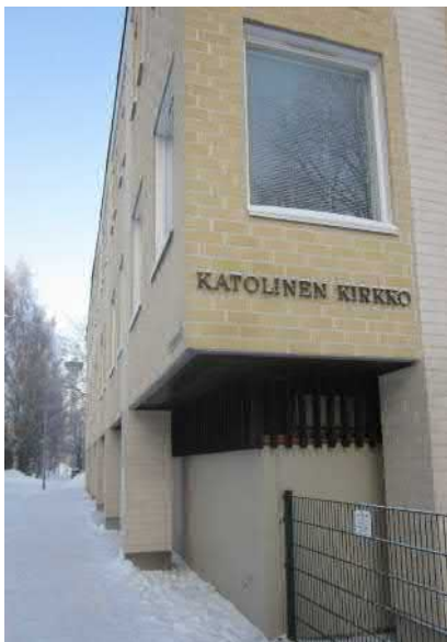
KYY 172 : 151 Tampereen katolisen seurakunnan Pyhän ristin kirkon lounaisnurkkaa. Julkisivuremontissa ulomman betonipilari- palkkiristikon ja syvemmälle asettuvien klinkkerikenttien tasoerot ja materiaalivaihtelut on hävitetty. Koko julkisivu on lähes samassa tasossa ja verhoiltu tiilellä. Myös maantasokerroksen sisäänvedetyt betonipilarit on tuotu ulospäin samaa tasoon ylempien kerrosten julkisivupinnan kanssa. Tummapuitteiset ikkunat on vaihdettu valkosiin. Mirrku Haapasaari 16.01.2016
