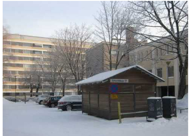
KYY 172 : 101 Asunto Oy Amurinkulman jätekatos Amurinkujan laidassa. Kuvan oikeassa laidassa Pyhän Ristin seurakunnan kirkko. Mirkku Haapasaari 16.01.2016
