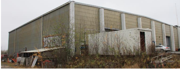
Kuva 27. Teurastamon pakkasvaraston radan puoleinen osa on levy pintainen ja kantavan rakenteen pilarit jäsentävät julkisivua.
