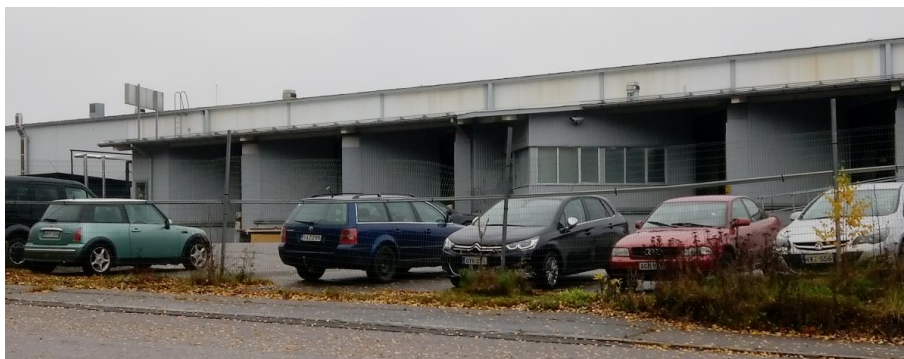
Kuva 26. Vuonna 1990 valmistunut itäpäädyn laajennus on vaalea levy pintainen rakennus, jonka julkisivuja rytmittää lastauslaiturit.
