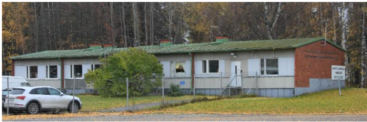
Kuva 27. Teurastamon pakkasvaraston radan puoleinen osa on levy pintainen ja kantavan rakenteen pilarit jäsentävät julkisivua.
