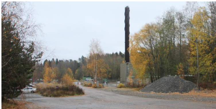
Kuva 37. Näkymä Kolismaankadun päästä. Vasemmalla ajoyhteys Nokian NPT Oy:n pihalle, vasemmalla ajoyhteys Kaukokiidon pihalle ja lämpövoimalalle.
