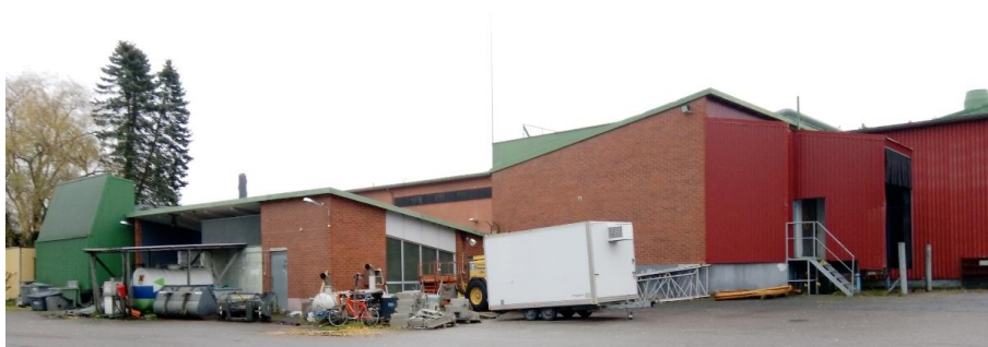
Kuva 23. Luoteisjulkisivulla alkuperäisen ilmeensä on säilyttänyt matala, lapekattoinen lämpökeskus. Ikkunoiden yllä on vaalea levytys. Teurastamon alkuperäisessä lounaisjulkisivussa oli myös käytetty vaaleaa mineriittilevytystä.
