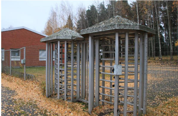
Kuva 30. Entisen teurastamon tonttia rajaa edelleen verkkoaita. Työntekijöiden kulkuportit toimistorakennuksen vieressä eivät ole enää käytössä.
