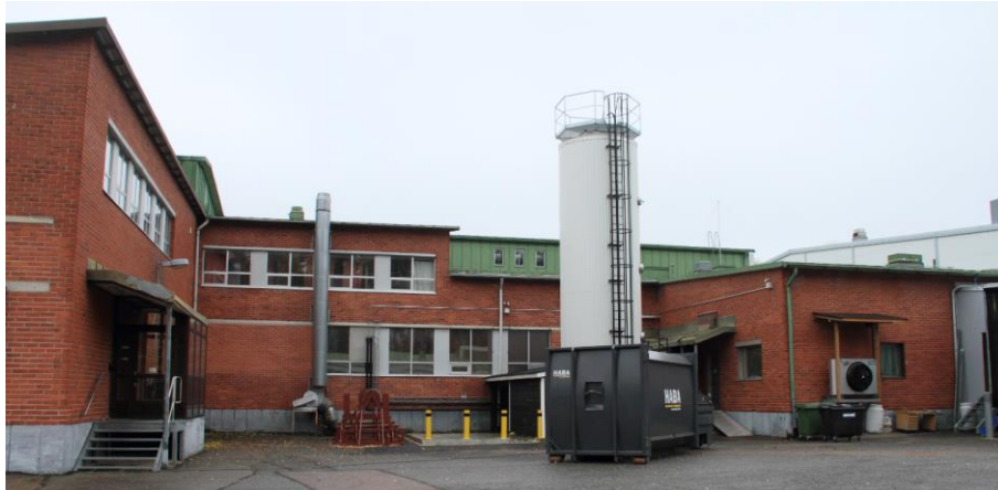
Kuva 22. kaakkoisjulkisivun keskivaiheilla on vielä hahmotettavissa entisen teurastamon alkuperäistä ilmettä. Alakerran ikkunarivistä on muurattu kaksi ikkunaa umpeen. Ikkunoiden takana sijaitsi alkujaan teurastushalli ja laboratoriotiloja. Yläkerroksen ikkunarivit ovat säilyttäneet alkuperäisen asunsa. Teurastushallin päällä sijaitsi työntekijöiden sosiaalitiloja ja kuvan vasemman reunan ikkunarivin takana toimistotiloja.
