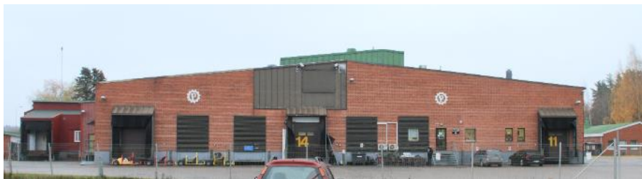
Kuva 24. Lounaispäädyn laajennus on vuodelta 1983. Laajennus on toteutettu alkuperäisen teurastamon tapaan tiilipintaisena. Osa lastausovista on laitettu umpeen.
