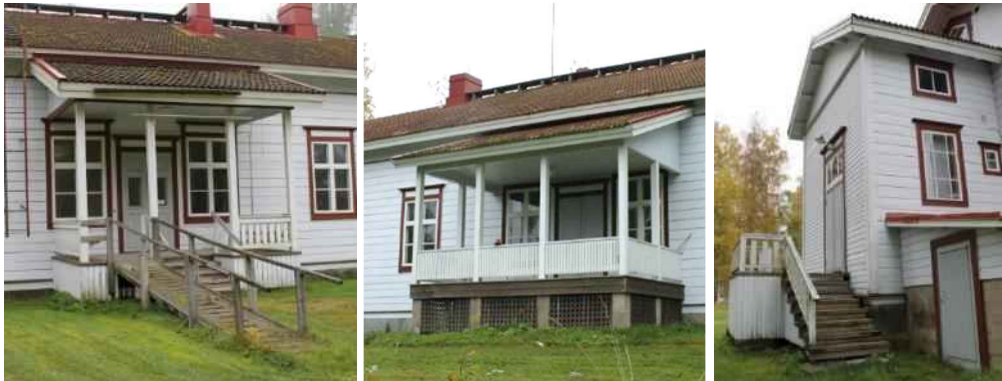
Johtolan sisäänkäynnit: vasemmalla pääsisäänkäynti, keskellä takaterassi ja oikealla keittiön sisäänkäynti.
