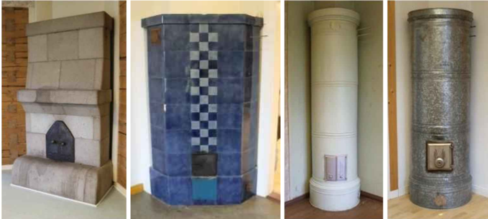
Suurimmassa huoneessa on suuri kiviuuni. Suurimman huoneen itäpuoleisessa huoneessa on sininen kaakeliuuni. Muut uunit ovat pönttöuuneja.
