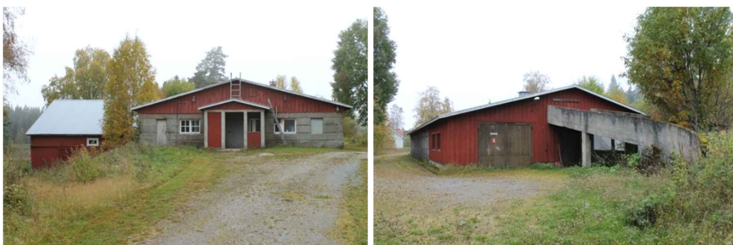
Vasemmalla navetan eteläjulkisivu ja oikealla takajulkisivu.
