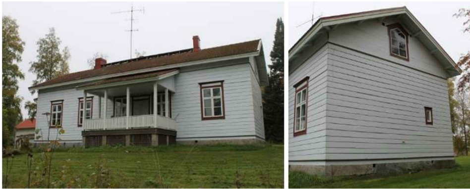
Vasemmalla julkisivu etelään ja oikealla julkisivu itään.
