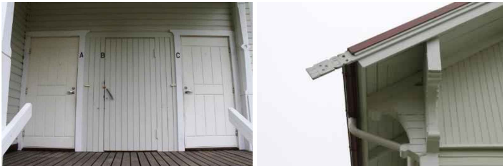
Ulko-ovet ovat uusitut.
