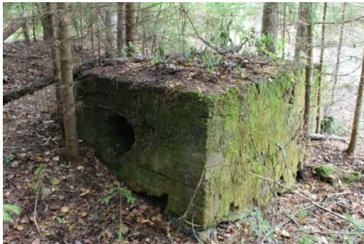
Saunarakennuksen länsipuolelle metsään sijoittuneen rakennuksen jäänteet ovat vielä selkeästi näkyvissä maastossa.
