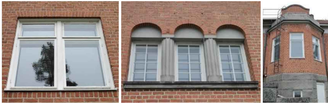
Ikkunat ovat pääosin vanhoja moniruutuisia puuikkunoita.
