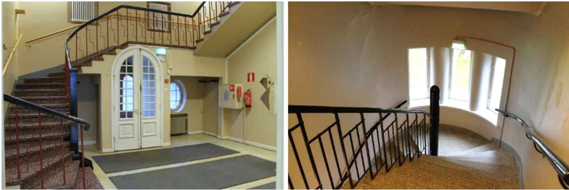
Mosaiikkibetoniportaita reunustaa punainen metallikaide, jossa on musta käsijohde. Vasemmalla on ensimmäisen kerroksen eteishalli ja oikealla rakennuksen länsiosan porrashuone.
