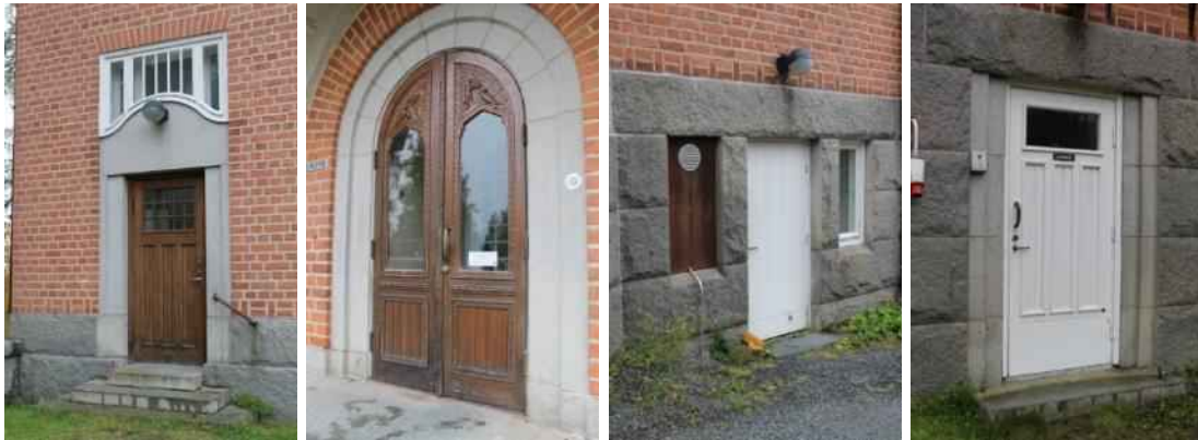
Ulko-ovet vasemmalta oikealle: Etupihan sivusisäänkäynti, pääsisäänkäynti, länsipään kellarin sisäänkäynti ja itäpään kellarin sisäänkäynti.
