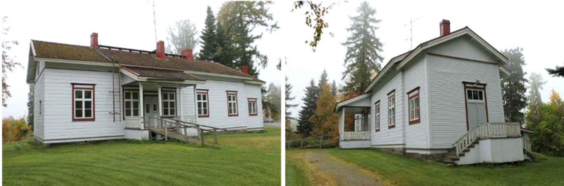
Vasemmalla julkisivu pohjoiseen ja oikealla julkisivu länteen.
