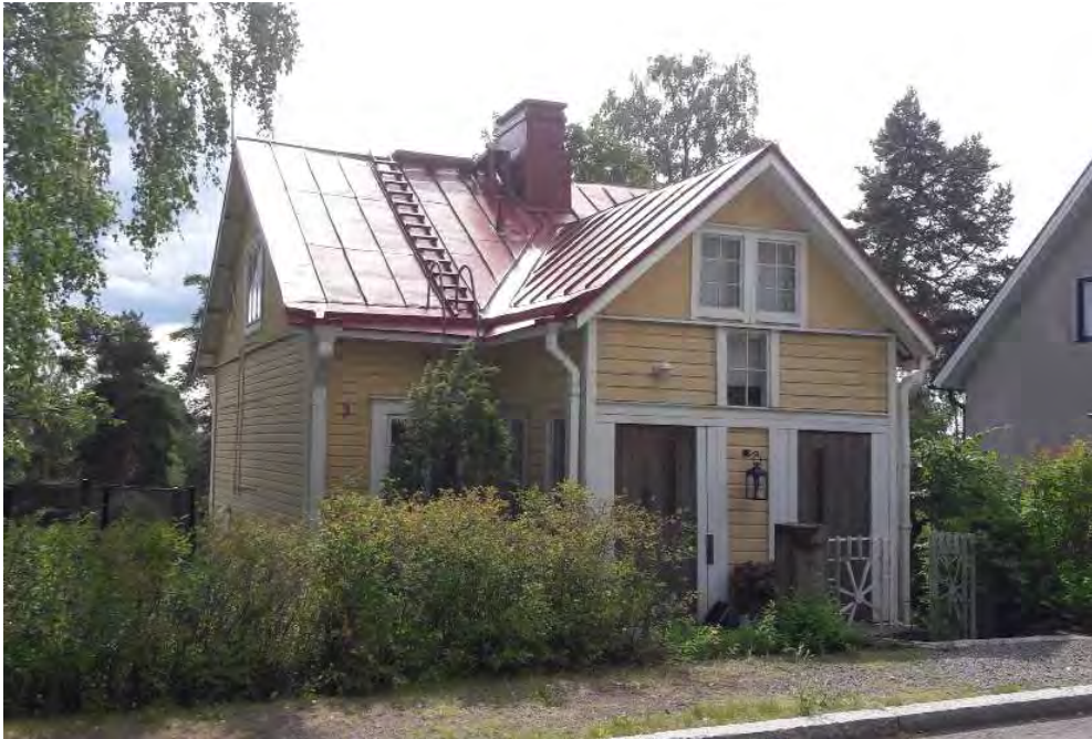
Risuharjankatu 3 talon rakennusvuodeksi on kirjattu 1927.
