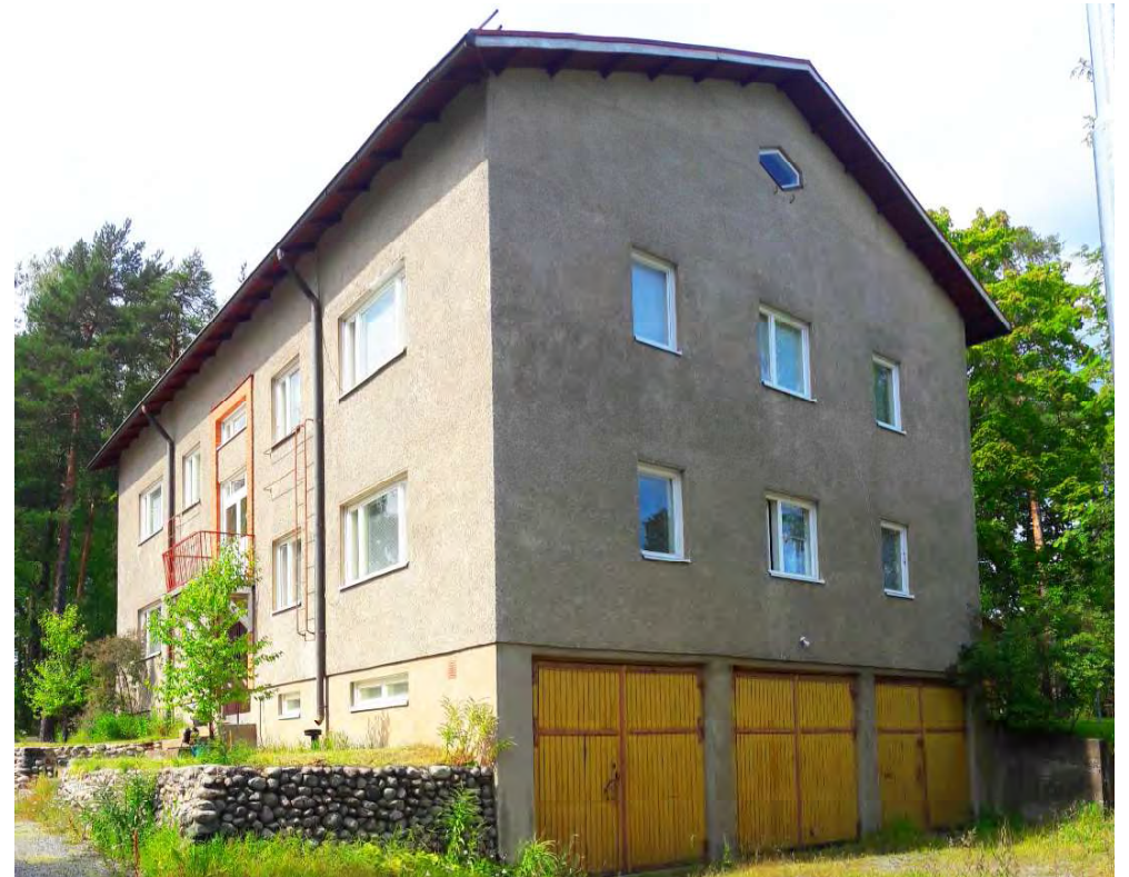
Jälleerakentamiskauden pienkerrostalo vuodelta 1955, joka on säilyttänyt hyvin alkuperäisen ilmeensä. Osoite: Risuharjunkatu 4.
