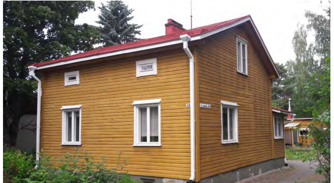
Tyypillisessä jälleenrakentamisaikakauden talossa kattokulma on loivempi ja runkosyvyys hieman suurempi kuin palstoittamalla syntyneissä. Kuvassa Ketostenkatu 26 rakennus, joka on vuodelta 1944.
