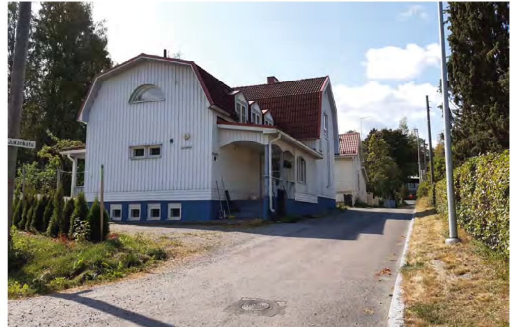
Jukankatu 1: Lamminpäässä esiintyy monenlaisia talotyyppejä, mutta kuvan kaltaisia pitkänmallisia rakennuksia ei ole monia.
