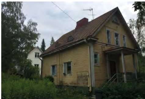
Peruskorjausta vaativassa kunnossa oleva talo vuodelta 1925, Sudenkatu 37.
