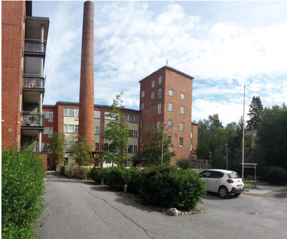
Epilän teollishistoria on kauniisti näkyvillä mm. vanhoista Nahkatehtaan rakennuksista kunnostetuissa asuinkehteissä. Kuva on osoitteesta Nahkatehtaankadusta 5.
