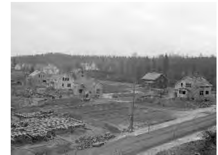
1950-lukujen talojen rakentamista Taatalassa. Kuva: Vapriikin kuva-arkisto. Ensio Kauppi.
