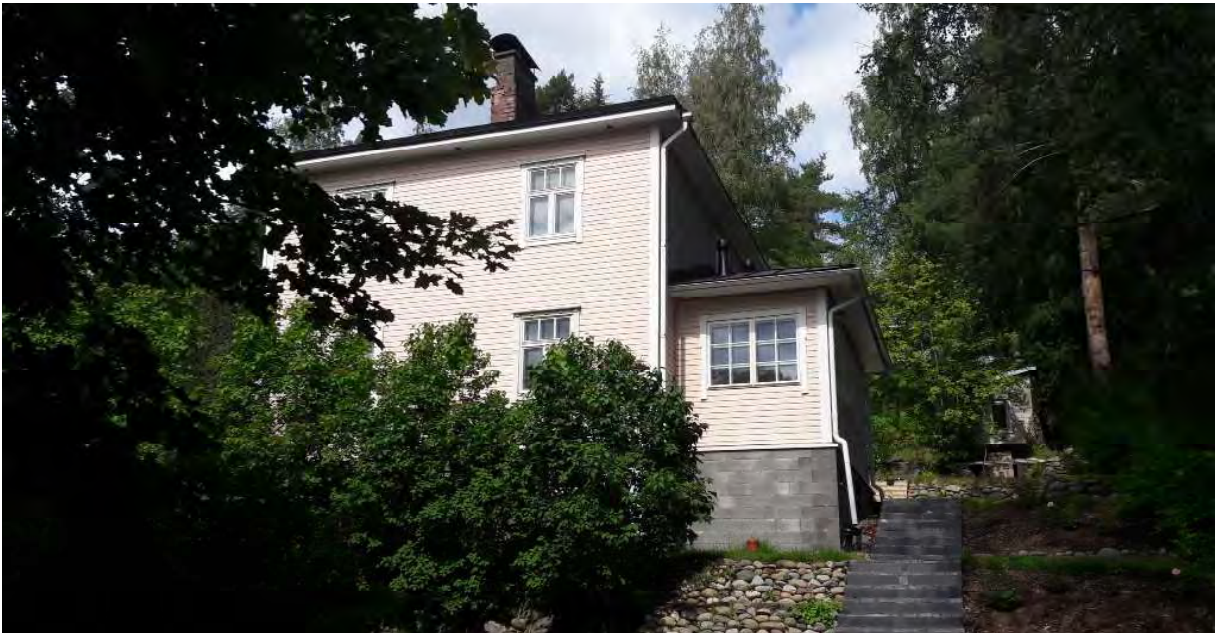
Nokiantie 66 edustaa 1920-luvun aumakattoista noppatalotyyppeä, jollaisia Raholasta löytyy pari. Rakennuksen valmistusvuodeksi on merkitty 1926.
