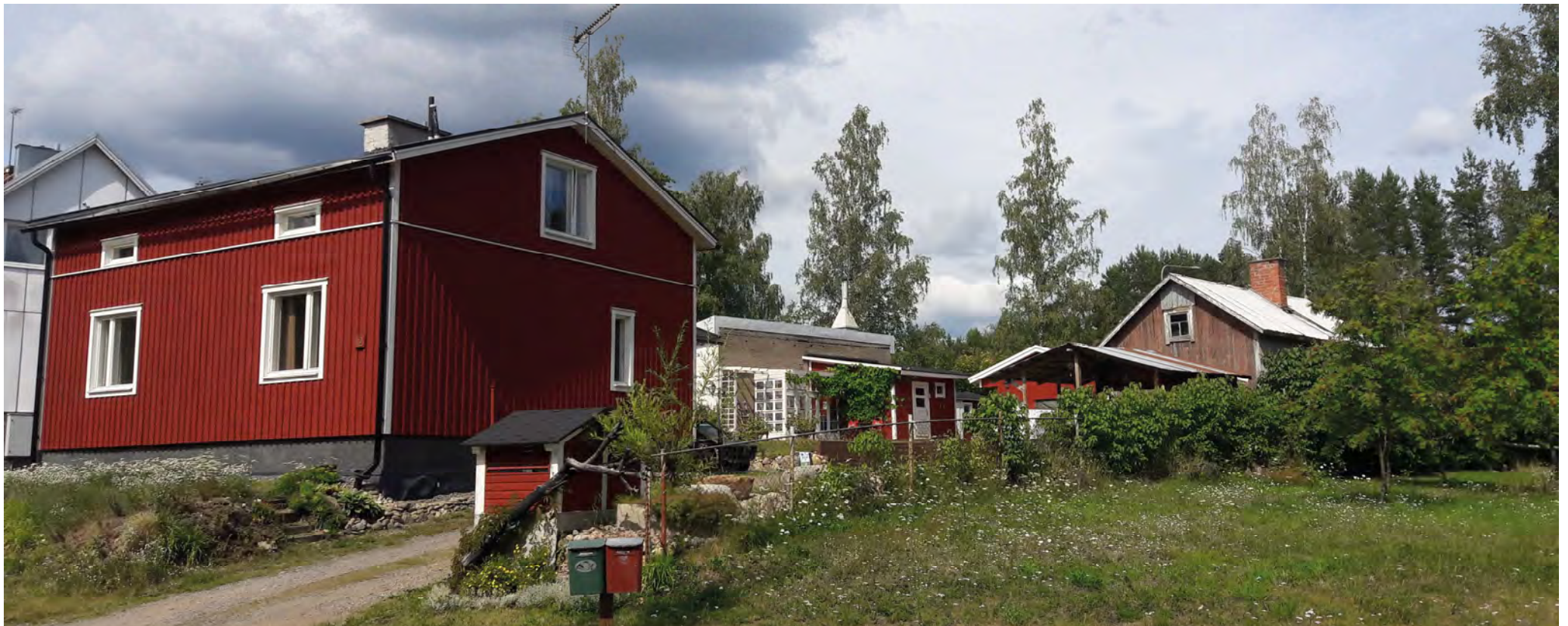
Ketostenkatu 12 pihapiirin rakennukset ovat tunnetuilta osin 1940-luvulta.
