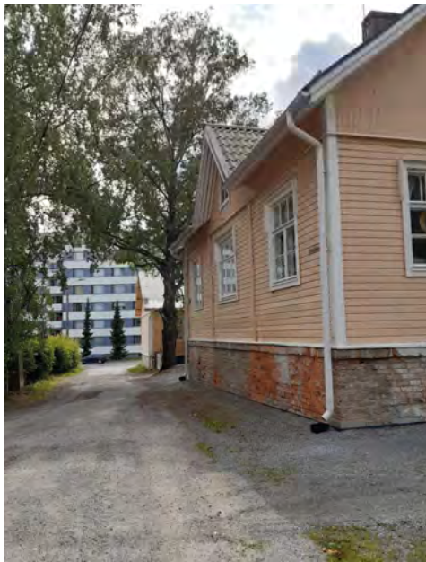
Sorsantaival: rakennukset on rakennettu kiinni katuun
