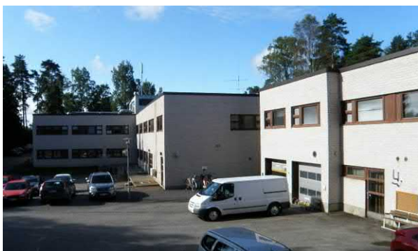
Laajennusosat vuosilta 1980 ja 1982.
