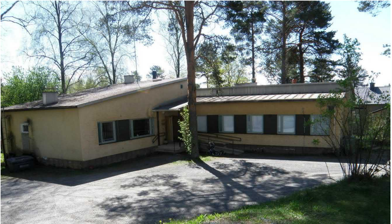
Lääkärintalo 2/ eläinlääkärintalo, sisäpihan puoli.
