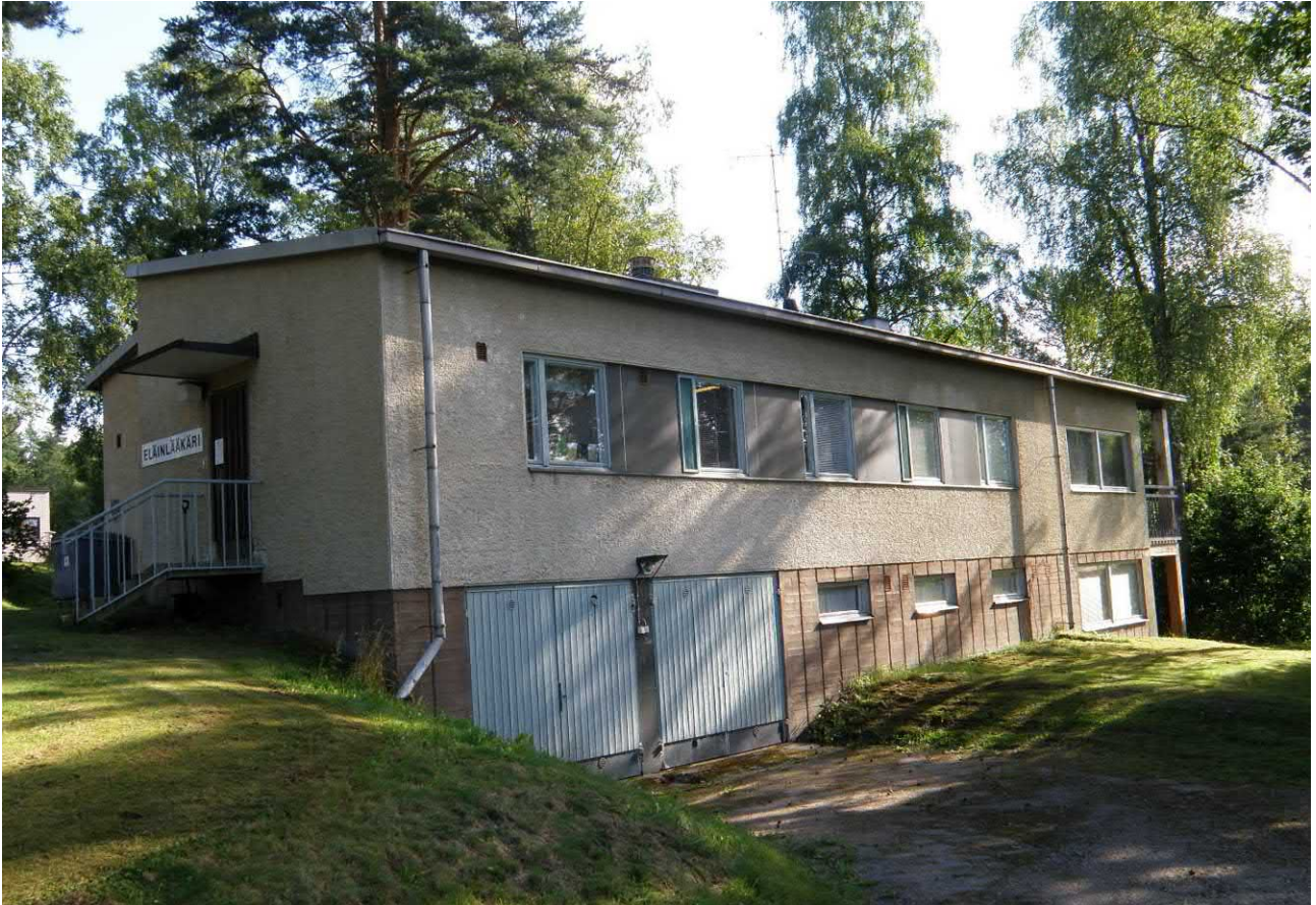
Lääkärintalo 2/ eläinlääkärintalo, eteläpuoli.
