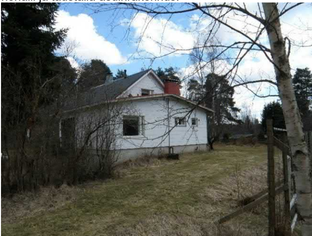
Asuinrakennuksen yksikerroksinen laajennusosa.
