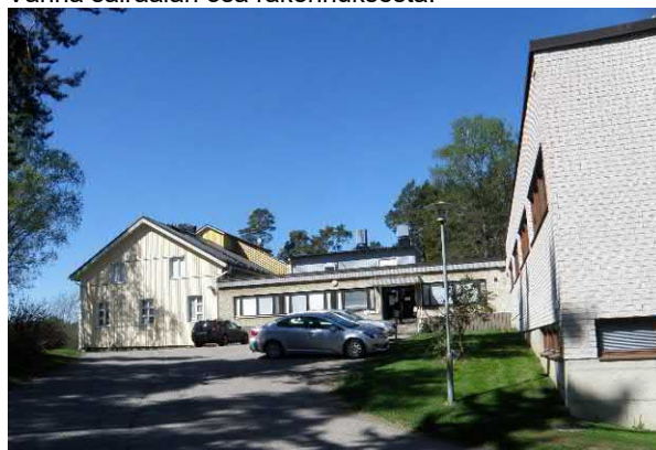
Vuonna 1965 valmistunut laajennus oikealla ja vanhin osa vasemmalla.
