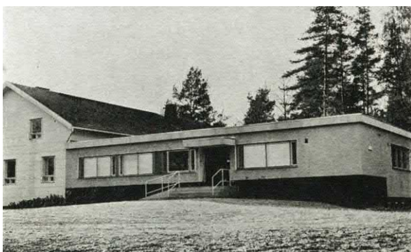
Kunnansairaalan laajennusosa. Suunnittelu Arkkitehtitoimisto Martas. Valmistunut v. 1965. Kuva Urjalan kunnalliskertomuksesta vuodelta 1968.
