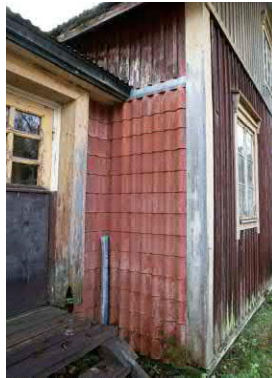
Julkisivuja on paikattu Asuinrakennuksen ikkuna. kattotiilillä ja levyillä.
