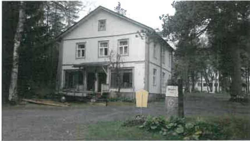
Talon Kuttilallionkujan puoleinen julkisivu
