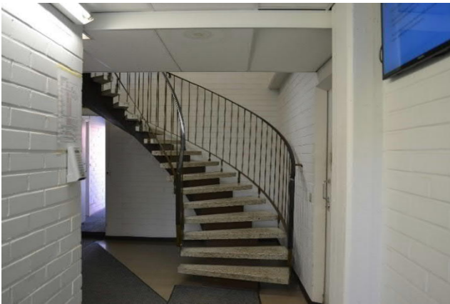
Portaikko ensimmäisestä toiseen kerrokseen (ylh.) ja näkymä toisen kerroksen toimistokäytävään (oik.)
