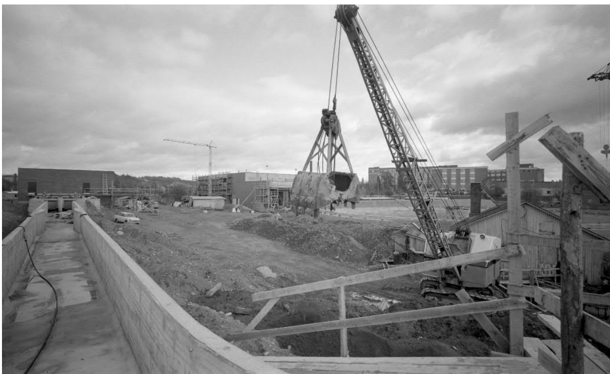
Jätevedenpuhdistamon rakennustyöt. KUVA Timo Palm 7.10.1971/Vapriikin ka.
