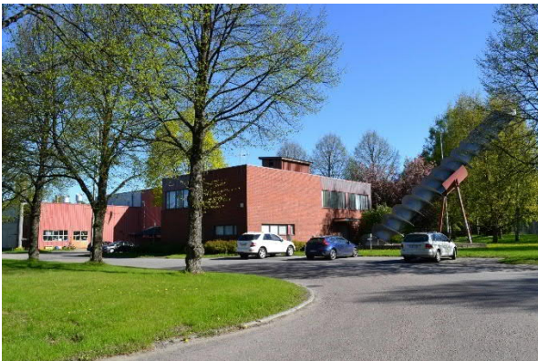
Arkhimedeen ruuvi alueen sisäänajotien suunnasta. Ruuvi on asennettu 40 asteen kulmaan, mutta tiedossa ei ole, perustuuko tämä pumppuruuvien alkuperäinen käyttökulmaan.
