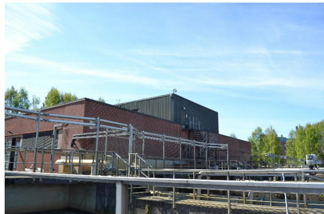
Näkymä ilmastusaltailta. Julkisivua hallitsee korkea tuuletustila.
