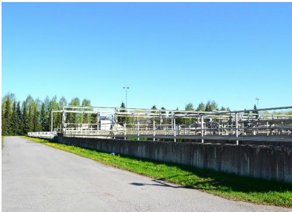
Näkymä lännestä ilmastus- ja jälkiselkeytyksaltaille, uusin laajennusosa.
