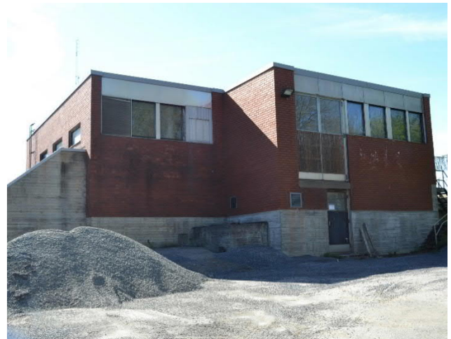
Takajulkisivu Pyhäjärven suuntaan pohjoiseen.
