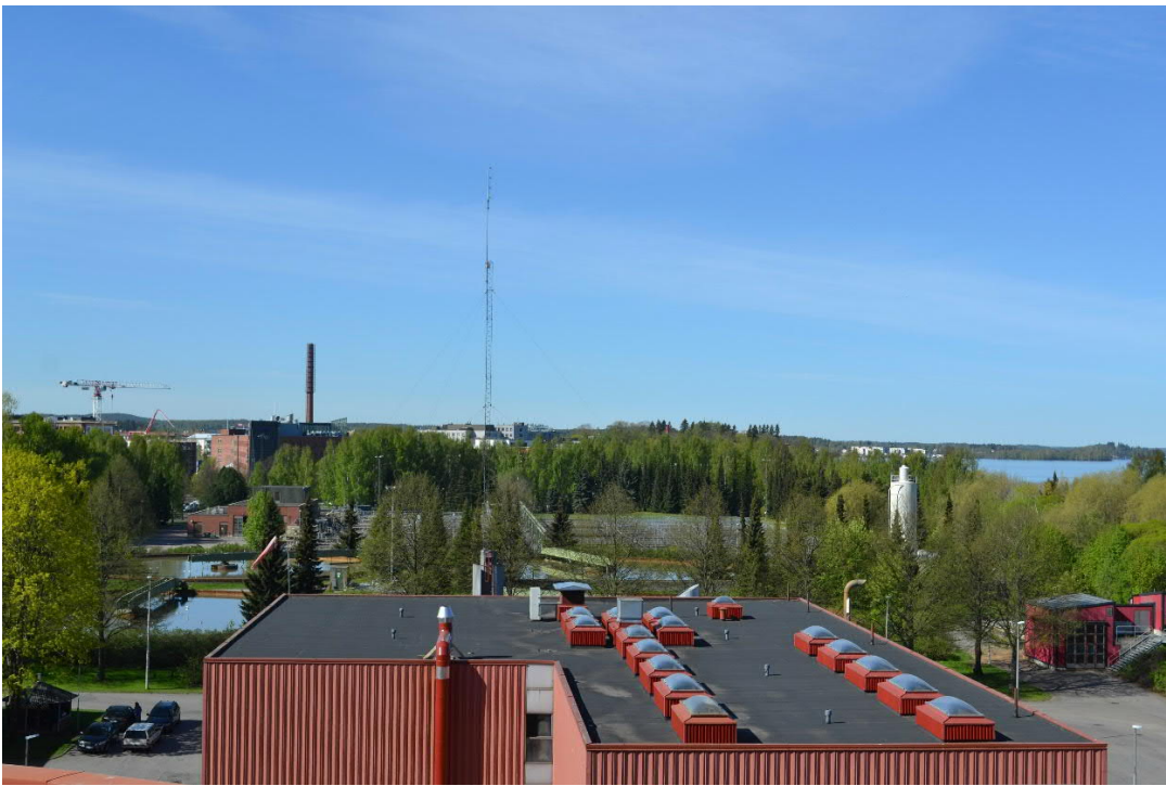
Näkymä madättämön katolta kohti lietteenkäsittelylaitosta. Puhdistamon ensimmäiseen rakennusvaiheeseen kuuluva laitos sijaitsee alueen ytimessä.
