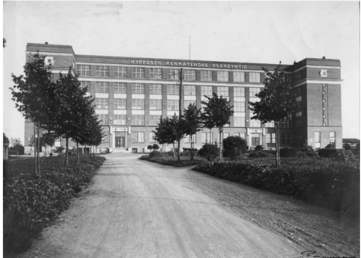
Tehdasrakennus 1910-/20-luvulla. KUVA Vapriikin kuva-arkisto.
