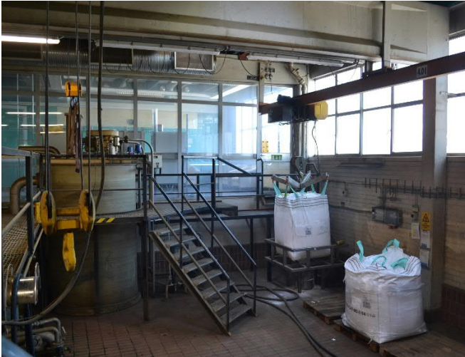
Suodatinpuristamo on toisen kerroksen suurin tila, josta ikkunarivi pohjoiseen. Säkeissä jauhemaisia kemikaaleja. Väliseinän takana entinen valvomo.
