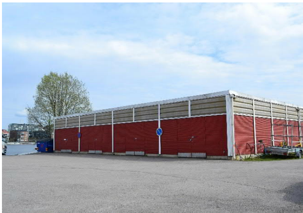
Kalustovajan länsisivu Soutukeskuksen pihalle.
