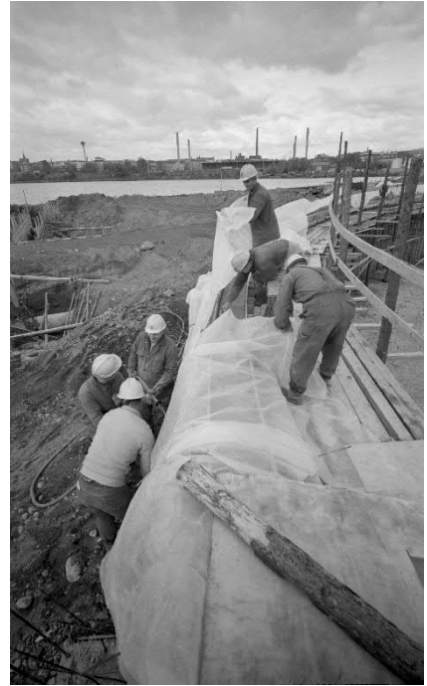
Hiekanerottamo, välppäämö ja lietealtan reuna rakenteilla. KUVAT Timo Palm 7.10.1971/Vapriikin ka.
