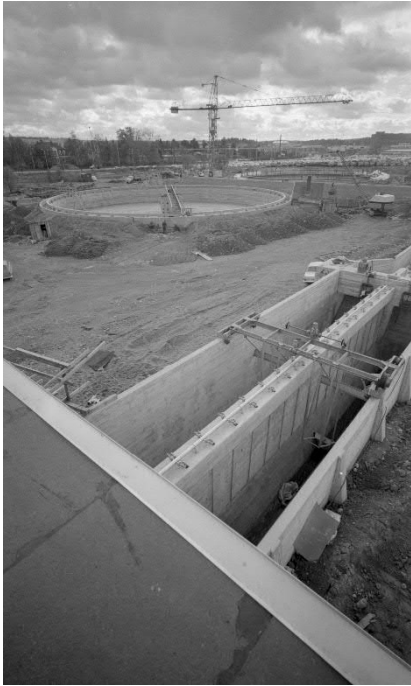
Hiekanerottamo, välppäämö ja lietealtan reuna rakenteilla. KUVAT Timo Palm 7.10.1971/Vapriikin ka.
