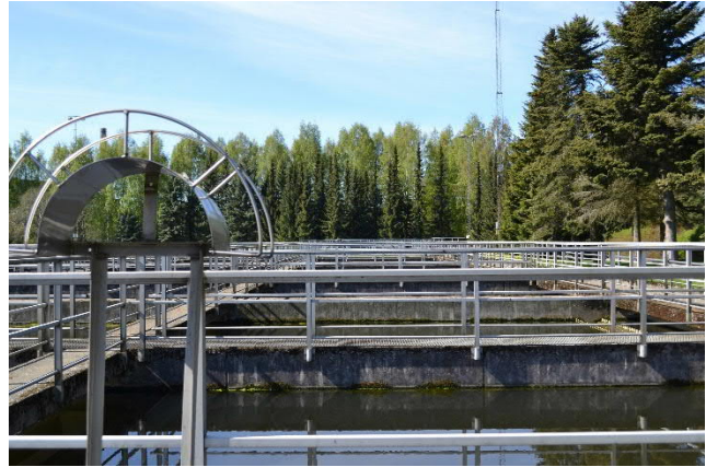
Näkymä jälkiselkeytyksaltaiden yli länteen.
