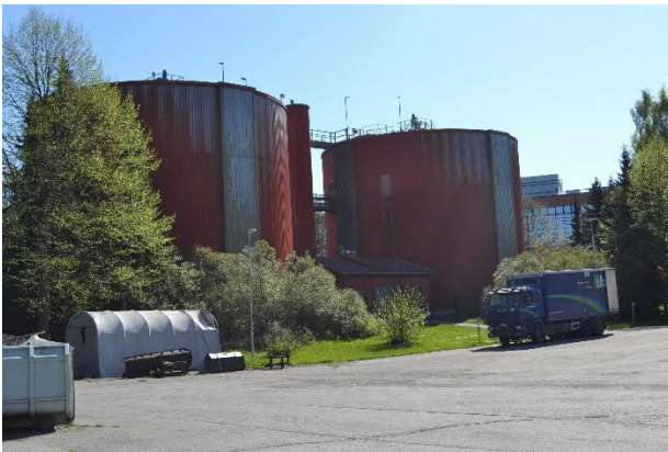
Mädättämön säiliöt hallitsevat näkymää puhdistamoalueen itäpäässä.
