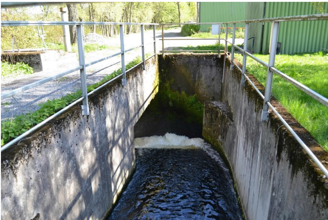
Puhdistettu jätevesi matkalla Pyhäjärveen. Poistokanavan pää on lähellä kemikaalilaitosta.
