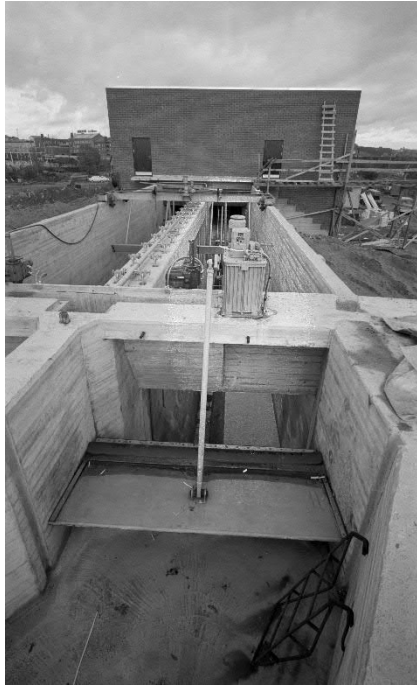
Hiekanerottamo, välppäämö ja lietealtan reuna rakenteilla. KUVAT Timo Palm 7.10.1971/Vapriikin ka.
