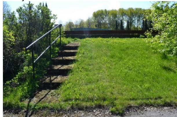
Betoniportaatt välppäämöltä selkeytsaltaille.
