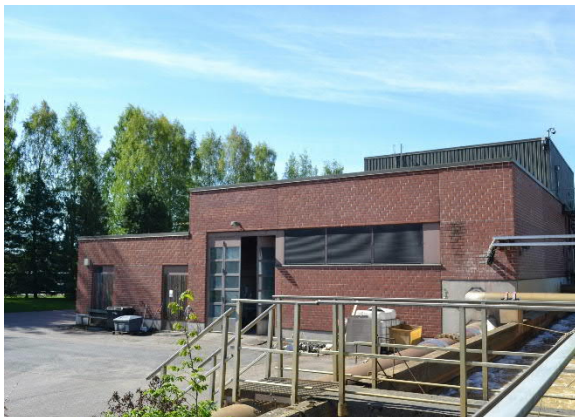
Näkymä koillisesta. Oikealla ilmastusaltaat.
