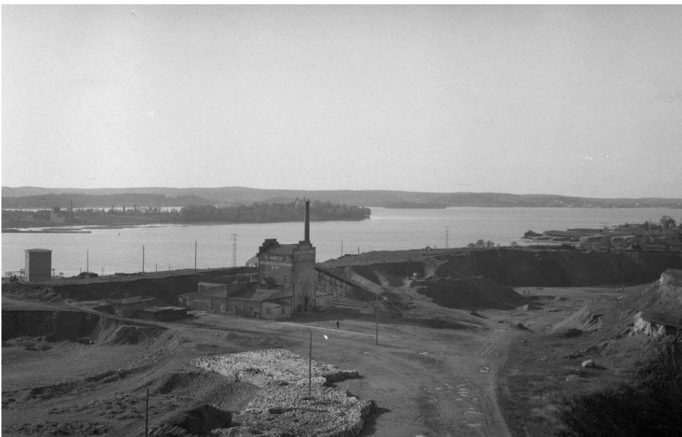
Hämeen Kalkkitiilitehdas O. Y:n rakennus Ratinanniemen eteläosassa vuonna 1932. Taustalla Hatanpään niemi kartanoineen. KUVA Teuvo Mäkinen/Vapriikin ka
