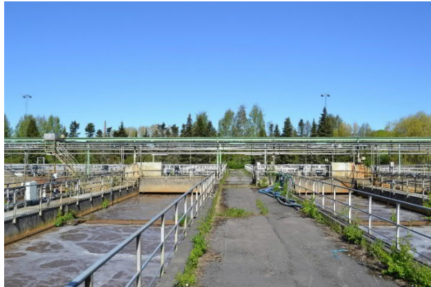
Näkymä ilmastusaltailta pohjoiseen kohti jäkiselkeytystä.
