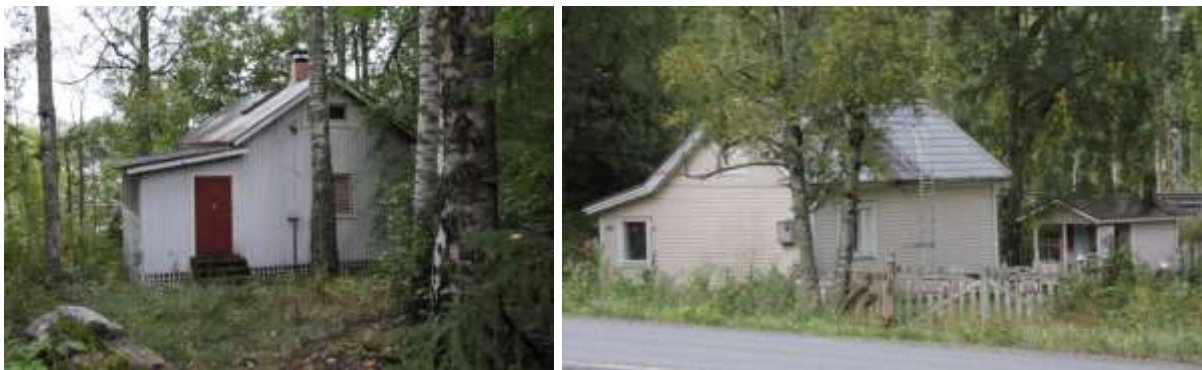
Kuva 11. Vasemmalla Niinikuruntie 11:ssä sijaitsee aivan radan varressa vaatimaton pikkumökki luultavasti itsenäisyyden alkuvuosikymmeniltä. Mökki on alueelle tyypillistä vaatimatonta rakennuskantaa, joka on liittynyt rautatieläisten asumiseen. Oikealla vastaava vaatimaton pikkumökki Tampereentien varrella (Tampereentie 469). 2707, 2781
