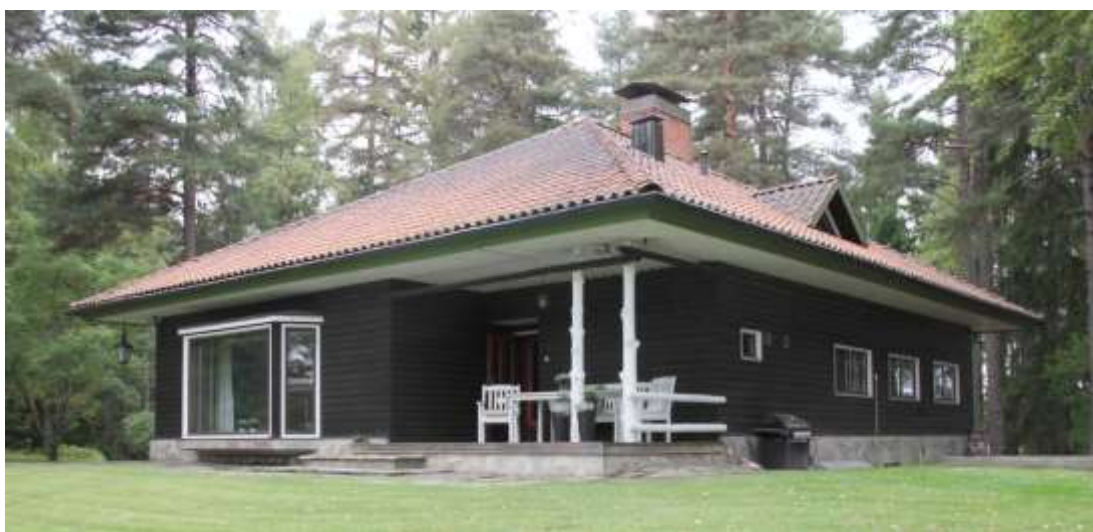
Kuva 131. Huvilan Nordenswanin kirkkoarkkitehtuurin mieleen tuovaa kattoa on korostettu leveillä räystäillä ja valkoisella aluslaudoituksella. Aluslautojen lomalaudoitus on sahattu koristeellisesti jiiriin kulmissa. Vihreät räystääslaudat liittäväät huvilan hienovaraisesti ympäröivään luontoon. 3396
