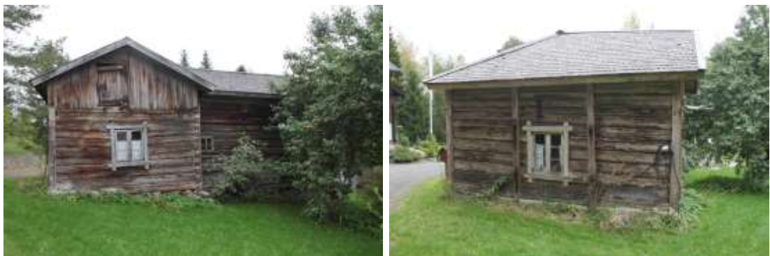
Kuva 127. Oikealla torpan eteläjulkisivu, vasemmalla länsijulkisivu. 3317, 3324
