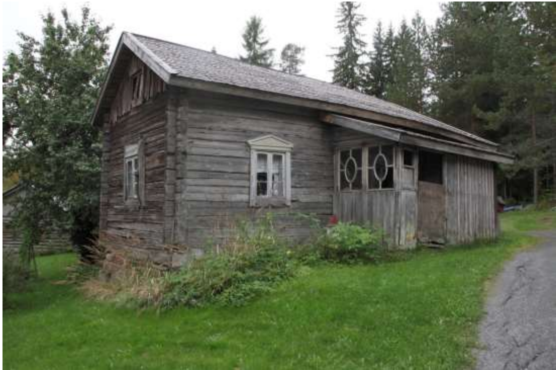
Kuva 126. Entisen torpan päärakennus, pohjoisjulkisivu. 3309
