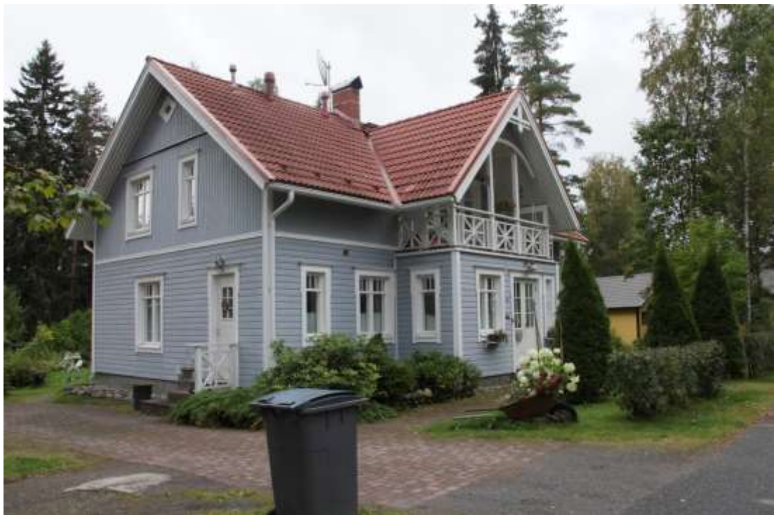
Kuva 25. Säöksjärventie 25 on huvilarakentamista jäljittelevä asuinrakennus vuodelta 2004. 2809
