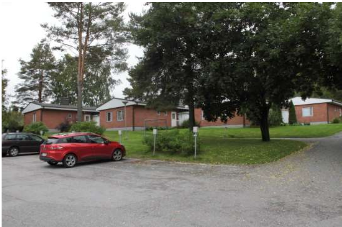
Kuva 87. Asuntokujan päässä on tavanomaista laadukkaammin toteutettu rivitaloyhtiö. Asunnot on porrastettu voimakkaasti toisiinsa nähden.
