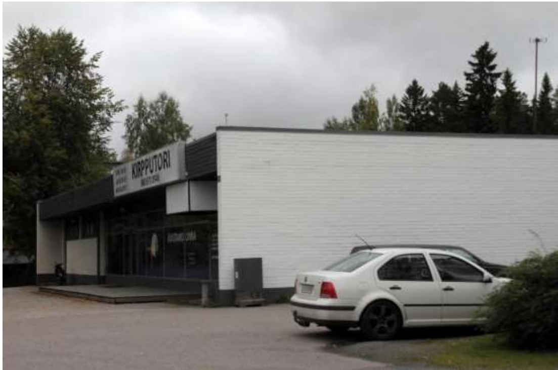
Kuva 91. Tampereentie 414 on kaupparakennus vuodelta 1967. Se on rakennettu samaan aikaan kuin Tampereentien varren kerrostalot. 3348
