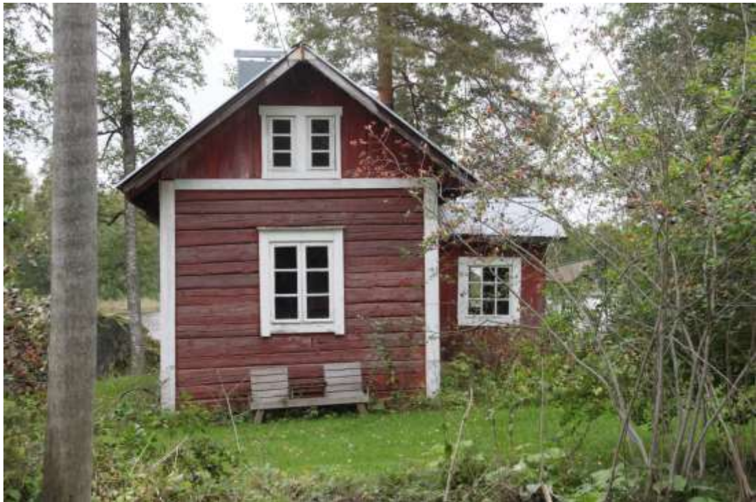
Kuva 122. Hirsirakenteinen pieni pirtti. 3278
