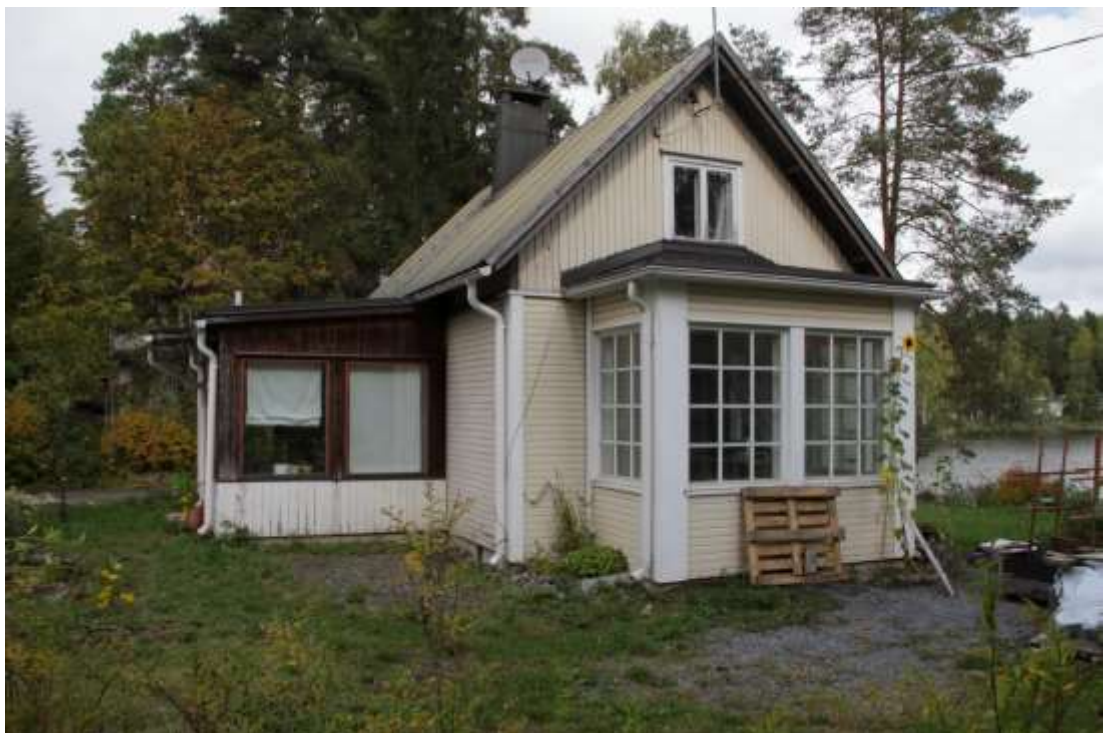
Kuva 60. Rotikonperä 10 on myös noin vuodelta 1930. Sen länsiseinustalle on myöhemmin rakennettu uusi kuisti. 3002
