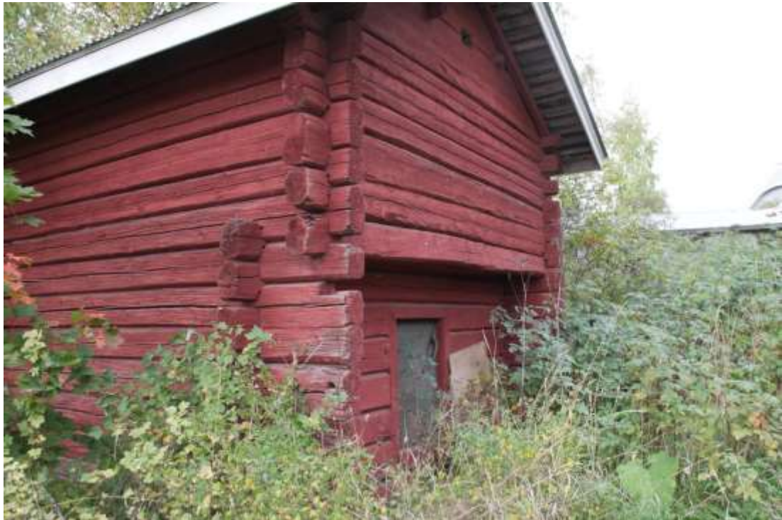
Kuva 139. Hirsirakenteinen aitta on siirretty paikalle. 3466
