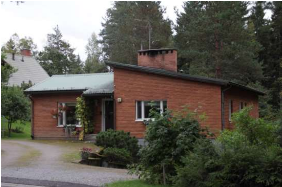
Kuva 53. Keissutien varrella on myös muutamia uudempia asuinrakennuksia. Keissutie 8 on tiilirakenteinen asuintalo vuodelta 1962. 3070
