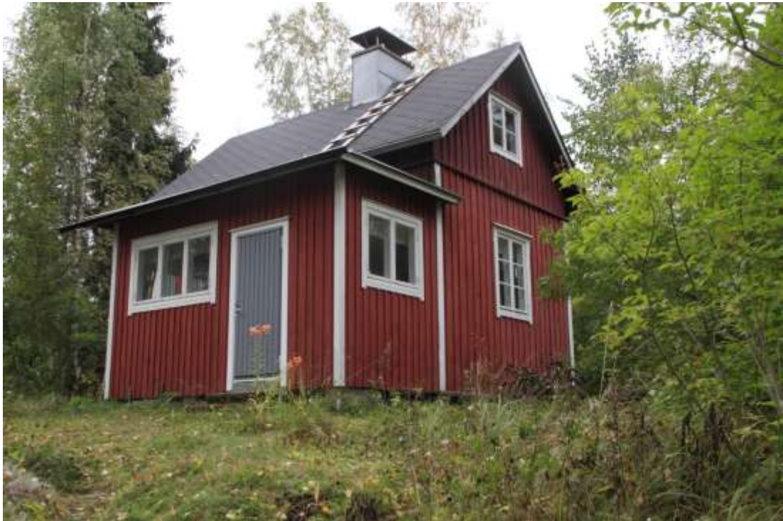
Kuva 123. Kohteen päärakennus on tontin korkeimmalla kohdalla. 3284
