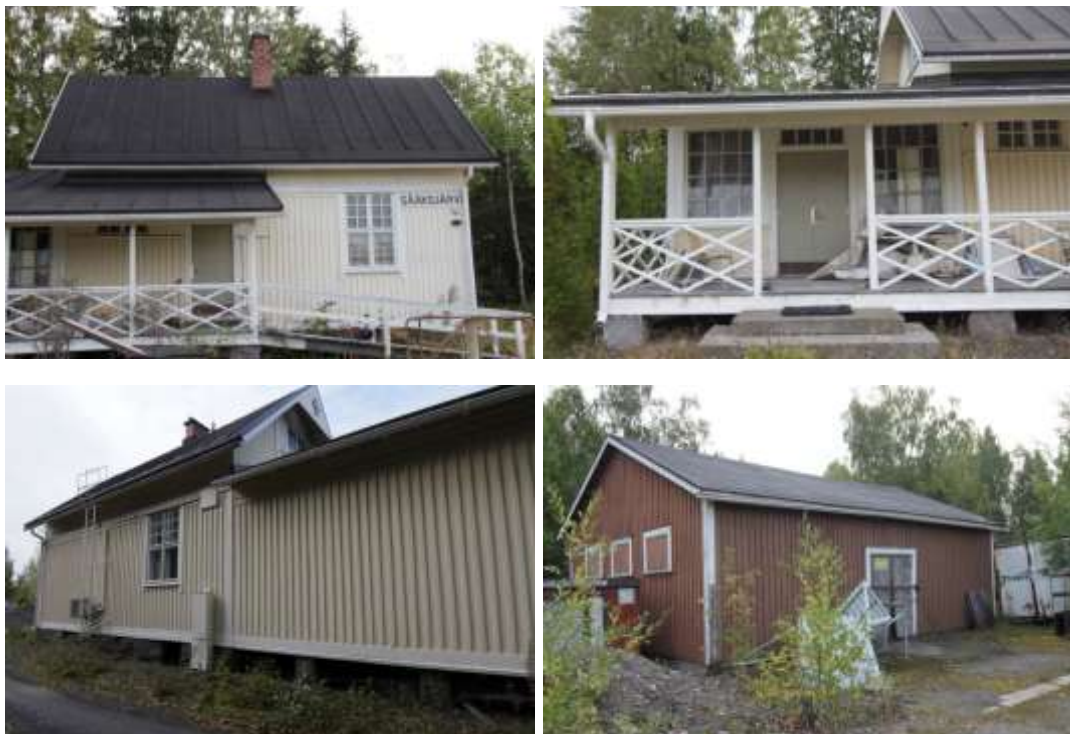
Kuva 16. Yläkuviissa asemarakennuksen radan puoleista julkisivua. Ylhäällä oikealla klassistinen laajennus 1920-luvulta. Alhaalla vasemmalla asemarakennuksen itäjulkisivu ja oikealla makasiinirakennuksen radanpuoleinen julkisivu. 2762,2750, 2753, 2756
