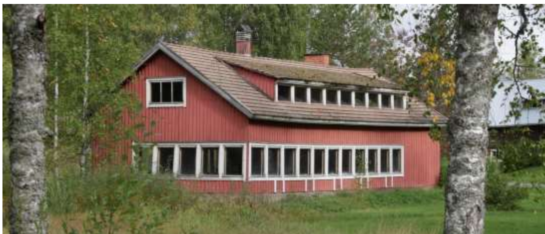
Kuva 46. 1960-luvun asuinrakennuksen pihapiirissä on talousrakennus. se on saanut rakennusluvan vuonna 1962 kanalaksi. Rakennuksessa on pitkä rivi ikkunoita ja myös ullakkokerroksessa on pitkä rivi ikkunoita kattolyhdyn alla.
