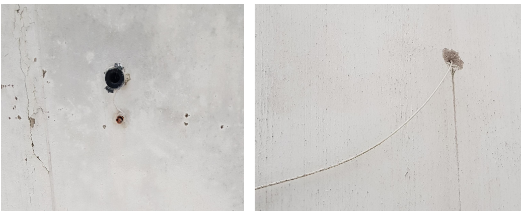
Kuvat 29 ja 30: Elementtiseiniin on tehty läpivientejä
