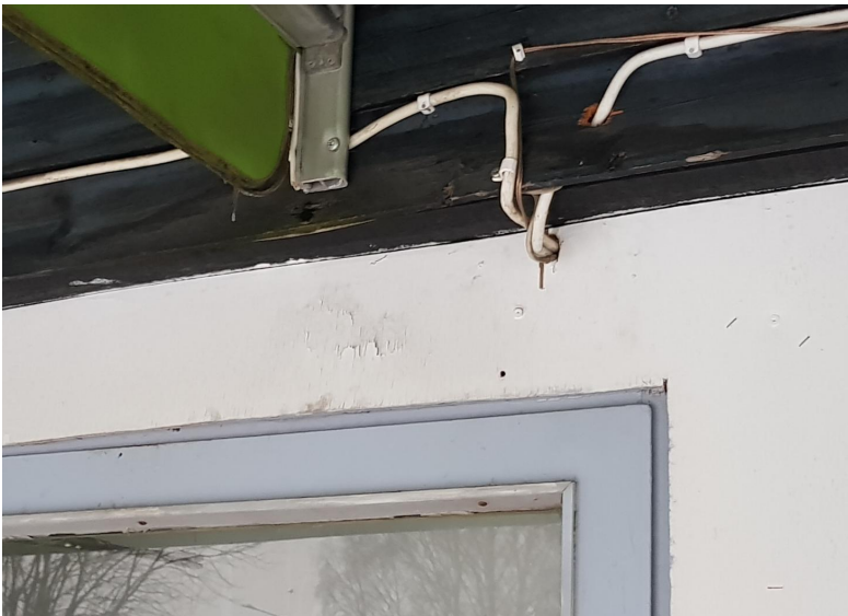
Kuvat 31 ja 32: Nauhaikkunoiden päälle asennettujen rakennuslevyjen läpi on tuotu sähköjohtoja. Läpivientejä ja kiinnityksiä on myös tummassa lautaverhouksessa
