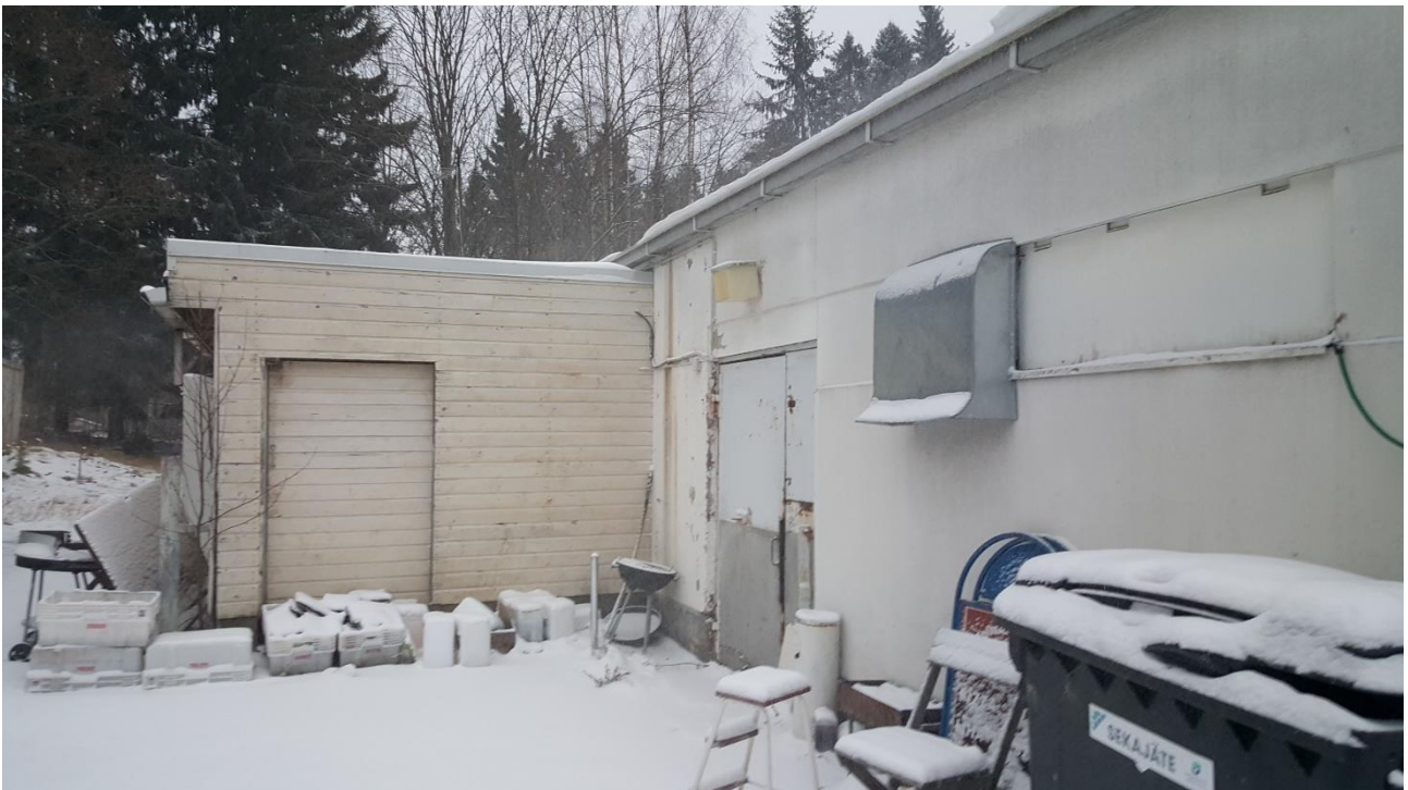
Kuva 20: Julkisivu länteen 23.11.2017. Myös rakennuksen takaosan nauhaikkunat on peitetty. Takaovi on alkuperäinen.
