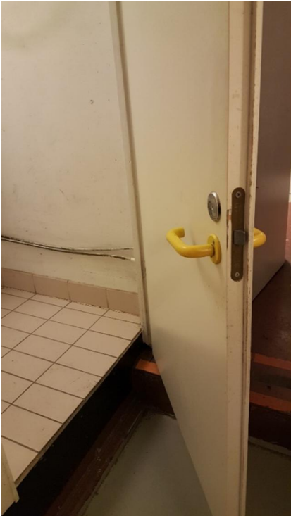
Kuva 51 (vasemmalla): WC-tilat on toteutettu jälkikäteen ja viemäroinnit tehty pintavetoina
