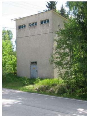
Kuva: Vanhan maantien varrella selkeän aikakauden kiintopisteen muodostava rapattu muuntajarakennus liittyy kunnan sähköistämiseen 1950-luvulla.
