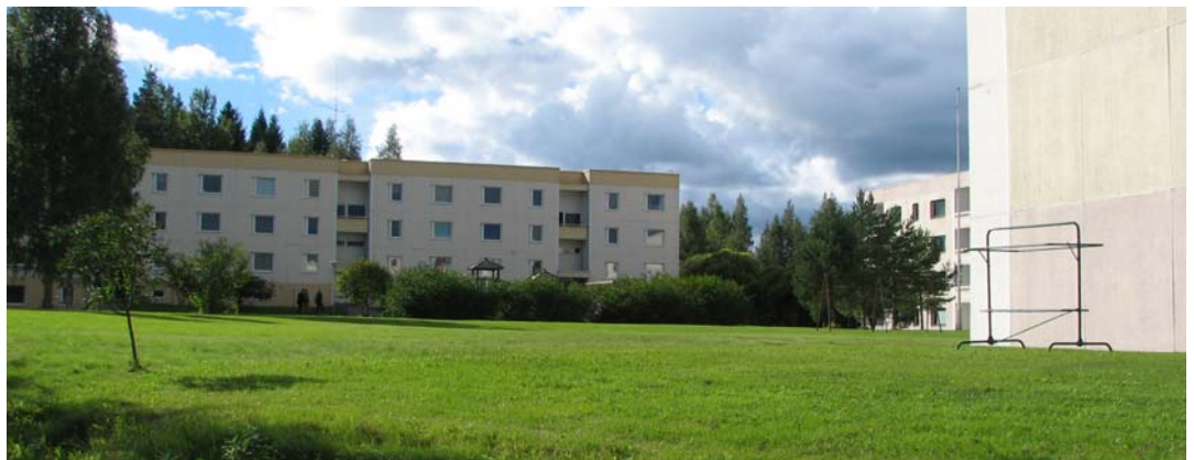
Kuva: Kallion kaupunginosaan kenkätehtaan viereen rakennetut Elokankaankadun kolme kerrostaloa edustavat jo 1970-luvun teollisempaa, julkisivultaan köyhempää elementtirakentamista. Väljästi rakennettuun alueeseen liittyy rakennusten väliin jäävä laaja puistomainen piha.
