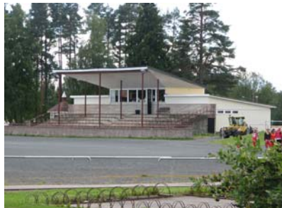
Kuva: Parkanon urheilukenttä rakennettiin 1950-luvulla ja katsomo valmistui hieman myöhemmin, mahdollisesti vasta 1960-luvulla. Pulpettikatto, sokkelin raakabetoni ja koristeurat, rautaputkikaiteet ja -pilarit edustavat ajan rakentamista.
