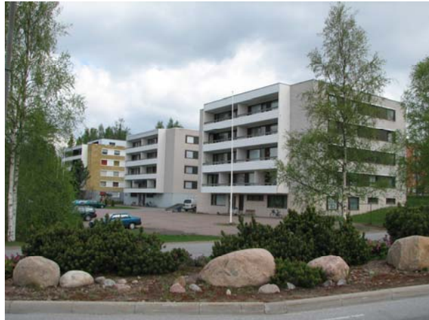
Kuva: Valtatien ja kaupunkiajan kulttuurimaisema, kerrostaloja Satakunnankadun varrella. Parkanon kaupungistumisen uusia rakenteita ja painopisteen siirtymistä kohti valtatieä edustaa Satakunnankatu ja sen varrella 1970-luvulta alkaen rakennetut kerrostalot. Kirkonkylän harjun länsirinteen kerrostalot, liiketalot, kaupungintalo, viheralueet ja Pappilansalmen suihkukaivo muodostavat keskeisen, 1970- ja 1980-lukua edustavan keskustanäkymän Parkanosta valtatie kulkijoille.
