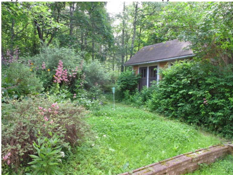
Piharakennus sijaitsee tontin lounaiskulmassa.
