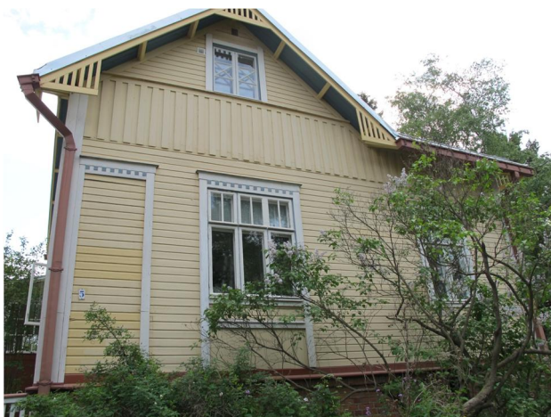
Helletie 5 kulmassa sijainnut sisäänkäynti kauppaan on merkattu koristelistalla.
