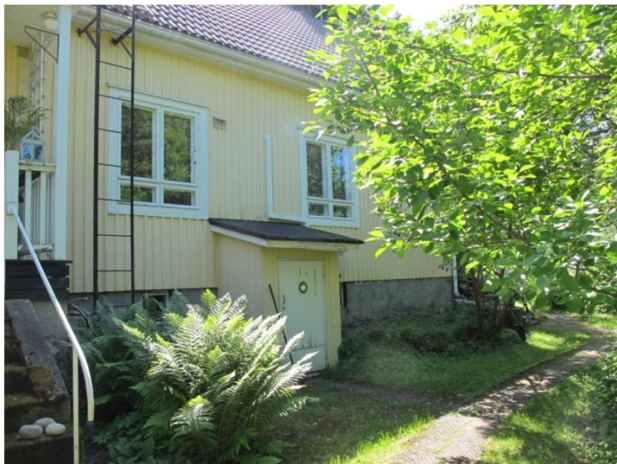
Salotie 4, 1935. Toinen 1930-luvun malli, käännetty risti-ikkuna jossa alaosan ruudut pienemmät. Alkuperäiset ikkunat.
