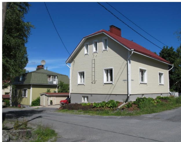
Salotie 3 ja 5 saumapeltikatot. Katso myös seuraava sivu Käpytie 16, perinteisin kattomalli.
