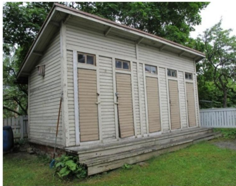
Notkotie 6. Alkuperäinen tai viimeistään 1940-luvulla rakennettu piharakennus.
