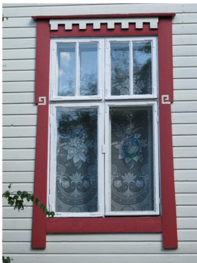
Teljontie 1, rakennettu 1916. Hieno, jugend-tyylinen ikkuna julkisivun pinnassa. Alueelle ja aikakaudelle tyypillinen risti-ikkuna, jonka yläosassa on neljä ruutua.
