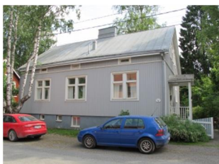
Teljontie 10 Martti Laihonen 1934. Laajennettu alkuperäisten piirrosten mukaan.
