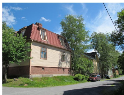
Kantotie 10 huolella muurattu tiilisokkeli ja alkuperäinen tiilikatto.
