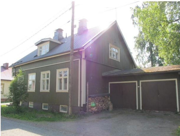
Tyypillisiä 1930-luvun ikkunoita, Teljontie 16. Tien puolella risti-ikkunat, päädyissä ja pihan puolella leveät 6-ruutuiset.
