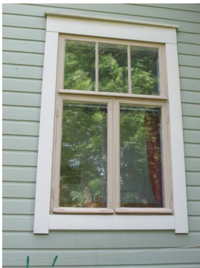
Käpytie 11, rakennettu 1915. Tyylikäs, alkuperäinen ikkuna. Tyypillinen T-malli, jonka yläosassa on kolme ruutua.
