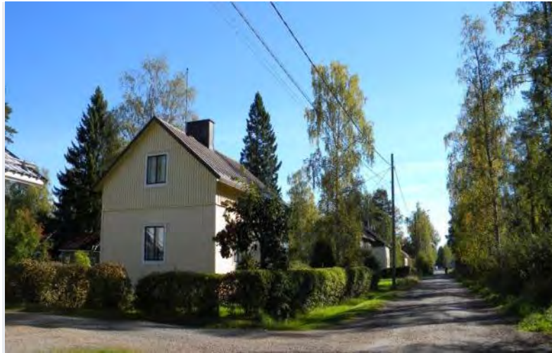
Kuva 26. Koskelassa etelä-pohjoissuuntaiset kadut ovat päällystämättömiä. Rakennukset rajaavat katuja.
