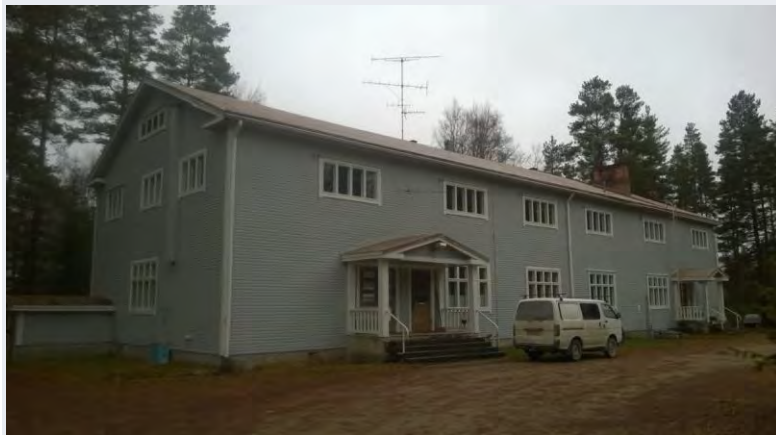
Kuva 51. Varikon entinen toimistorakennus.
