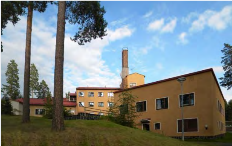
Kuva 41. Sairaalan vuonna 1952 valmistunut keittiösiipi.
