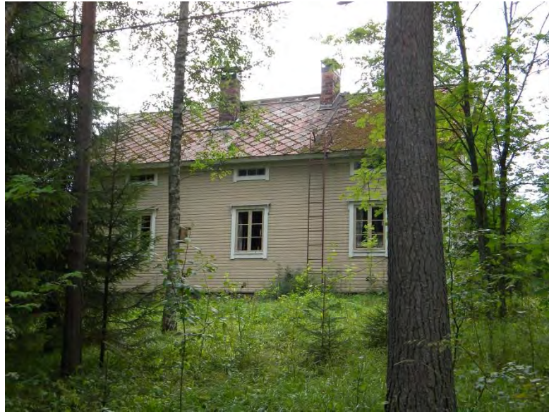
Kuva 61. 1920-luvun asuinrakennus Savonlinnankujan eteläpuolella.
