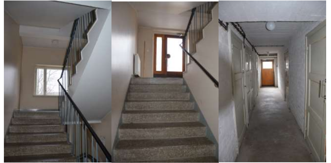
Vasemmalla ylhäällä valokuva 1950-1960-lukujen taitteesta. Virkailijoiden asuinrakennus näkyy etualalla sijaitsevan terveystalon ja keskellä kuvaa olevan kunnantalon takana. Kuva: Hämeenkyrön kunnantalon arkisto. Muut kuvat inventointikuvia 2017. Jari Heiskanen ja Kirsi Niukko
