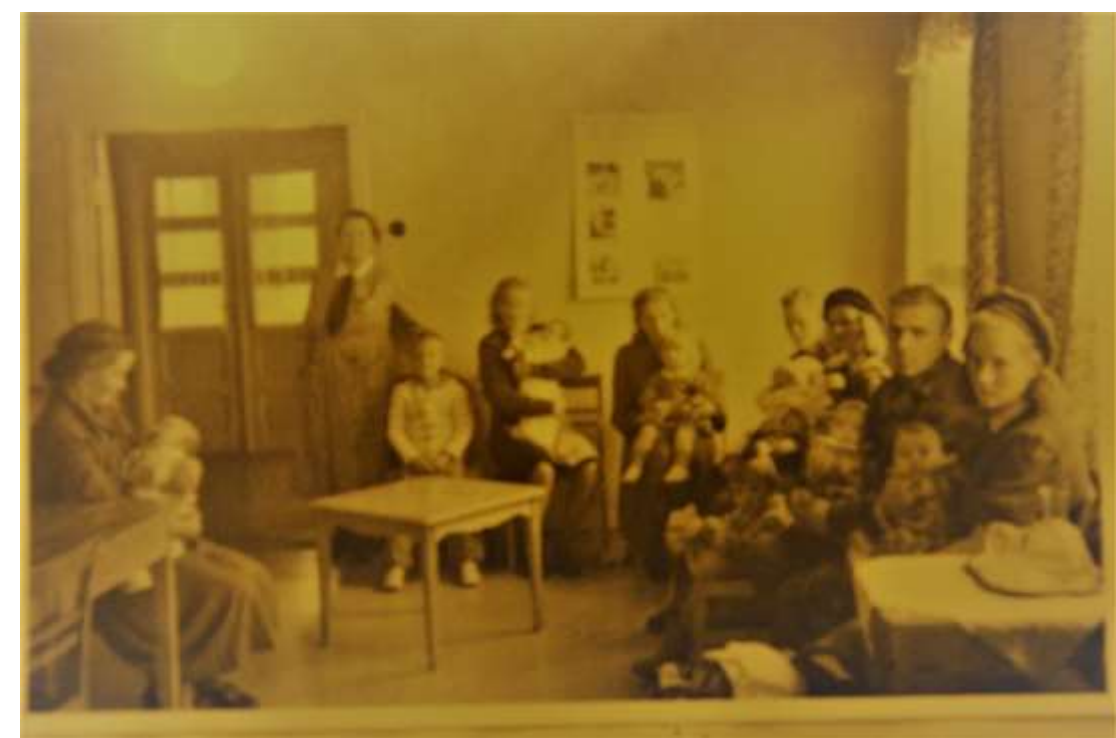
Kuvat: Vasemmalla julkisivu kunnantalon suuntaan, odotushuone keväällä 2017, oikealla alkuperäisenä säilynyt porraskäytävä alakerrassa, alla kuva odotushuoneesta 1950-1960-luvulta (Hämeekyrön kunnan arkisto).
