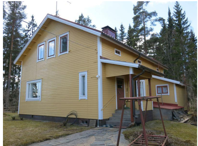
KYY 257 : 96 Uotilantie 21 asuinrakennus pohjoisesta Miiia Hinnerichsen 12.05.2017
