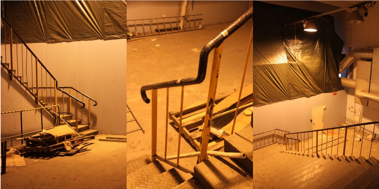
Kuvat 38-40: Betoniportaavat vuodelta 1936, B-lohkon kohdalla (Porras 2)
