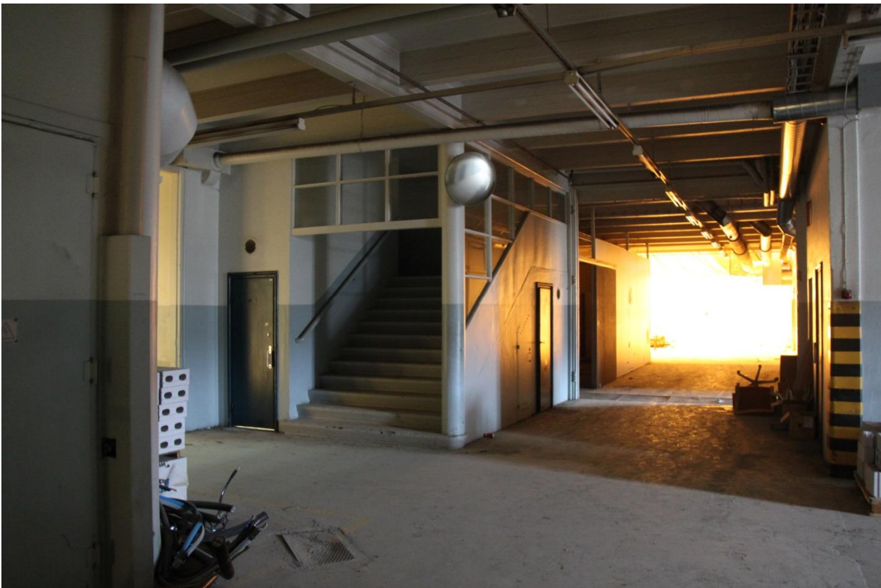
Kuva 41: Pääsisäänkäynnin betoniportaavat vuodelta 1936 (Porras 1)
