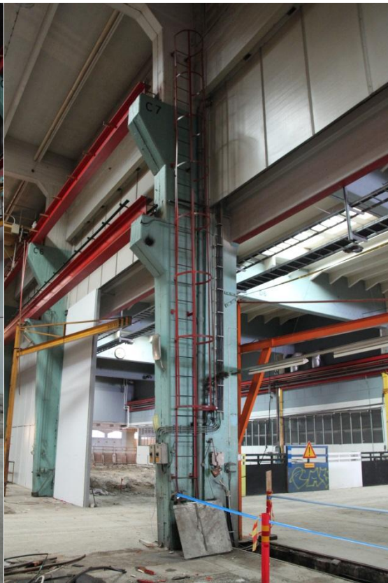
Kuva 14: C- ja B-hallin välissä oleva pilari
