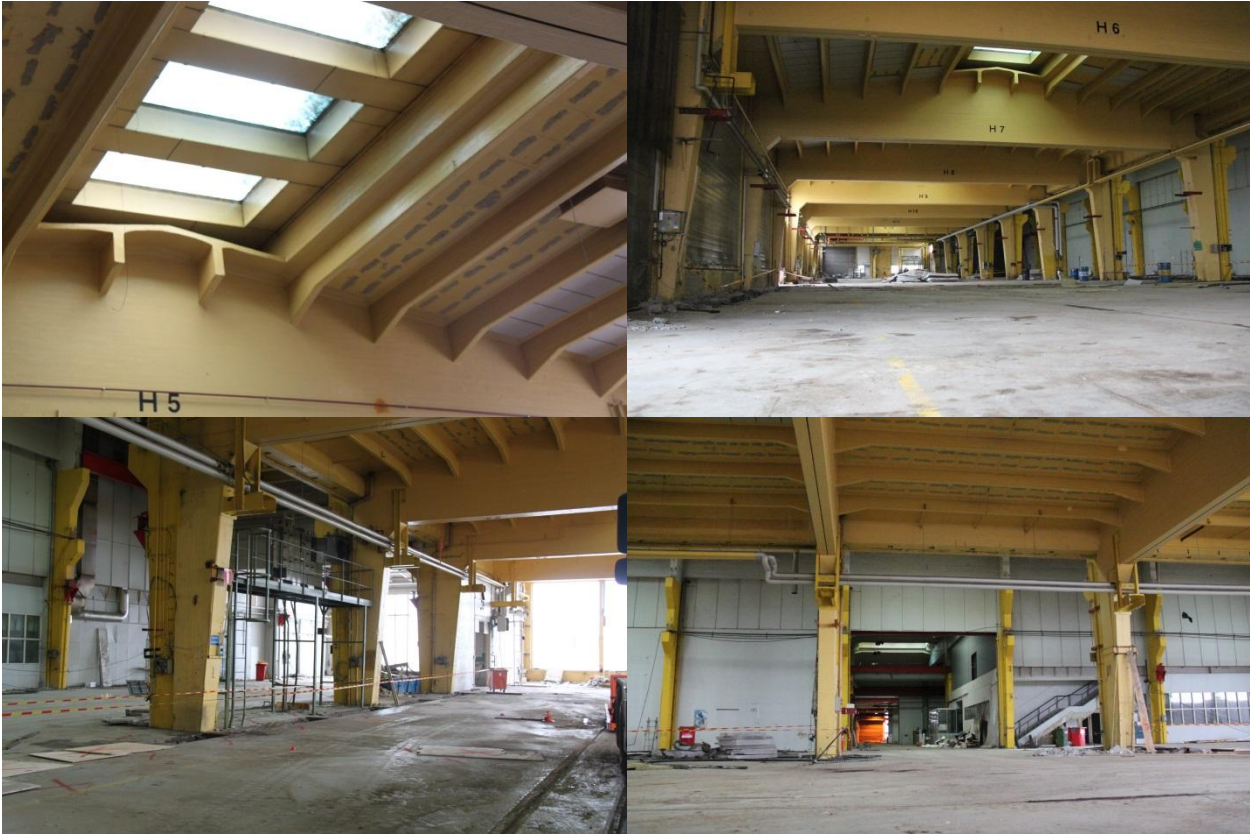
Kuvat 25 ja 26 (ylärivi): H-halli: kattoikkuna ja näkymä itään Kuvat 27 ja 28 (alarivi): H- ja F-halli: näkymä länteen ja etelään
