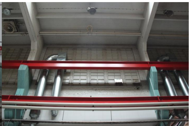
Kuva 17: Alkuperäisiä klerestorio-ikkunoita 1950-luvulta
