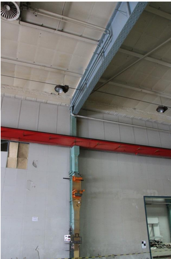
Kuva 22: Betonipilari-teräspalkki-järjestelmä, D-halli itä
