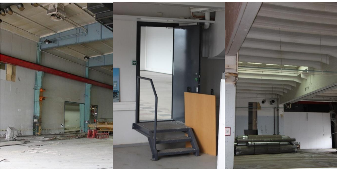
Kuva 63: Teräspalkki-teräspilarijärjestelmä D-hallissa Kuva 64: Teräsporras 2. kerroksessa edustaa uudempaa kerroksellisuutta Kuva 65: TT-laattoja A-hallissa
