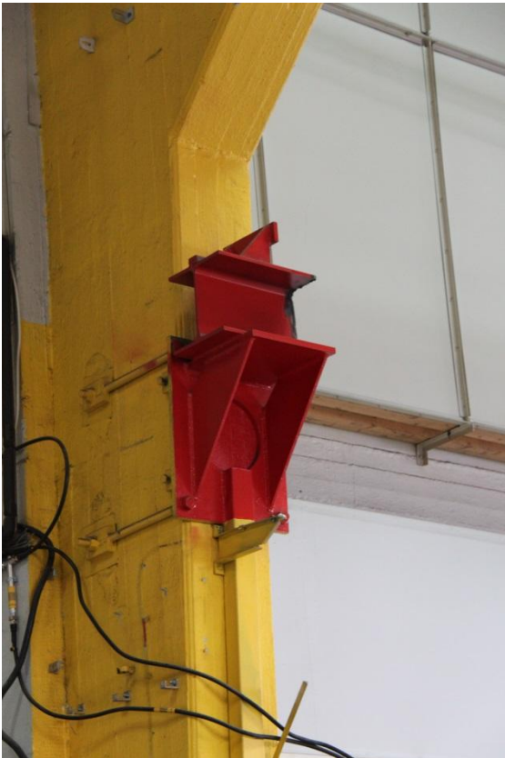
Kuva 29: Pilarin teräskannakedetalji, F-halli
