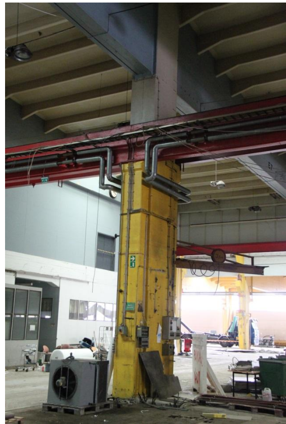
Kuva 23: Betonipalkki-pilari-järjestelmä, D- ja E-halli keskiosa
