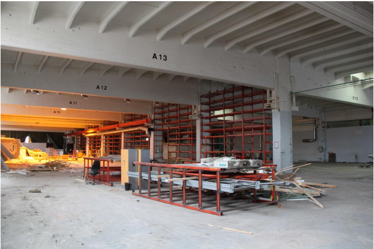
Kuva 10: A- ja B-halli, näkymä kaakosta koilliseen
