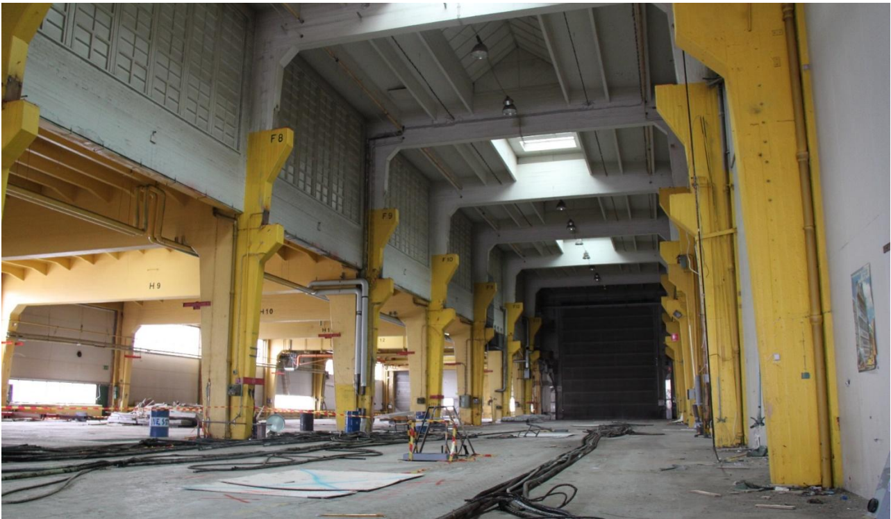
Kuva 66: F- ja H-hallissa näkyy betonipilari-betonipalkki kantavaa järjestelmää ja 1950-luvun klerestorioikkunoita. Siltanosturi ja kiskot on poistettu
