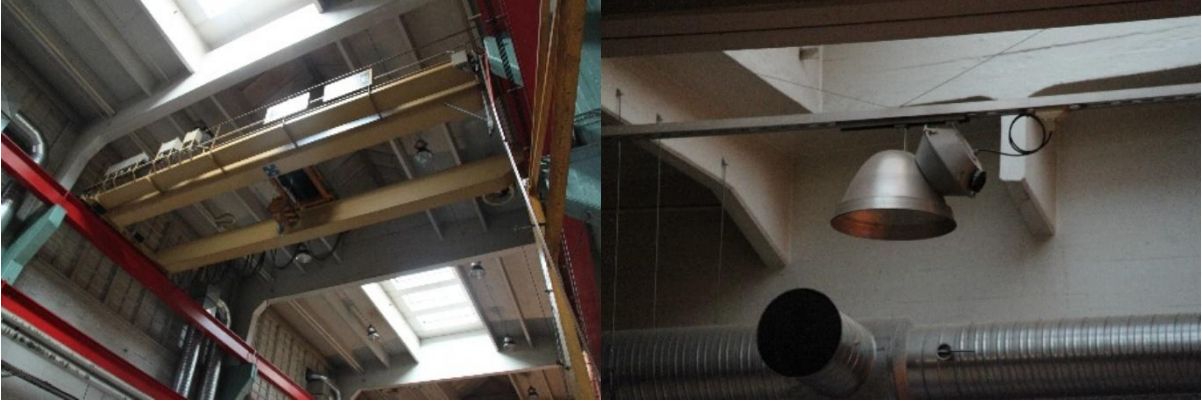
Kuva 67: Siltanosturi C-hallin katossa Kuva 68: Valaisin B-hallissa
