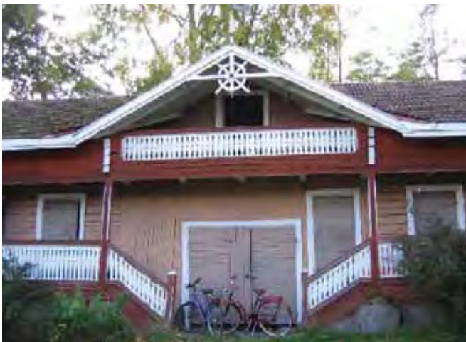
Sivurakennus-riviaitan pihisivun keskikohta.
