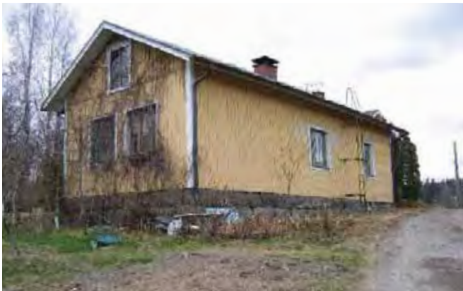
Asuinrakennuksen kaakkoissiipi, rakennus 2
