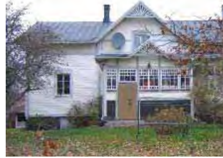
Solalan päärakennuksen luoteispäätyä.
