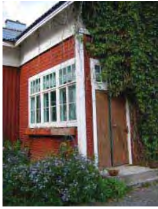
Vanhan päärakennuksen kuistin eteläkulma.
