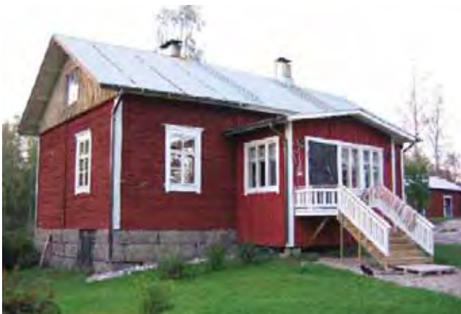
Asuinrakennuksen lounaispääty ja kaakkoissivua.
