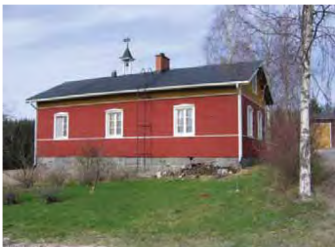
Vanhan asuinrakennuksen kaakkoissivu ja koillispäätä.
