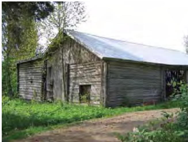
Riihirakennus koillisen suunnasta.
