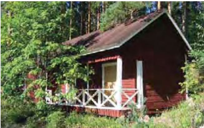
Aittarakennuksessa /6/ on kaksi hirsistä pitkänurkkaista aittaa ja niiden välissä kolmas aitta.
