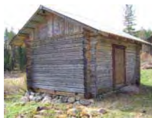
Hirsinen rakennus koillisen suunnasta.
