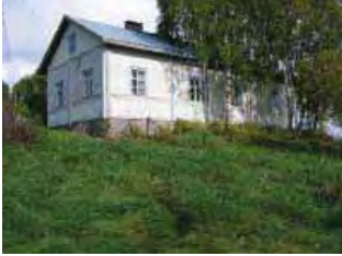
Tiihalanniemen päärakennus lounaan suunnasta.
