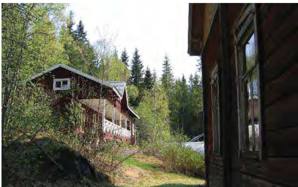
Keskisen päärakennuksen luoteispäädyn kohdalta näkymä riviaitan suuntaan.
