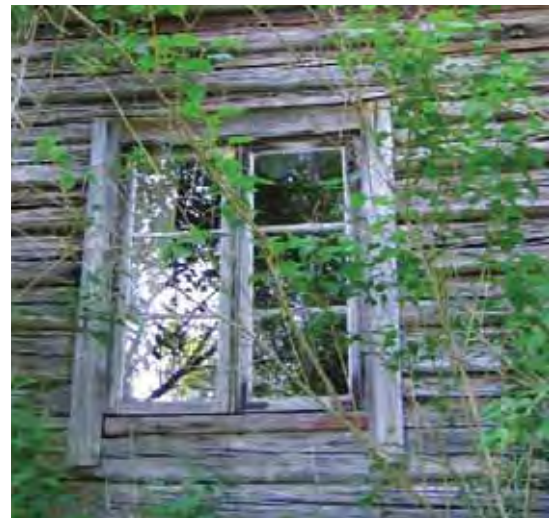
Asuinrakennuksen eteläpäädyn ikkuna.
