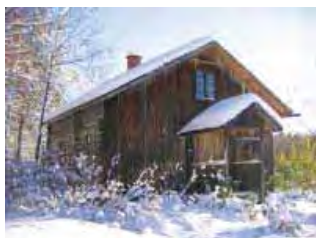
Vanha asuinrakennus luoteen suunasta.
