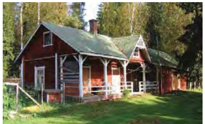
Aittarakennuksen länsipääty ja eteläsivua.
