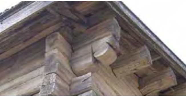
Pariaitan sivuseinien ylimmän tasakerran hirsisalvospäiden ulokkeet on veistetty kaareviksi ja lovettu.
