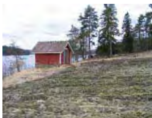
Pumppuhuone /14/ koillisen suunnasta, taustalla vanhempi rantasauna.
