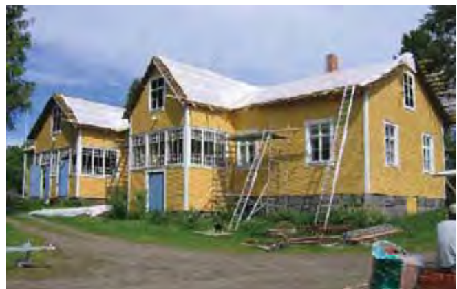
Asuinrakennus etelän suunnasta kesällä 2005 kun katon kunnostustyö oli käynnissä.
