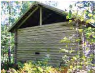
Riihen /4/ luoteispääty. Riihi sijaitsee tien toisella puolella, asuinrakennuksesta pohjoiseen. Hirsiseen yksinäisriiheen liittyy lautarakenteinen edustila. Riihen seinässä on vuosiluku 1919.
