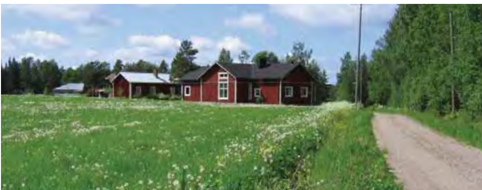
Haaparanta koillisen suunnasta. Keskellä asuinrakennus /1/ vuodelta 1987, peruskorjattu vuonna 2000.
