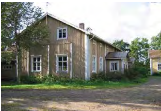
Asuinrakennuksen itäpääty ja pihasivu pohjoisen suuntaan.
