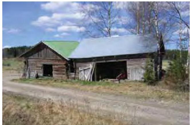
Latorakennukset itä-kaakon suunnasta.
