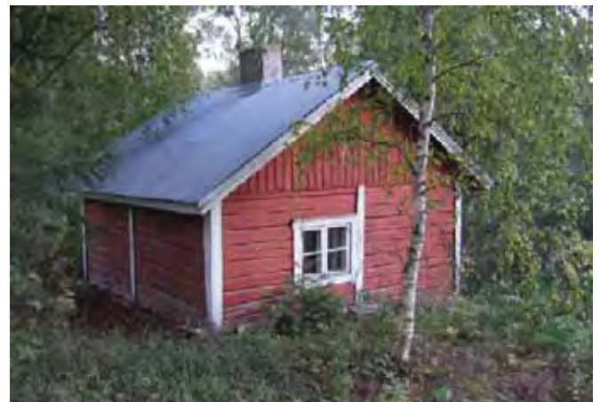
Saunan pohjoispäätty ja tien puoleinen sivu itään.
