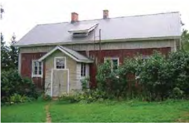
Siurakennuksen pihasivu koilliseen.
