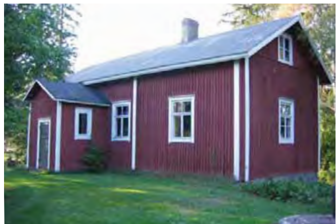
Sivurakennus kaakon suunnasta.
