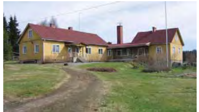
Mattilan asuinrakennukset lounaan suunnasta.
