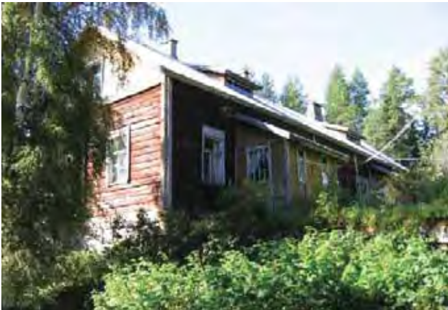
Päärakennuksen etelä-kaakkoispääty ja itä-koillissivua.
