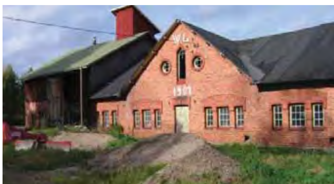
Lounaissivua ja luoteisosa navettarakennuksesta.
