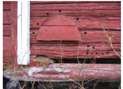
Aittojen liitoskoha pohjoissivulla ja luokinpaininpuu.
