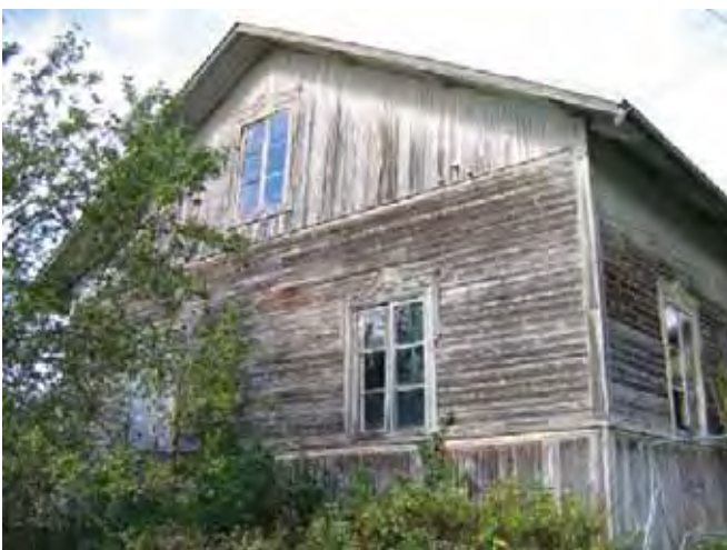
Pohjoispääty ja länsisivua.
