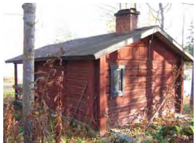
Saunan riihen puoleinen pääty, luoteen suunnasta.
