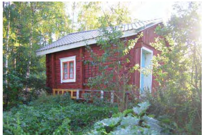
Vanhan asuinrakennuksen itäsivu ja pohjoispäätyä.
