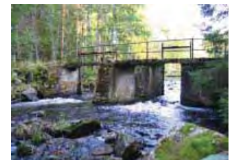
Silta rakenteita luoteen suunnasta.
