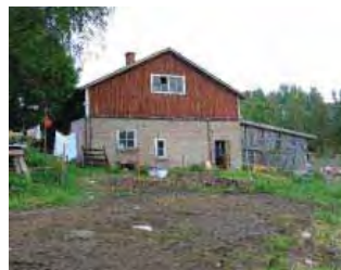
Navettarakennuksen tallipääty järven suuntaan, lounaaseen.
