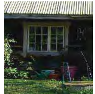
Navetan länsisivun ikkuna.
