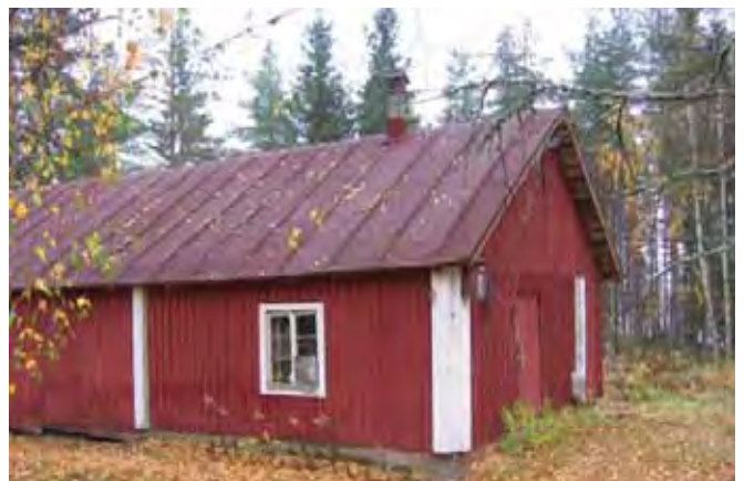
Navetta-liiteri/lato-rakennuksen hirsirakenteinen eteläpääty lounaan suunnasta.
