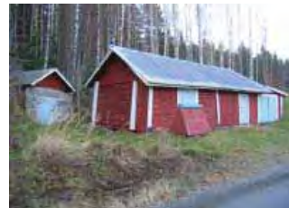
Aitta-talouksrakennuksen /5/ eteläpääty ja tien puoleinen sivu. Maakellari /4/ aitta-talouksrakennuksen lounaispuolella, kuvan vasemmassa laidassa.
