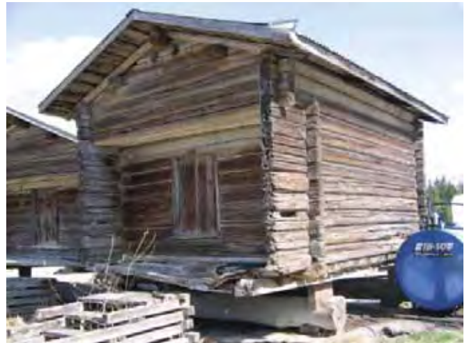
Jauhoaitan lounaispääty ja kaakkoissivu.
