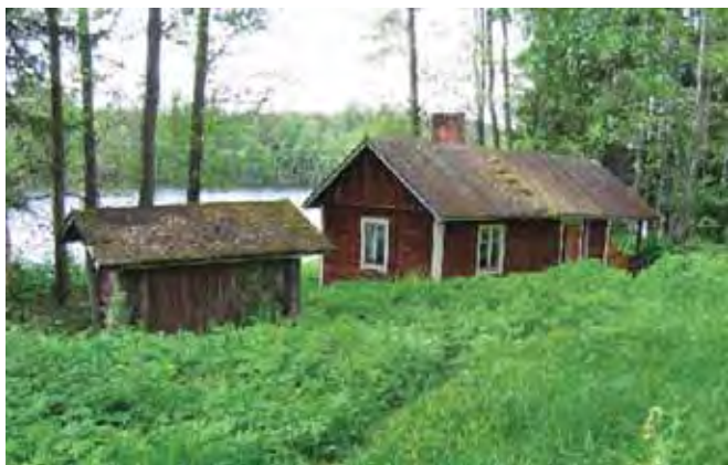
Hirsinen sauna /13/ ja sen vieressä oleva pieni hirsirakennus koillisen suunnasta, taustala Kotolahtea.
