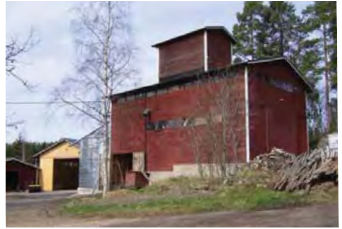
Kuivurirakennus /6/ idän suunnasta.
