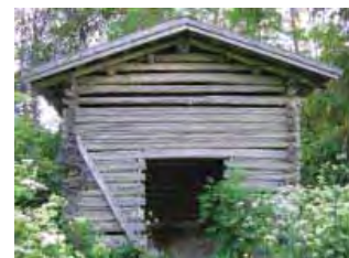
Riihen koillispuolella sijaitsevan lato /6/ on pyöröhirsistä.
