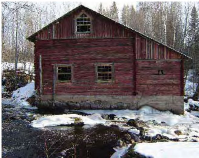
Myllyrakennusjoen vastarannalta pohjoisen suunnasta.
