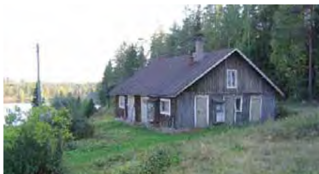
Navettarakennuksen /8/ pohjois-luoteispääty ja pihasisi.
