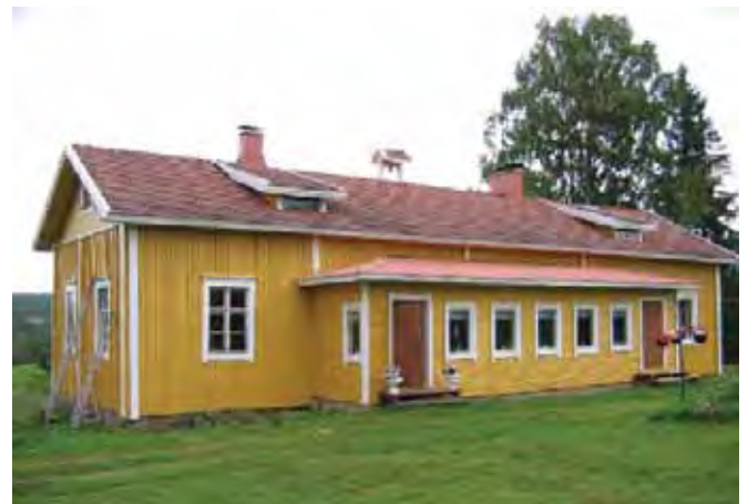
Asuinrakennuksen länsipääty ja pihasisivu etelän suuntaan.
