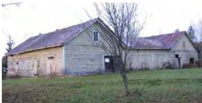
Talusrakennus /4/ dän suunnasta.
