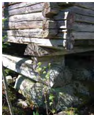
Pohjoisempi aitta /3/. Länsipääty ja jalkarakenne.
