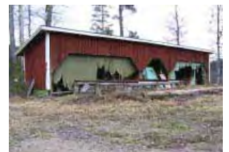
Saharakennus /18/ Haukilahdentien varrella, eteläsivu. Saharakennus 1950-luvulta oli ennen tielinjan siirtoa (1990-luvulla) eri suuntainen.
