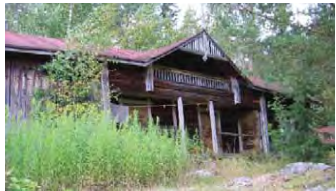
Aittarakennus /3/ etelän suunnasta.
