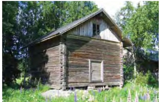
Aitan länsisivua ja eteläpäätyä.
