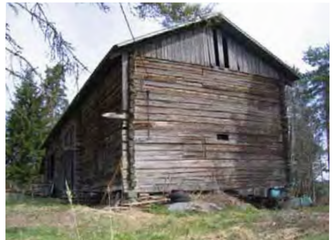
Riihiin etelä-koillispääty ja länsi-lounaissivua.
