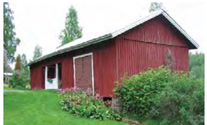
Aittarakennuksen eteläpääty ja pihasivu länteen.
