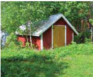
Asuinrakennuksen lounaispuolella oleva maakellari-va-jarakennus /2/ rinteessä.
