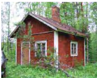
Sauna /3/ on satulakattoinen hirsinen lyhytnurkkainen vaakalautavuorattu rakennus.
