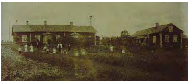
Alasen päärakennus ja sivurakennus 1900-luvun alun valokuvassa. Päärakennuksessa oli järven puolella kaksi monikulmaista lasikuistia ja itäpäädyssä korkea ruokakello.
