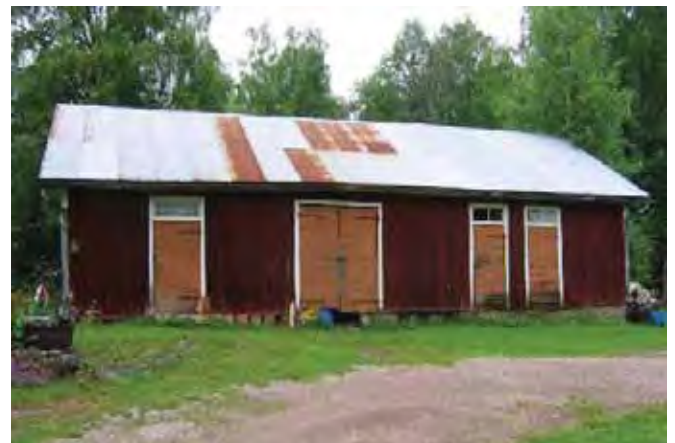
Talousrakennuksen /2/ eteläsivu. Rakennus on satulakattoinen, rankorakenteinen ja pystypeiterimavuorattu. Siinä oli koulun ulkokäymälät, liiteri ja muita varastotiloja.
