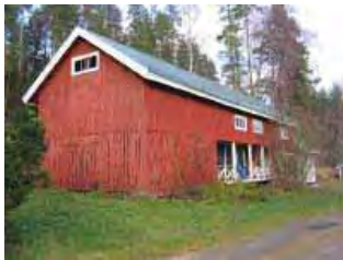
riviaitta-liiteri-autotalli-rakennus /4/ etelän suunnasta.
