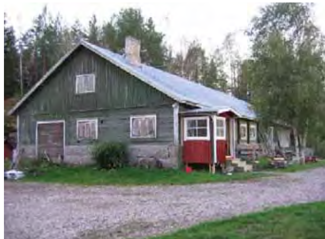
Navettarakennus koillisen suunnasta.
