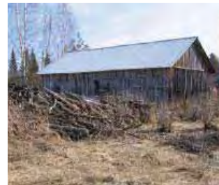
Liiteri-kalustusuoja /5/ on lautarakenteinen.
