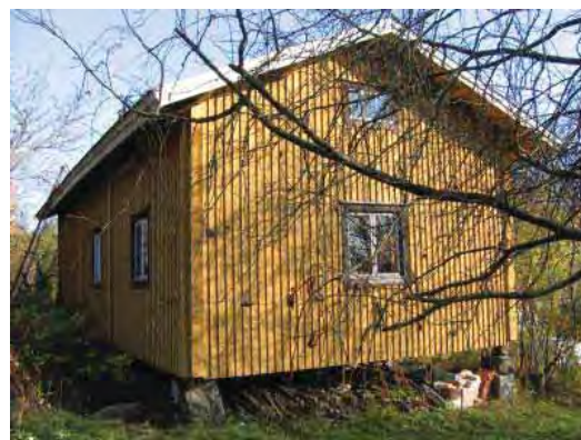
Vanhan asuinrakennuksen länsi-lounaispäätty ja pohjoisluoteissivua.
