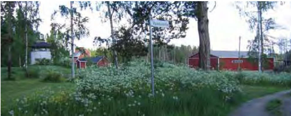
Näkymä Anttilaan johtavan Vuokkolantien alusta. Eerolan tilan rakennuksia, vasemmalla huvimaja tms. /10/, oikealla konehalli /5/.
