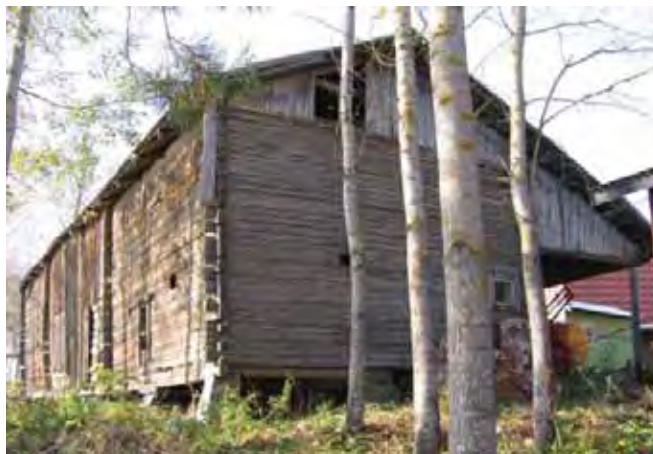
Riihen itäpääty ja pitkä sivu järvelle päin, etelään.
