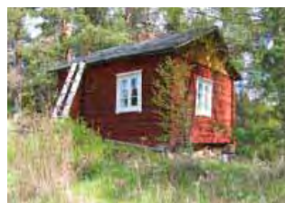
Muonamiehen mökkin kaakkoispääty ja lounaisivu.
