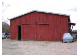
Navettarakennuksen /3/ kaairakenteisen osan pääty luoteeseen.
