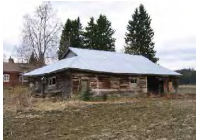
Navetta idän suunnasta. Navetta on lyhytnurkkainen hirsira- kennus, jossa on päädyistään aumattu satulakatto.
