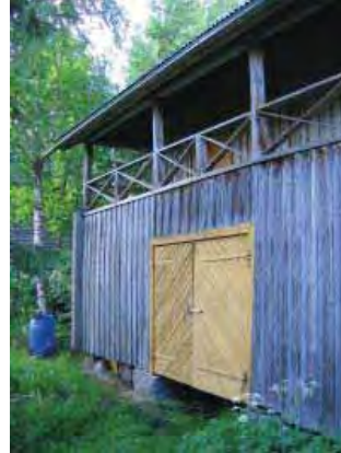
Luhtiaittarakennuksen etelä-sivun länsipuoli.
