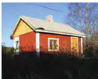
Sauna /4/ lounaan suunnasta. Sauna on satulakattoinen lyhytnurkkainen pystypeite- rimavuorattu hirsirakennus. Lounaisnurkalla on sisäänvedetty kuisti.
