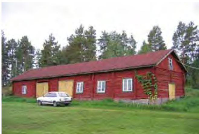
Navetan pohjoispääty ja pihasivu itä-koilliseen.
