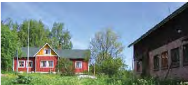
Asuinrakennus etelän suunnasta. Oikealla navetan länsisivua.
