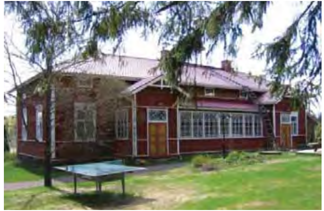
Asuinrakennuksen koillispäätyä ja luoteissivu pihan suuntaan.
