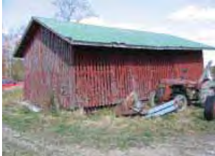
Liiteri /8/ sijaitsee riihen länsipuolella.
