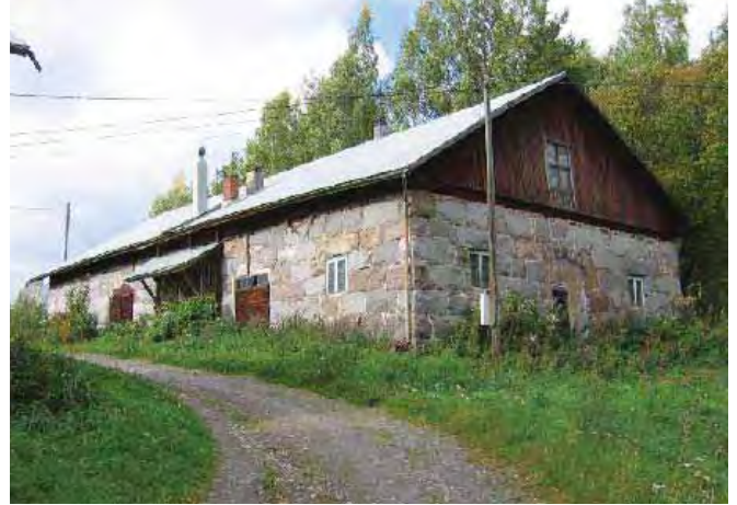
Navetan itäpääty ja etelässivua.
