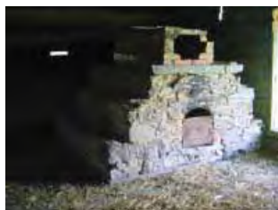
Pohjoispuoleisen riihen uuni.
