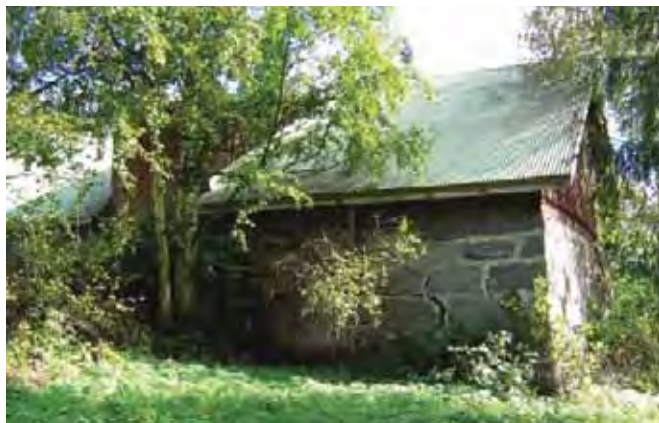
Kivi-navetan länsipääty luoteen suunnasta.
