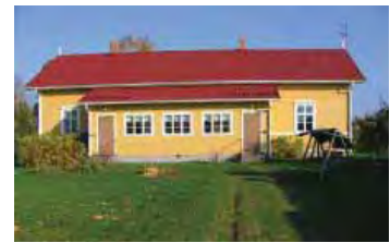
Päärakennuksen pihasivu lounaan suuntaan.
