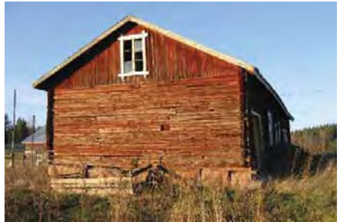
Tallirakennuksen eteläpääty ja pihasisu itäpuolella.
