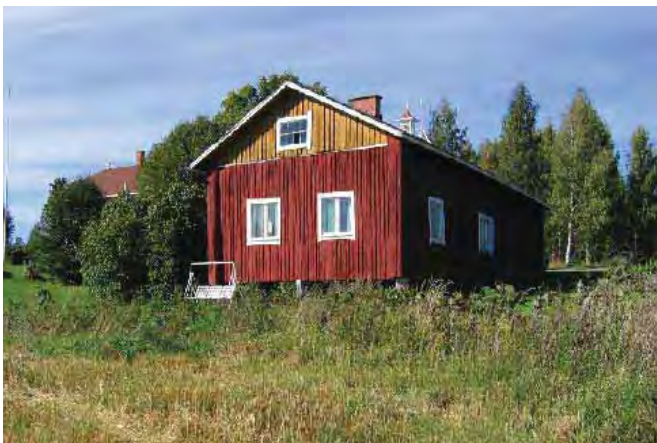
Sivurakennus kaakon suunnasta.
