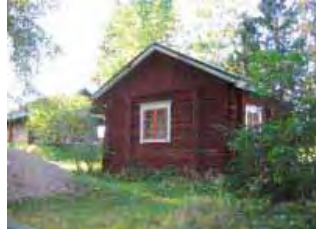
Vanhan asuinrakennuksen eteläpääty ja itäsivua, taustalla lomarakennus.
