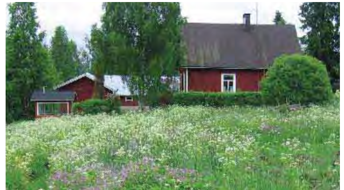
Asuinrakennuksen itäpuolella on kuvan vasemmassa laidassa näkyvä grillikatos /3/, näkymä pohjoisesta.
