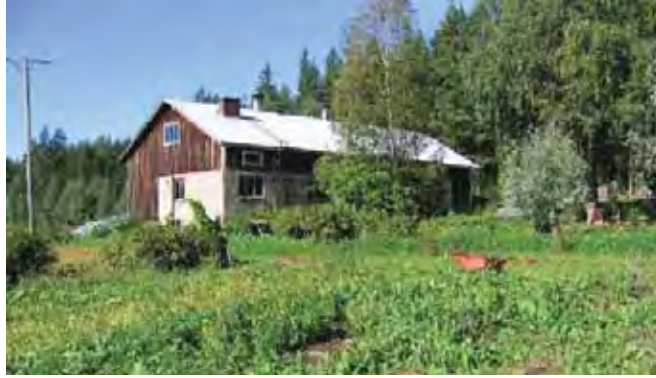
Navettarakennus /3/ kaakon suunnasta.
