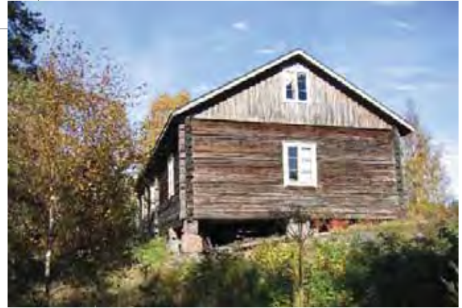
Asuinrakennuksen eteläpääty ja länsisivua.
