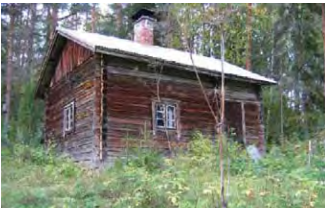
Sauna /4/ etelän suunnasta. Sauna sijaitsee päärakennuksesta pohjoiseen mäenrinteellä. Se on vuoraamaton pitkänurkkainen hirsirakennus. Satulakattoinen (aaltopeltikate) saunarakennus on perustettu nurkkakiville.
