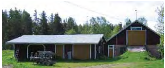
Vasemmalla navetan kanssa kulmittain oleva talusrakennusliiteri /4/ pohjoisen suunnasta.
