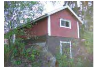
Maakellari-vaja-rakennus /3/ päärakennuksen koillispuolella, näkymä koillisen suunnasta.
