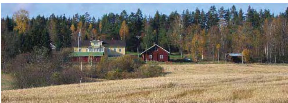
Ylä-Korholan rakennuksia kaakon suunnasta.
