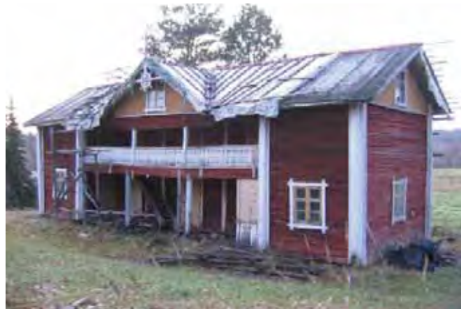
Sivurakennuksen pihasisivu itään ja pohjoispääty.
