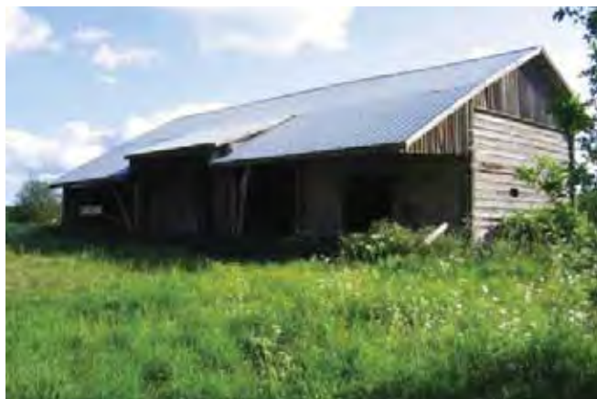
Riihirakennus koillisen suunnasta.
