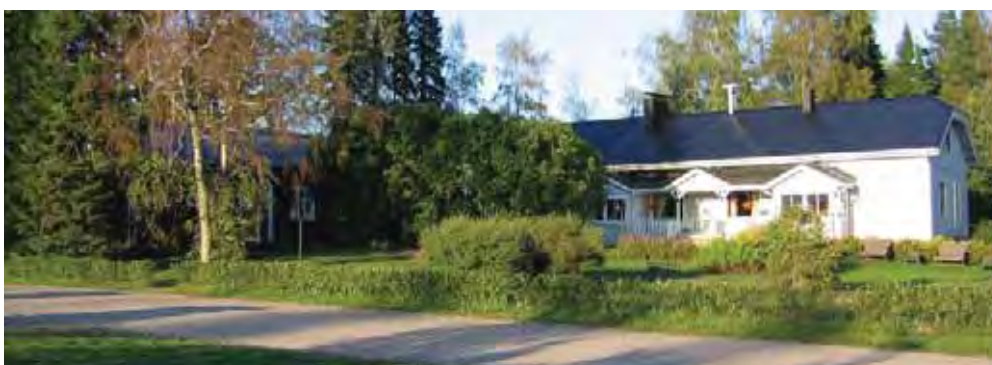
Eerolan asuinrakennukset kulmittain toisiinsa nähden, näkymä lounaan suunnasta.
