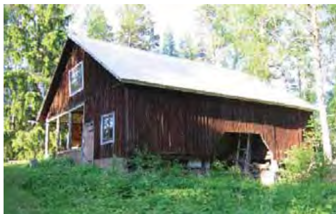
Navetta-talouksrakennuksen /4/ länsi-luoteispääty ja lounais-eteläsivua. Alhaalla vasemmalla ulkokäymälän ovi.
