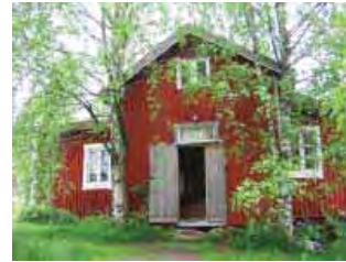
Asuinrakennuksen eteläsivun kuisti.
