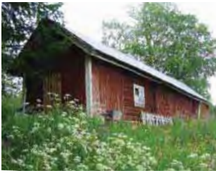
Sauna-liiteri-aitta-rakennus /2/ lännen suunnasta.
