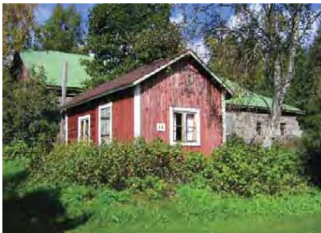
Sauna /6/ navetan eteläpuolella, etelän suunnasta.
