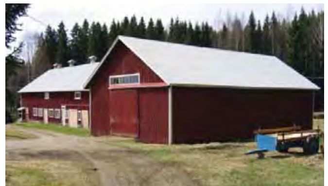
Navetta-puimalarakennus koillisen suunnasta. Etualalla puimala.
