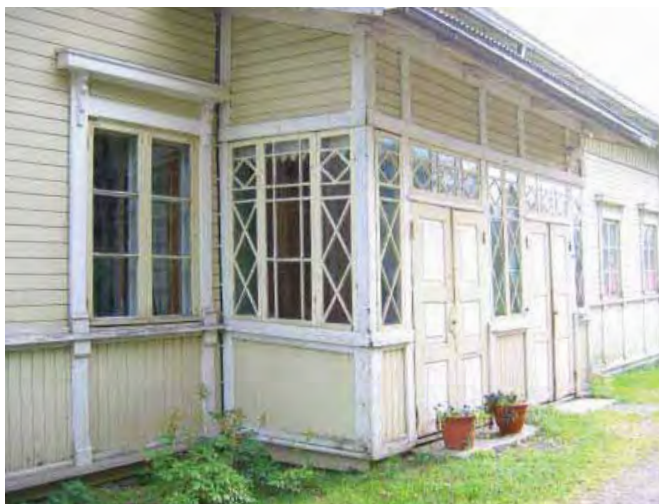
Asuinrakennuksen pihisivun lasikuisti pohjoisen suunnasta.
