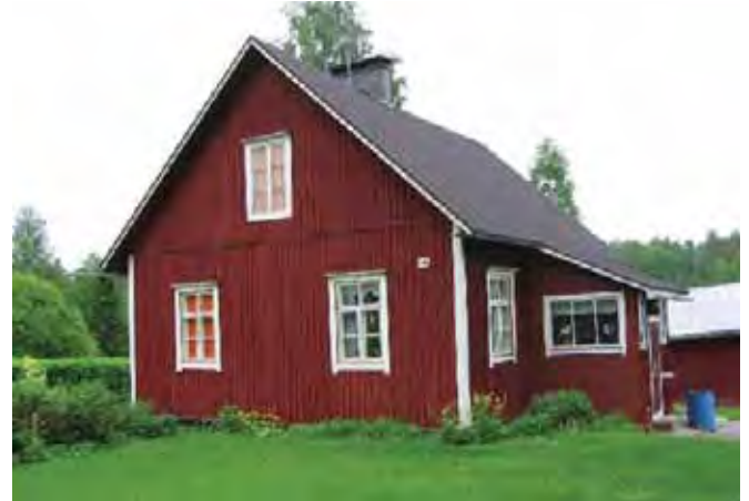
Asuinrakennuksen länsipääty ja pihasivu etelän suuntaan.
