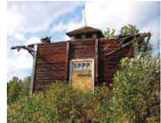
Hirsisessä vilja-aitassa /6/ on ollut säteri/pyramidikatto ja lanternniini.
