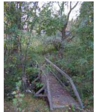
Jokuoman ylittävä puusilta.
