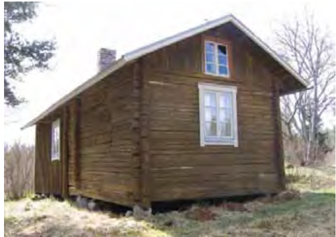
Asuinrakennuksen koillisnurkka, nähtynä pohjoisesta.
