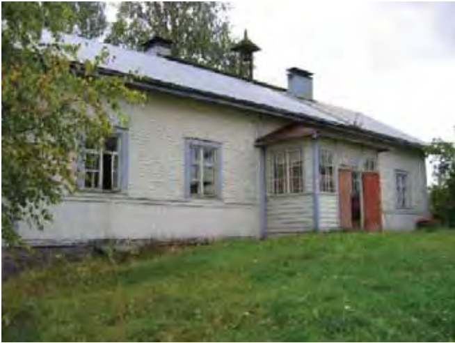
Asuinrakennuksen pihasivua pohjoisen suuntaan.
