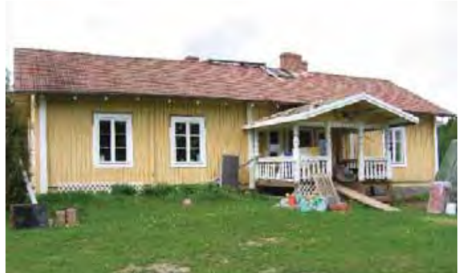
Läpikäytävän asuinrakennus etelän suunnasta kesällä 2005 korjaustöiden aikaan.
