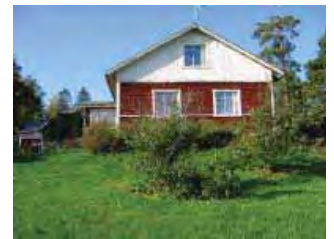
Uudempi asuinrakennus /2/ Kaakkoispääty. Taustalla vasemmalla näkyy vanhaa päärakennusta.
