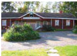
Sivurakennus-riviaitan pihisivu koilliseen.
