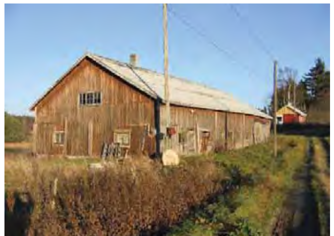
Navetan länsipääty ja eteläisivu.
