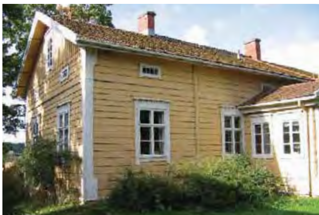
Sivurakennuksen eteläpääty ja pihasivua.
