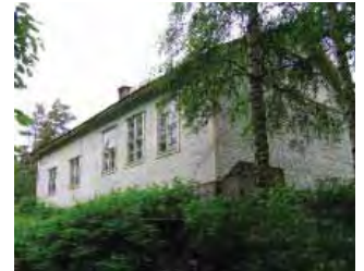
Ristijärven koulu alarinteen puolelta nähtynä, länsisivu ja eteläpääty.
