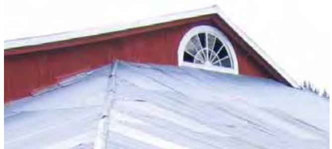
Navetan luoteispäädyn ikkuna.
