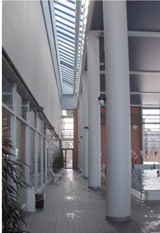
Vanhan ja uuden liitos sisätiloissa
