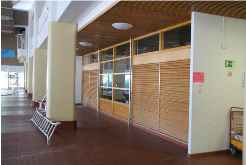
2. kerroksen puurimaseinää ja -kattoa.
