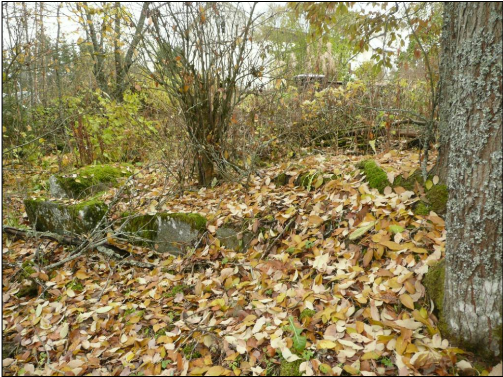
Tupurla: Rakennuksen perusta.
