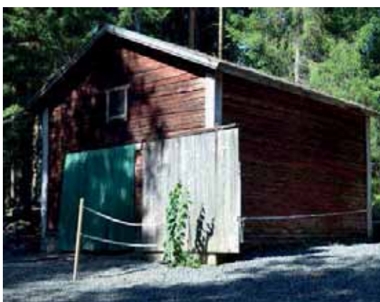
(3) Todennäköisesti vilja-aittana toiminut, pihapiirin ulkopuolelle sijoittuva kookas aitta on rakennettu betonisokkelille, lyhytnurkkaisessa hirsirungossa on punamullan jäämiä. Hirsissä ei näy siirtomerkintöjä, se on kenties rakennettu 1930-luvulla. Rakennuksen oviaukkoa on suurennettu ja toisen kerroksen lattia on osittain purettu.
