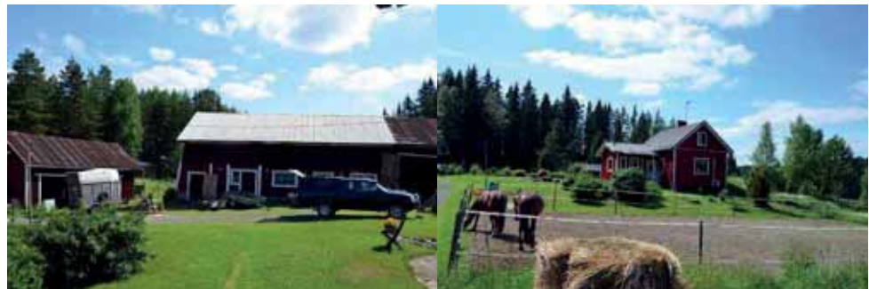
Kuvat: pihapiirin rakennuksia: hirsinavetta v. 1952, 1930-luvulla valmistunut ja 1990-luvulla pienellä siipiosalla laajennettu asuinrakennus.
