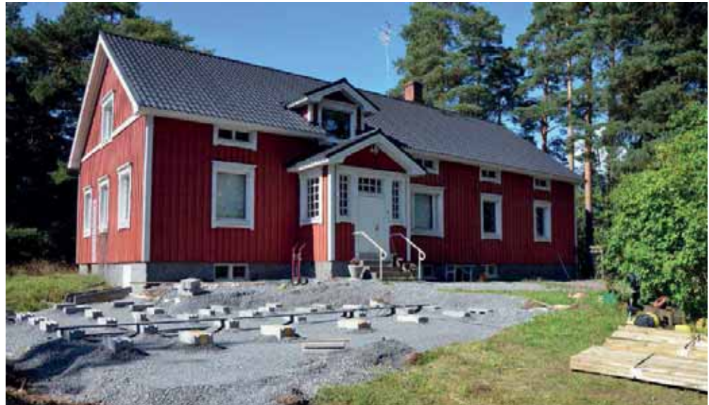
Kuva: Heikkilän asuinrakennus kaakosta kuvattuna.
