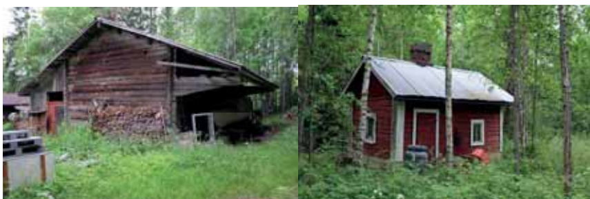
Kuvat: pihapiirin ulkopuolella ovat palovaarallisista rakennuksista riihi ja sauna.
