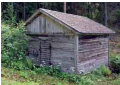
Kuvaus: pihapiiri rek. 418-457-2-13 Myllymäki, puromylly rek. 418-457-2-7 Myllyrinne, os. Myllymäentie 54. Myllymäen pihapiirin keskeiset rakennukset, asuinrakennus ja navetta, on rakennettu torpan itsenäistymisen aikoihin, 1920- ja 1930-luvuilla. Vanhempia rakennuksia ovat riihi, paja, aitat ja mylly, uudempia kalustusuoja ja toinen asuinrakennus.
