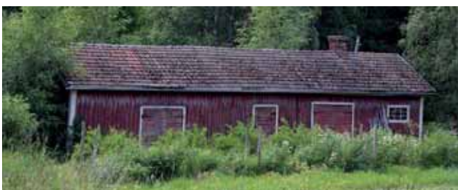
Kuva: Koskipuiston talousrakennus
