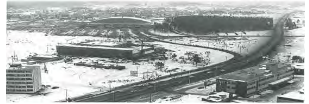
Kuva 94. Hakametsän jäähallialue Sammonkadulta päin kevättalvella 1965. Etualalla keskeneräinen kauppaoppilaitos. Pääkulkureitti keskustasta päin jäähallille on kulkenut Sammonkadulta suurinpiirtein nykyisen Jäähallinraitin kohdalta. (Lähde: Kaikkien aikojen Kaleva: Veikko Lintinen / Tampere-Seuran kuva-arkisto)
