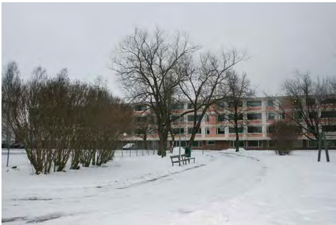
Kuva 39. Keltinkatu 4-6 Uudenmaanpuiston suunnasta kuvattuna.
