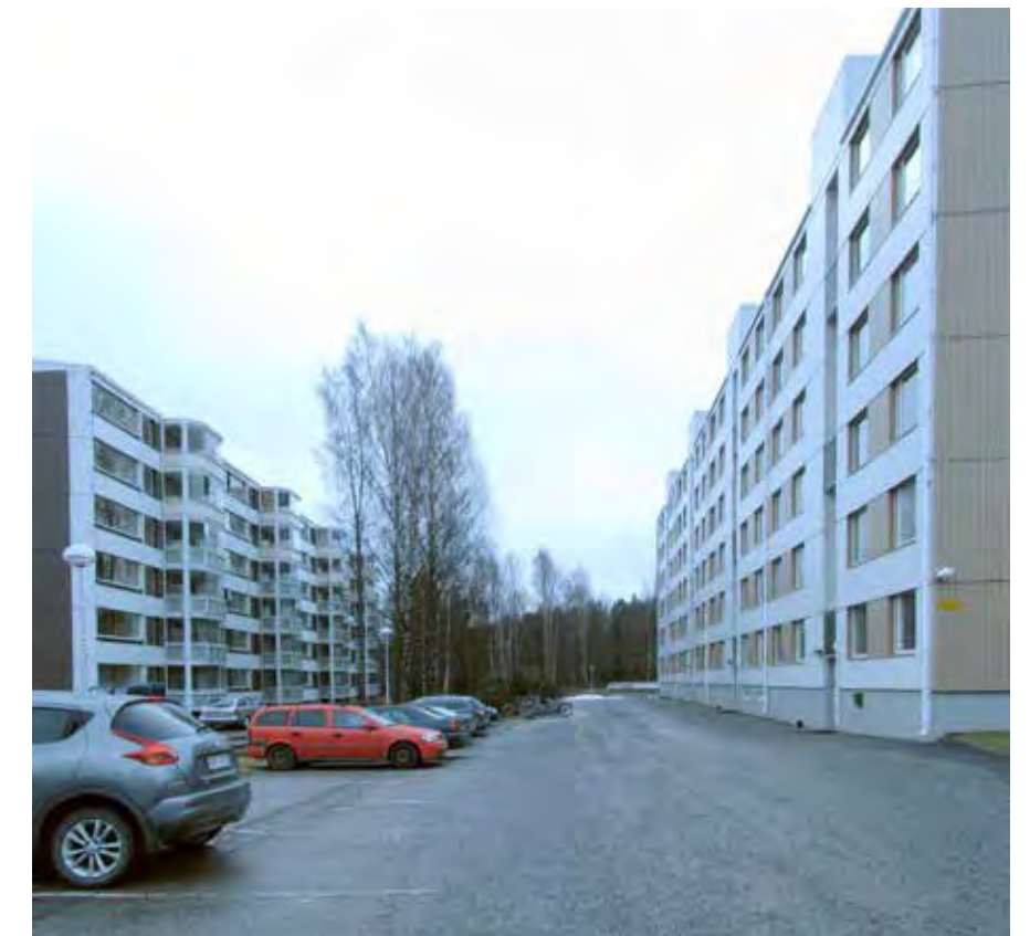
Kuva 118. Kissantassun 1960-luvun korttelin piha ja asuinrakennukset edustavat aikakautensa tila-ajattelua ja rakentamisen teknologiaa.
