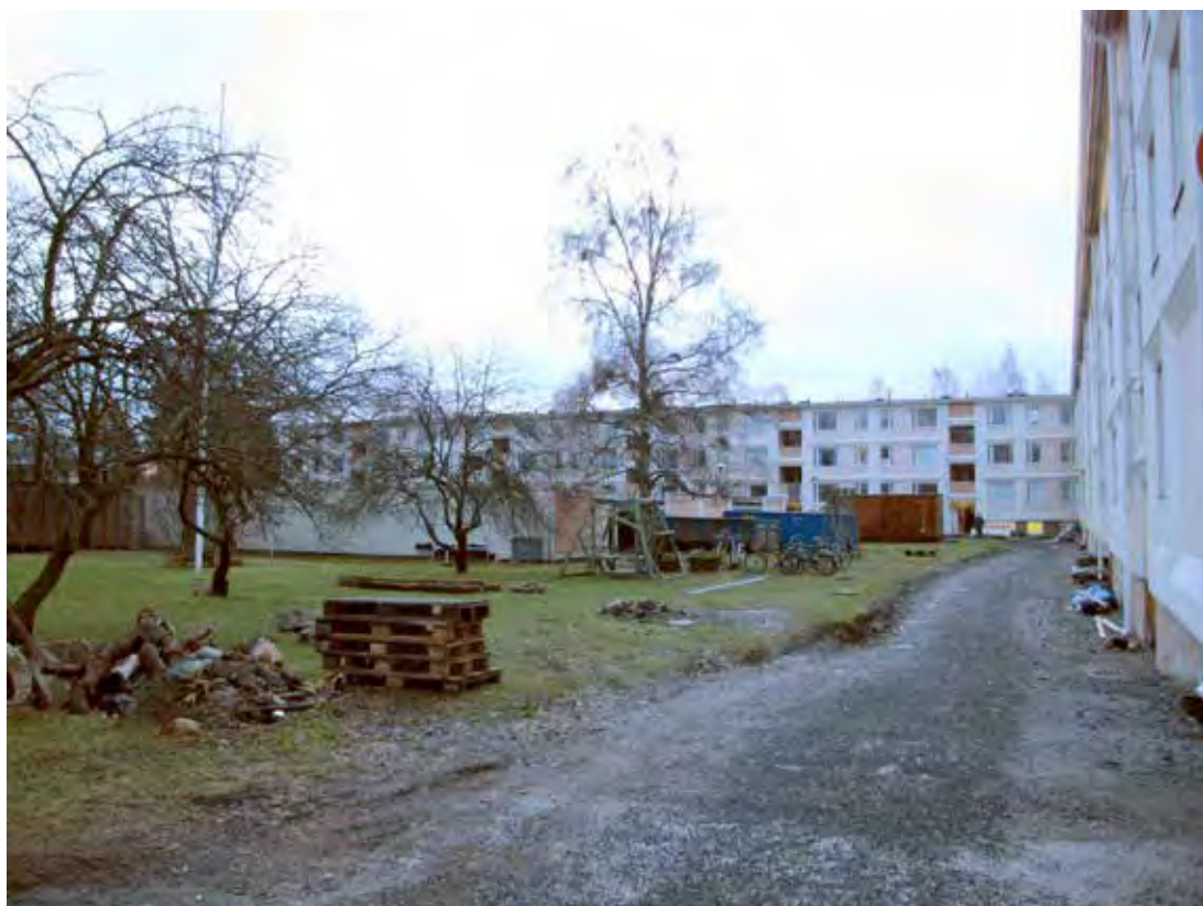
Kuva 113. Keltinkatu 4-6 sisäpiha. Kiinteistössä on meneillään remontti.
