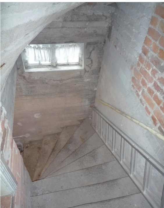
Kellarin betoniportaat ja kellarin tiilimuurattu väliseinä.
