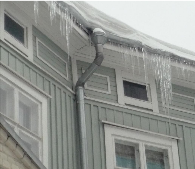
Räystä ja syöksytorvi rakennuksen sisäkulmassa.
