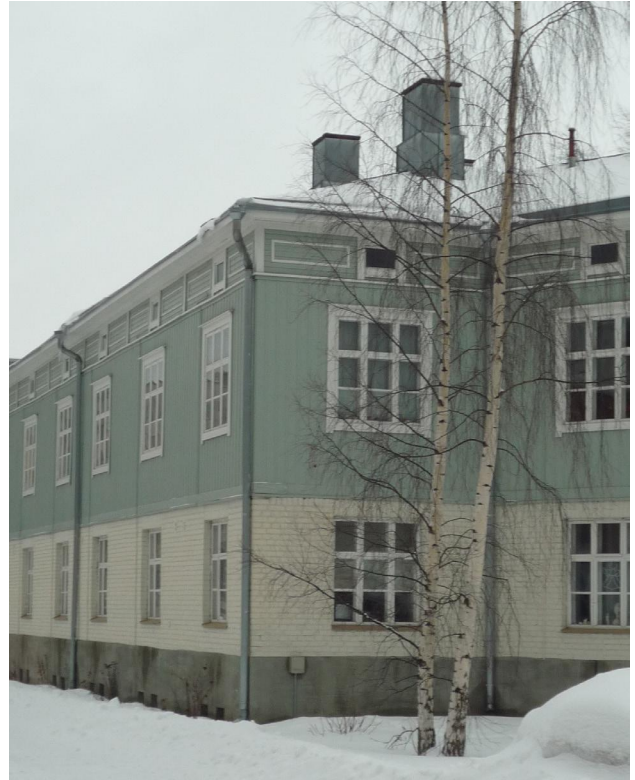
Yläkuvassa rakennussiipien liittymäkohta eteläjulkisivulla.
