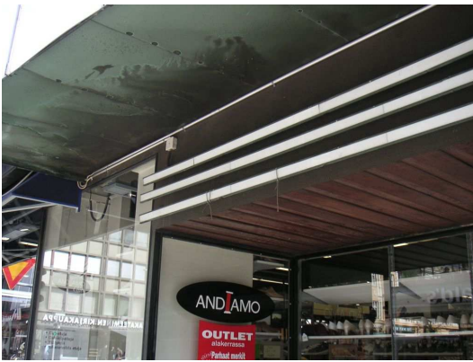
Julkisivun lasiset koristelistat tuovat ilmettä alaosaan, mutta ne ovat arkoja ilkvallalle ja onnettomuuksille
