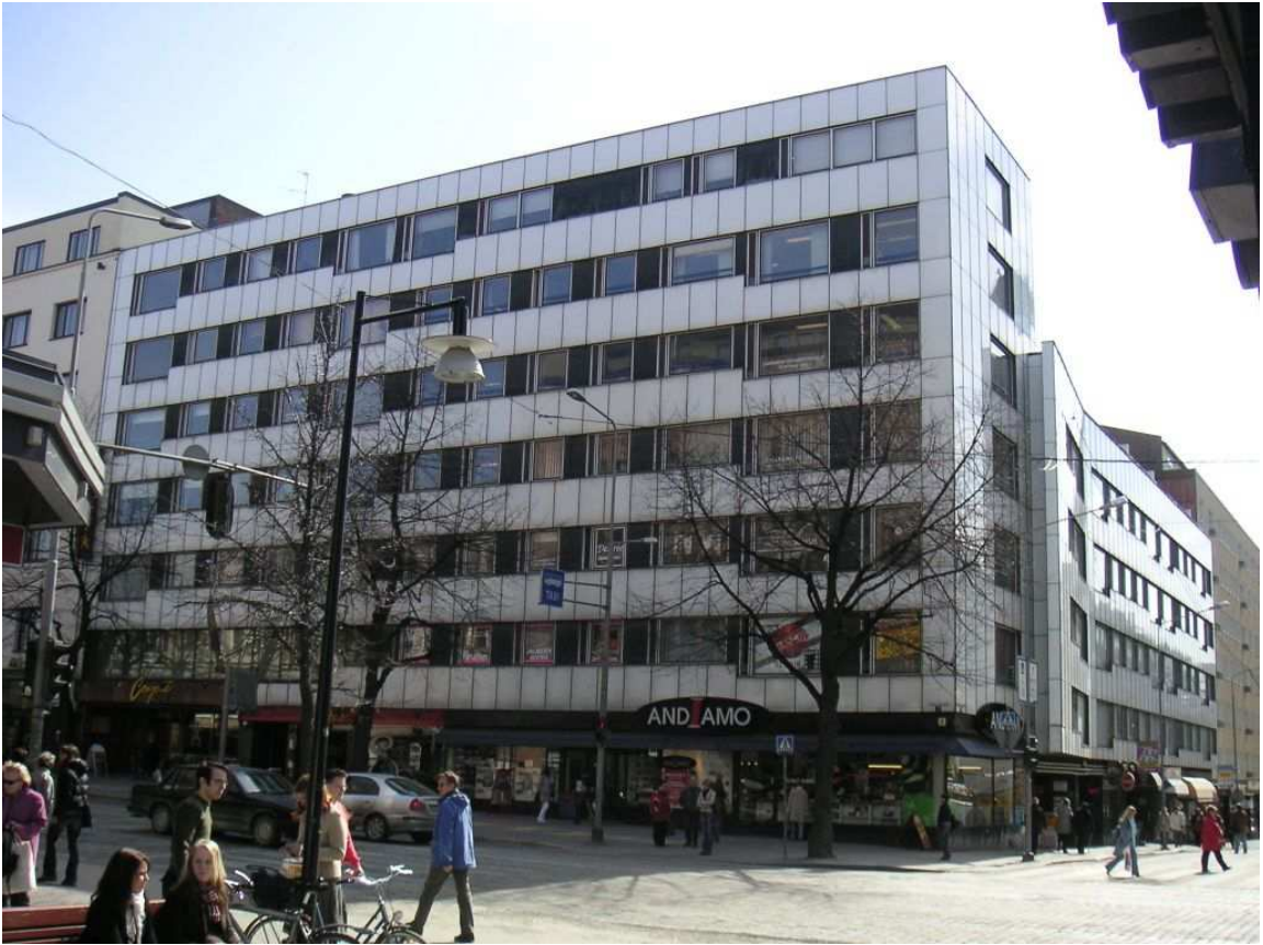
Kuva 11. Hämeenkatu 3 nykyisin. Nykyinen ullakkokerroksen katto ei näy kadulle, ja CD-siipi näyttää 5-kerroksiselta.
