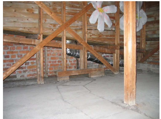
Kuivausullakkoa B-rapun itäpäässä. Tiiliseinä on viereisen hotellin palomuuria.
