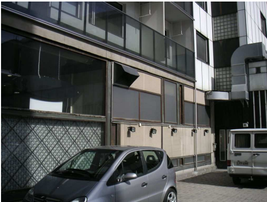
Pihan sekava julkisivu. Vasemmalla on lasin ja lisätyn kalterin takana kenkäkaupan asiakasporras alakerran myyntitiloihin ja varastoon. Oikealla kahvilan remonteissa muutettua taustaseinää ja ilmanvaihdon poistoputket. Putken takana ja yläpuolella on B-rapun ikkunat, jotka ovat lasitiiltä viereisten asuntojen ikkunoiden läheisyyden takia. Lasitiiliset ovat jo huonokuntoiset.
