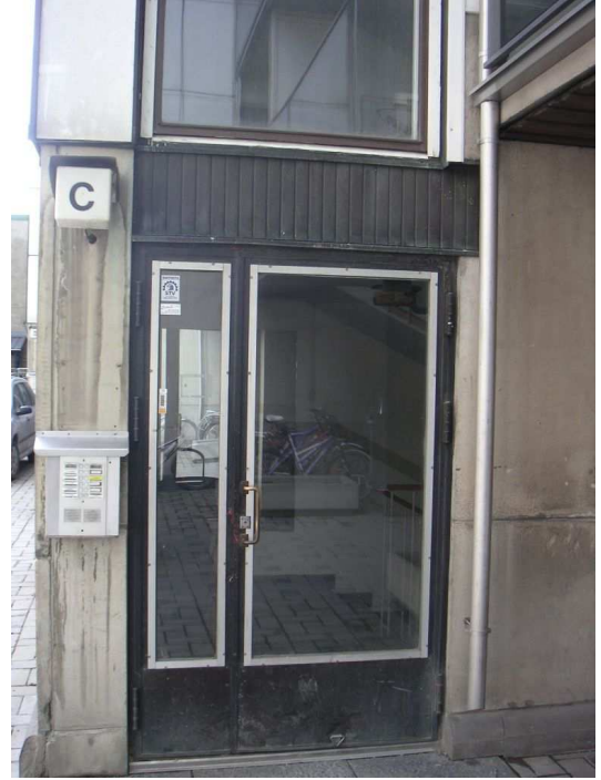
C-rapun ulko-ovi heloineen ja pellityksineen. Vedenpoistoputkisto on terästä ja lisätty parvekeremontin yhteydessä. Putkelle ei ole vedenpoistoa. Ovipuhelinjärjestelmä lisätty 1980-luvulla
