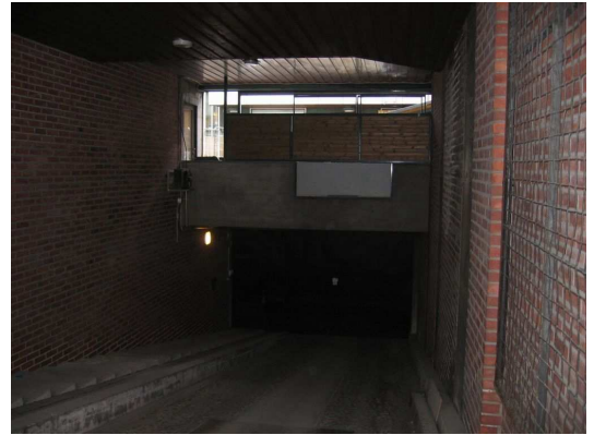
Ajoramppi huoltokellariin. Yläpuolella näkyy jätehuolto ja käynti D-rappuun
