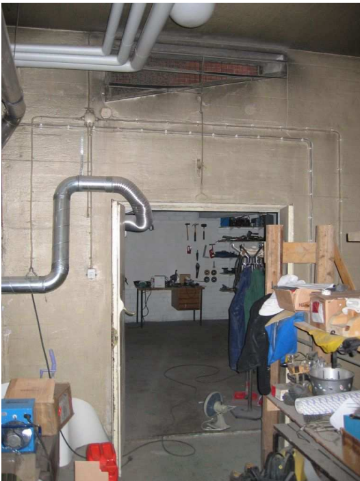
Teknistä tilaa öljypolttimien yläpuolella, verstaskäytössä
