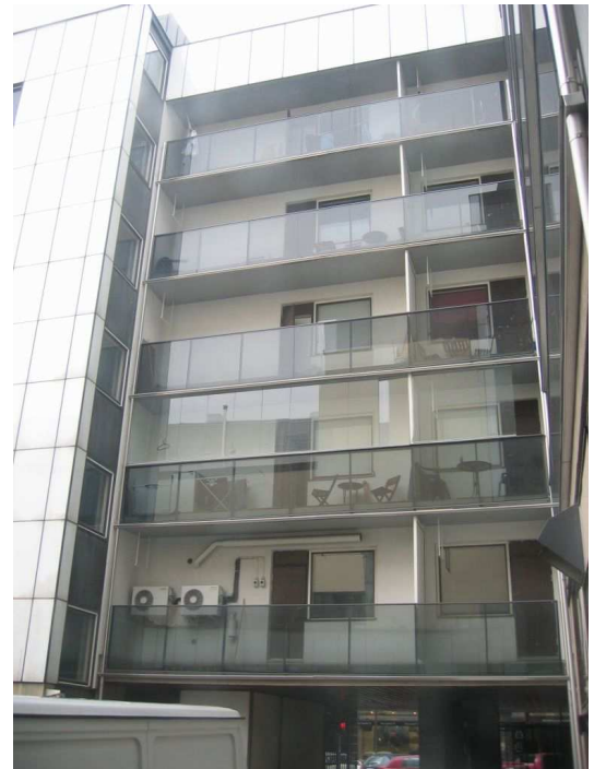
Uudet sisäpihan parvekkeitaet pihalle ajon yläpuolella. Jäähdytyslaitteistot ovat hammaslääkäriaseman.
