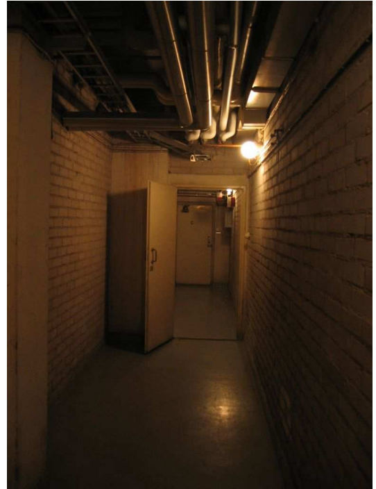
Tyypillinen kellarikäytävä, kuva on saunatilojen edestä.
