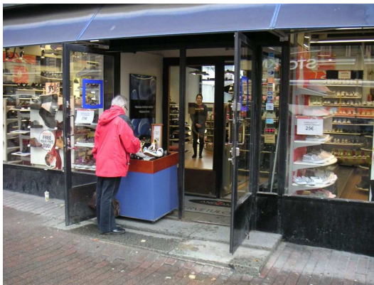
Kahdesta erillisestä ovesta yhdistetty sisäänkäynti.
