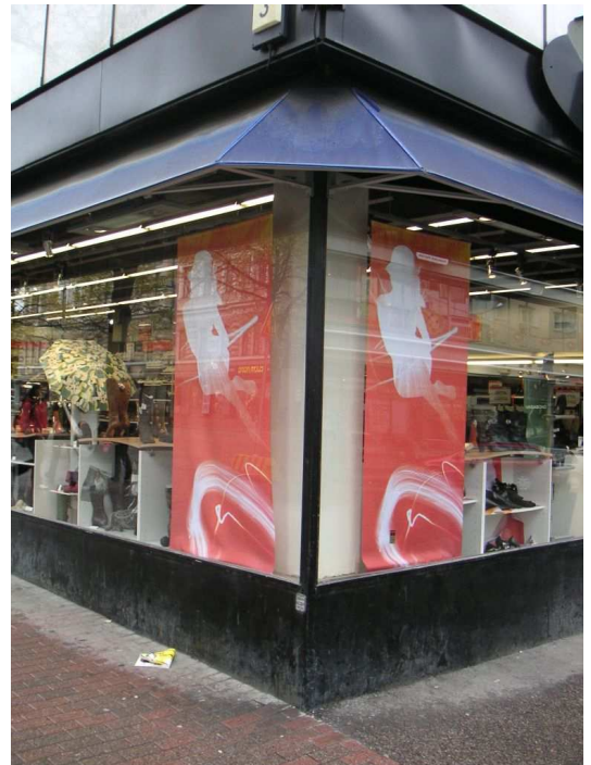
Kenkäkaupan kulman siro teräsprofiili ja potkupellin liitos.
