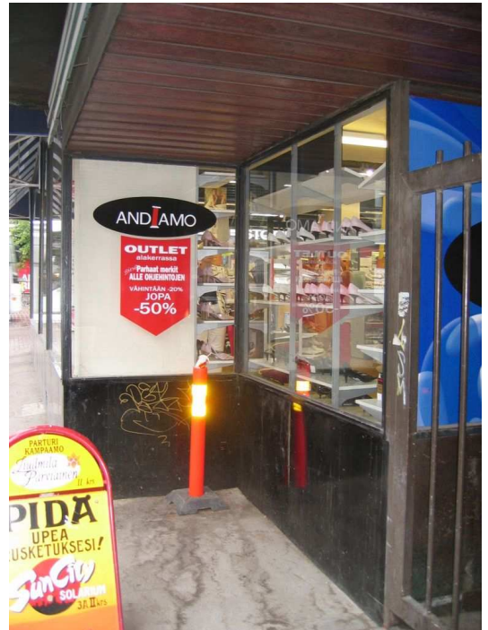
Sisäänveto julkisivupinnassa Tuomiokirkonkadulla ja osa pihan porttia. Syvennykset keräävät epätoivottuja vierailijoita ja niissä käydään öisin tarpeilla
