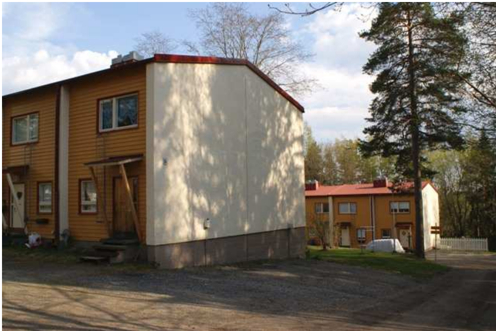
Rivitalot. Porrastettujen rakennusten julkisivuissa näkyvät huoneistojen väliset palomuurit ovat sekä käytännöllinen että arkkitehtoninen elementti.
