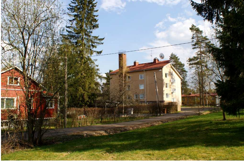
Tiilirunkoinen rapattu pistetalo Pyrytiellä Ilkontieltä kuvattuna. Takana näkyy rivitalo. Vasemmalle jää yksi Pyrytien omakotitaloista.
