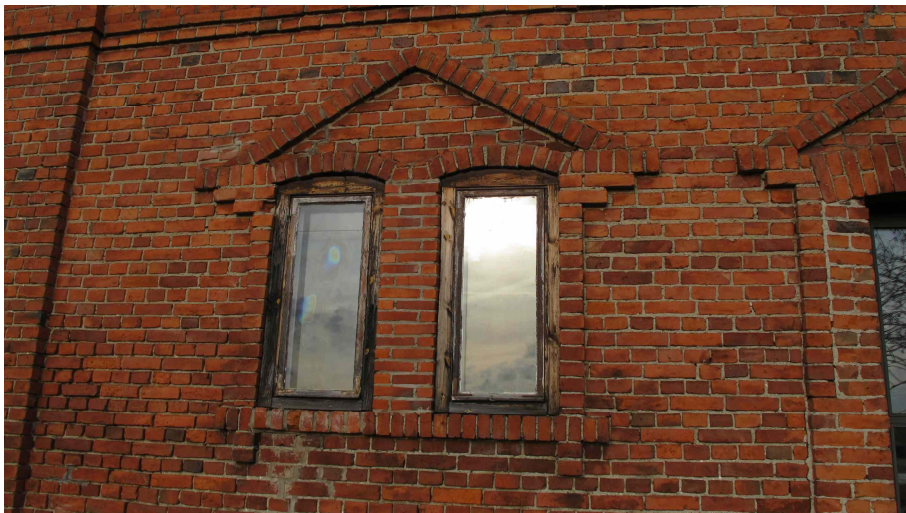
Kuva 10 Vaihdettuja ikkunoita
