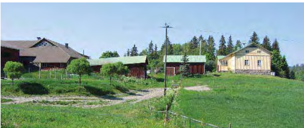
Orilahden pihapiiri kaakon suunnasta. Oikealla asuinrakennus, siitä vasemmalle talousrakennus-autotalli, liiteri, navetta ja konehalli.
