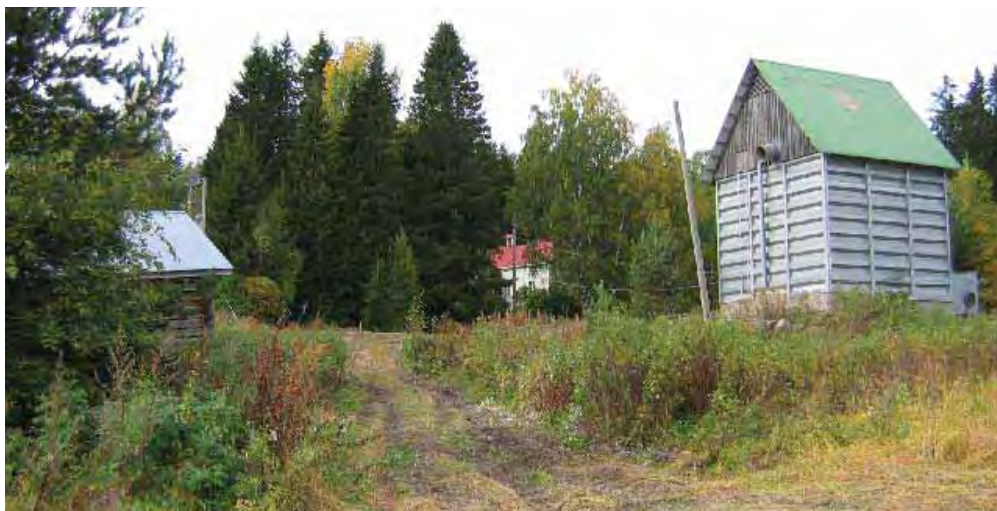
Pyöröhirsinen lato /12/ ja kuivurirakennus /11/ itä-kaakon suunnasta, taustalla Mikkolan pää-rakennus.
