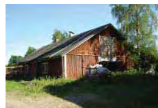
Navetta pihan puolelta, luoteispäätä.
