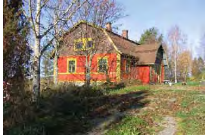
Kaislarannan päärakennus, kaakon suunnasta nähtynä.
