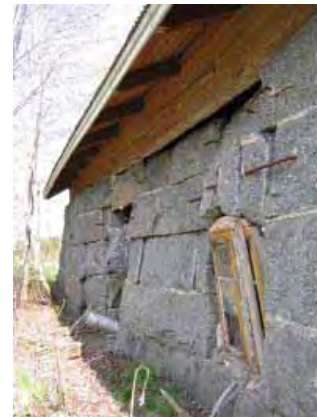
Pihan puolen seinää koillisen suuntaan.
