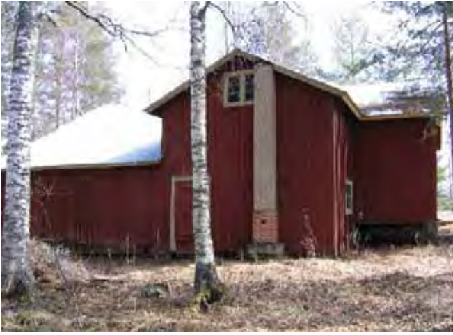
Kalustovaja-puimala tms /2/ lännen suunnasta. Rakennus on pystylautavuorattu, punamullan punaiseksi maalattu satulakattoinen talousrakennus. Länsisivulla olevan korkeamman osan satulakatto muodostaa lappeelle poikkipäädyn. Eteläpäädyssä korkean parioven päällä on vaakaikkuna, jossa on kahdessa rivissä neljä vaakasuuntaista kolmiruutuista ikkunanpuitetta.
