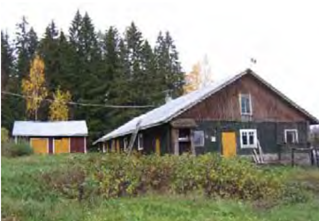
Navetta lounaan suunnasta. Taustalla autotalli-liiterirakennus /9/.
