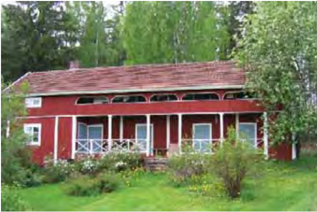
Luhtiaitta-sivurakennuksen itäsivu. Kuva vuodelta 2004.
