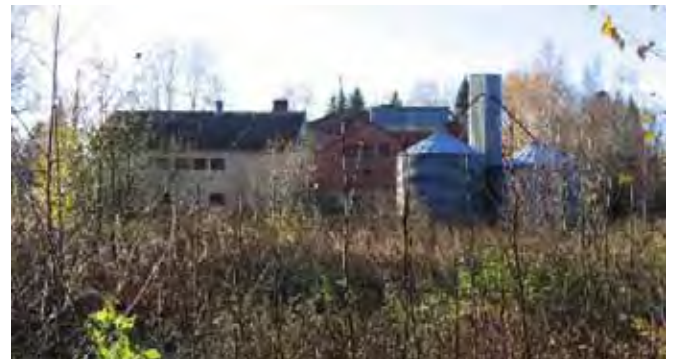
Kaupan takapihalla olevat viljasiilot on rakennettu 1970-luvun alussa. Kuva idän suunnasta, lokakuu 2005.
