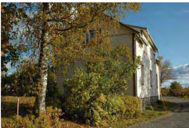
Päärakennus /1/ lännestä Raatarinraitilta kuvattuna.
