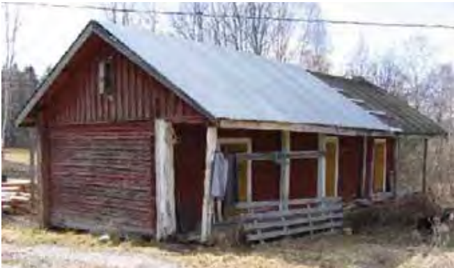
Aittarakennuksessa /6/ on kaksi hirsistä pitkänurkkaista aittaa ja niiden välissä kolmas aitta.
