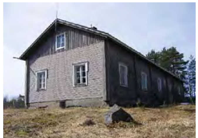
Päärakennuksen itäpääty ja pohjoissivua.
