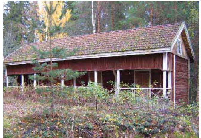
Päärakennuksen pohjoispuolella sijaitsevassa riviaitassa on neljä aittaa. Riviaitta lounaan suunnasta.
