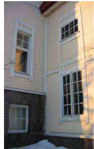
Kaakkoispäädyn kuistiosan kulmauksen ikkunoita.
