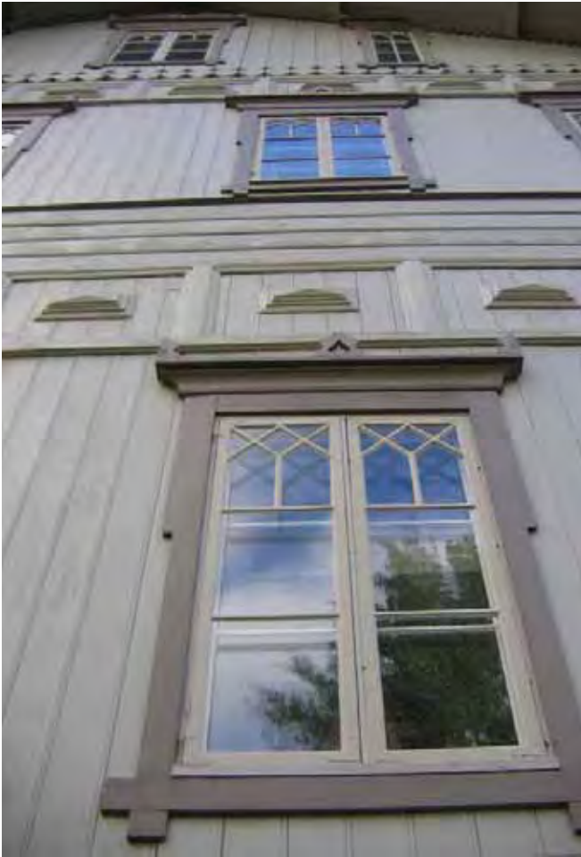
Pihajulkisivun ristipäädyn kohdalta alhaalta ylöspäin katsottuna. Kuva lokakuu 2006.
