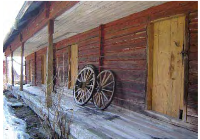
Riviaitan eduskäytävää koillisesta.
