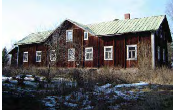
Vanhan asuinrakennuksen eteläsivu ja itäpäätyä.
