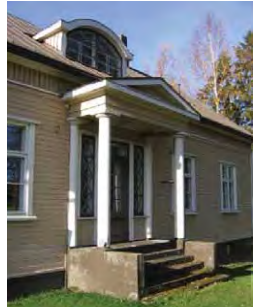
Seurakuntakodin itäjulkisivun sisääntulokatoksen.
