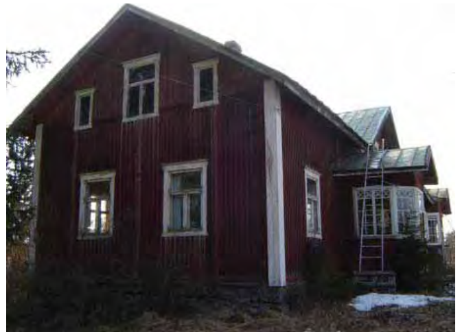
Vanhan asuinrakennuksen itäpääty ja pihasivua.
