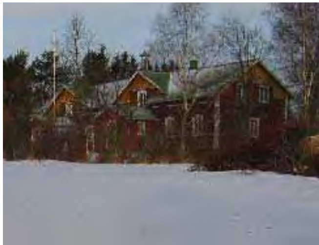
Tuomaalan päärakennus Vinkiäntieltä, kaakon suunnasta katsottuna.
