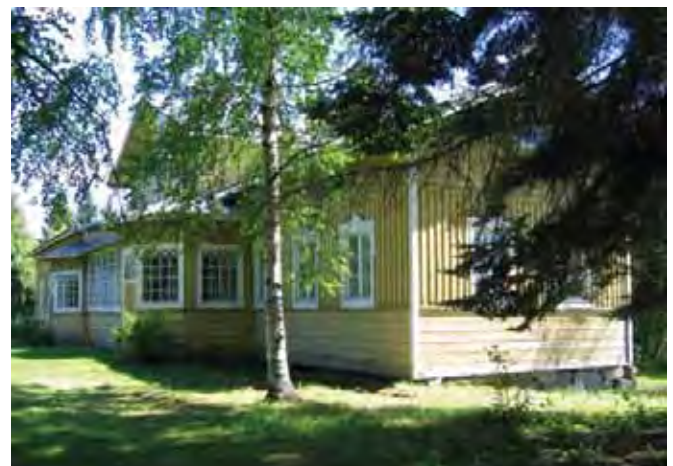
Länsipääty ja pihasivua.
