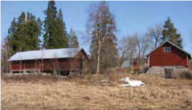
Maakellari /3/ on riviaitan eteläpuolella. Näkymä lännen suunnasta.
