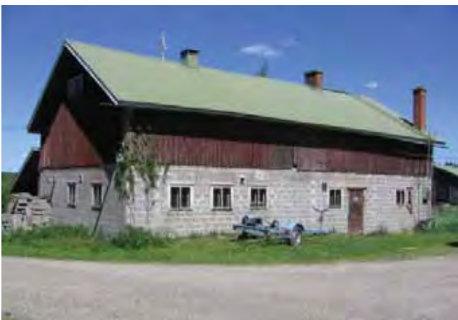
Navetta /2/ lounaan suunnasta. Tiili- ja puurakenteinen karjarakennus on rakennettu vv. 1950-51. (4)
