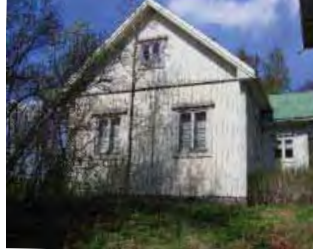
Toisen asuinrakennuksen eteläpääty.
