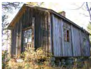
Asuinrakennuksen kaakkoispääty ja koillissivua.
