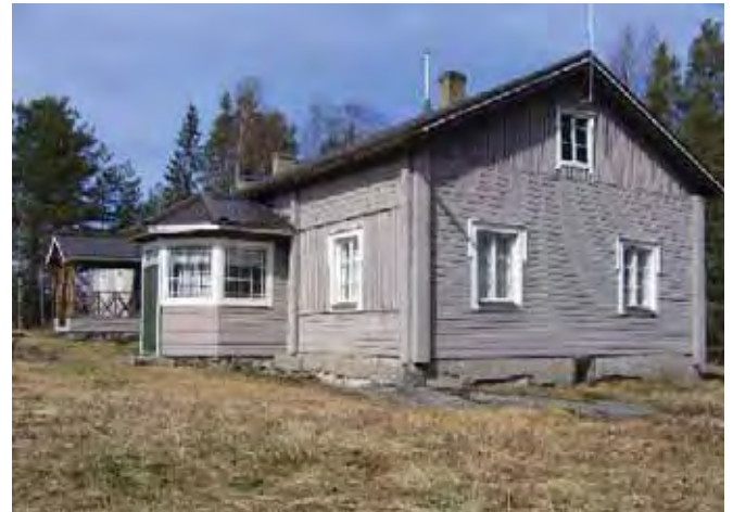
Ylä-Jussilan päärakennuksen itäpääty ja eteläsivua.
