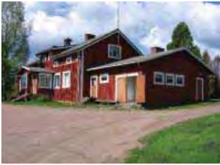
Asuinrakennuksen koillispuolel- dyn laajennusosa, pääty ja kaakkoissivu.
