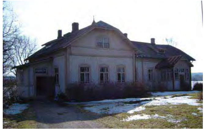
Lahdenpohjan päärakennus koillisen suunnasta.
