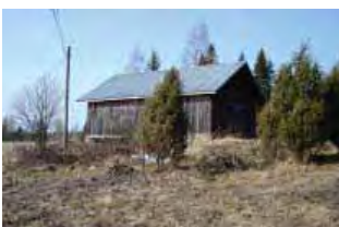
Päärakennuksen länsipuolella on lautarakenteinen kalustovaja /2/.
