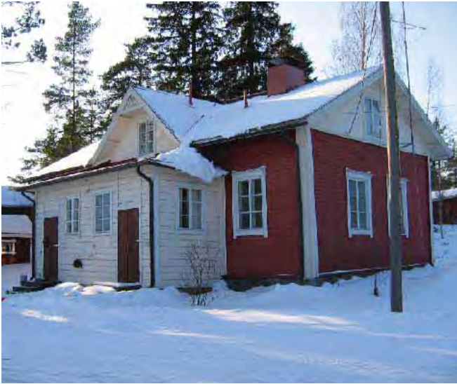
Vanhan päärakennuksen koillispääty ja kaakkoissivua.
