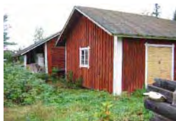
Liiterirakennuksen /6/ takana näkyy jauho- ja kala-aitta. Näkymä itä-koillisesta.
