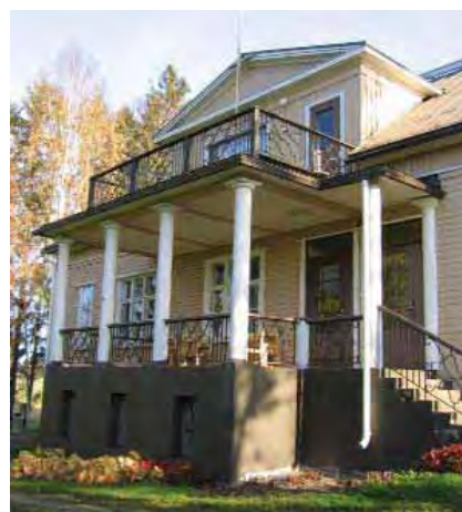
Seurakuntakodin länsipuolen terassi ja parveke. Kuva lokakuu 2005.
