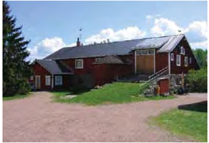
Navetan luoteissivu ja lounaispäätä.
