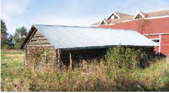
Navetan eteläpuolella on hirsirakenteinen liiteri /13/, jossa on koirankaula-salvokset.
