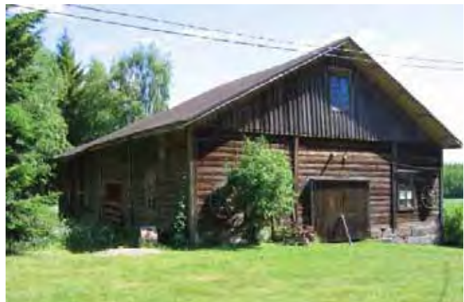
Navetta päärakennuksen suunnasta, länsiluoteesta.
