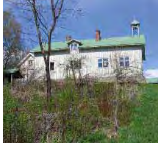
Yliisen päärakennus etelälounaan suunnasta.
