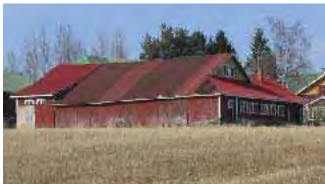
Tuomaalan navettarakennus Vinkiäntieltä, etelän suunnasta katsottuna.
