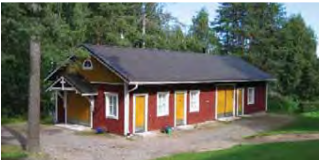
Huoltorakennus kirkon suunnasta, lounaasta katsottuna. Kuva elokuu 2004.
