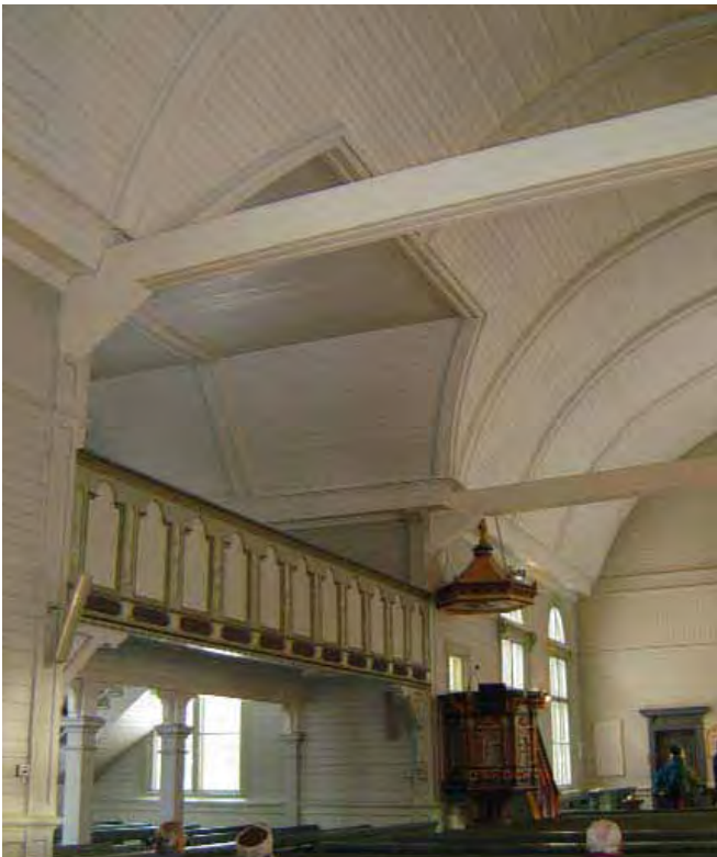
Vasemmalla pohjoispuolen kylkiäinen ja sivulehteri.
