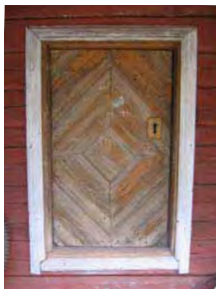
Pohjoispään aitan ovi.
