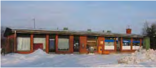
Vuonna 1973 rakennettu liikerakennus /1/ kaakon suunnasta.
