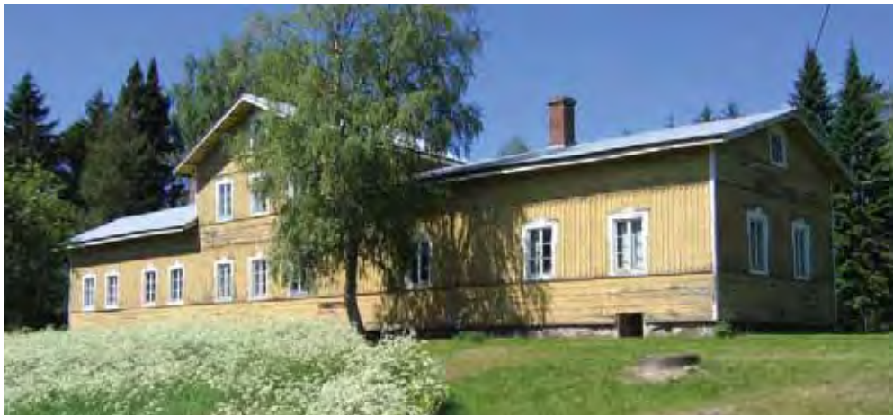
Mattilan päärakennus kaakon suunnasta, julkisivu etelään ja pääty itään.
