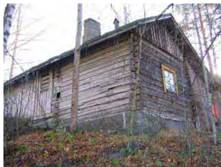
Talusrakennus alarinteen, luoteen suunnasta.
