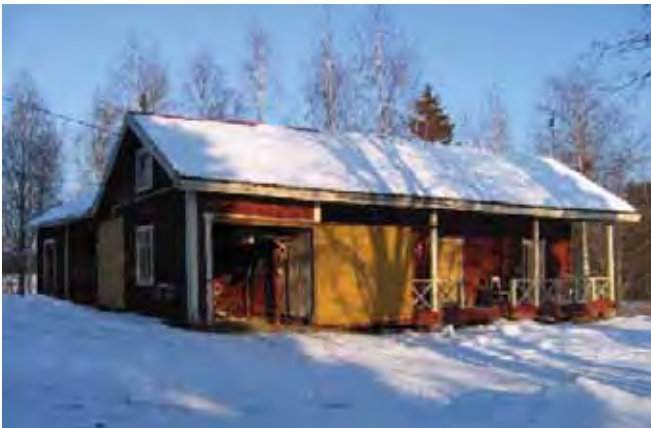
Aitta-kalustusuoja länsi-lounaan suunnasta.
