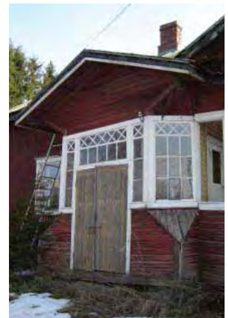
Idän puoleinen pohjoissivulla olevista kuisteista.
