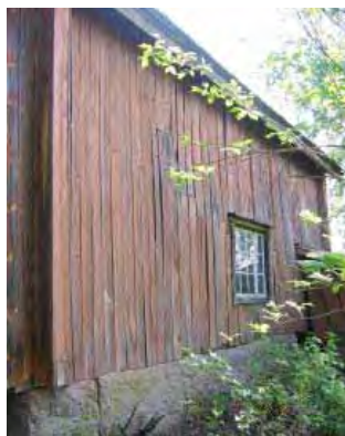
Tallin lounaissivu. Lantalan luukun kohdalle lisätty päärakennuksen kuistin vanhoja ikkunoita.
