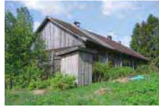
Navetan kaakkoisnurkalla on uudempi ulkokäymälärakennus /5/.
