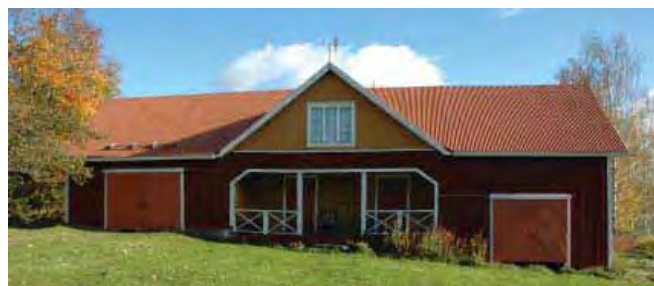
Aitta /3/ lännestä kuvattuna. Sen rakentamiseen on käytetty vanhoja talon aittoja.
