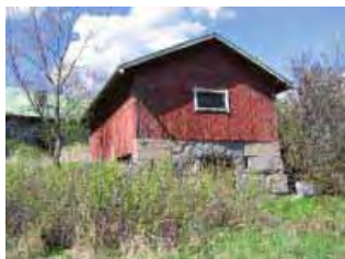
Maakellari-vaja /6/ etelän suunnasta. Navetan takana on kellari-rakennus, jossa on kivinen kellariosa ja sen päällä pystylautavuorattu kalustusuoja tms.
