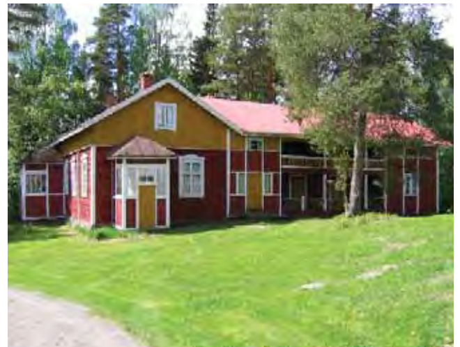
Näkymä sivurakennukseen päärakennuksen päädyn kohdalta, idän suunnasta.
