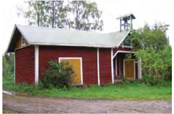
Aittarakennuksen luoteispääty ja pihasisiä lounaan suuntaan.
