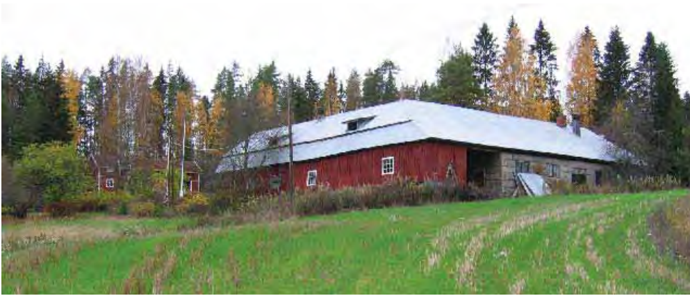
Anttilan navetta-tallirakennus kaakon suunnasta. Taustalla luhtiaitta-sivurakennus.
