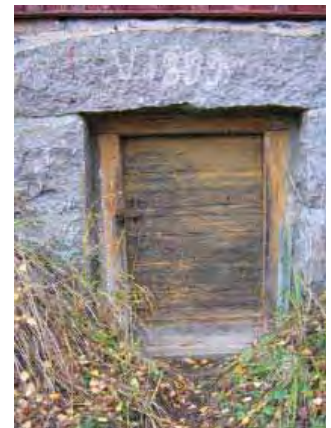
Itäpuoleisen kellarin oven päällyskivessä on kaiverretuna vuosiluku 1899
