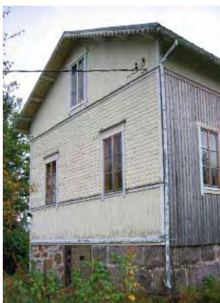
Päärakennuksen ulkoasu vuonna 2004, pohjoisjulkisivu oli uusittu höyläämättömillä pystypaneelimaludoilla.
