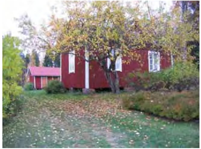
Asuinrakennus Tunkelontien suunnalta, etelästä nähtynä. taustalla aitta.
