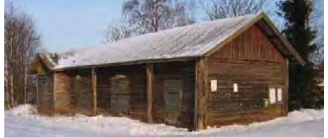
Liikesakennuksen koillispuolella oleva varastomakasiini /2/, pääty Vinkiäntielle kaakkoon. Varastomakasiinissa on kolmi-huoneinen pitkänurkkainen hirsiosa ja sen päädyssä ulkonevan laajennuksen kohdalla poikkipääty.
