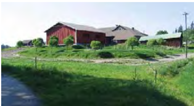
Konehalli /5/ keskellä, navetan eteläpuolella, näkymä kaakon suunnasta. Vilja-aitta vasemmalla.
