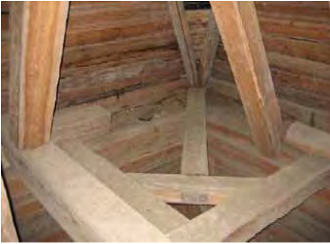
Länsitornin hirsirakenteita kohdassa, mistä torni kapenee ylöspäin kellotapuliksi. Kuva toukokuu 2006.
