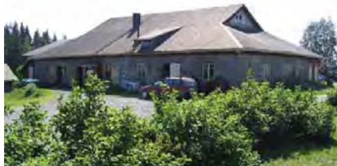
Navetta asuinrakennuksen suunnasta, koillisesta nähtynä.
