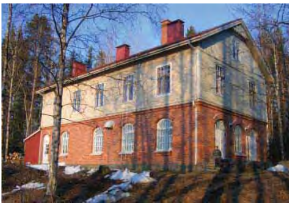
Meijerirakennus lounaan suunnas- ta.
