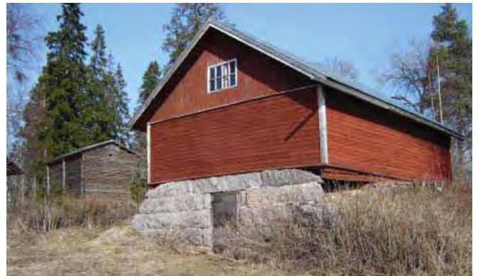
Maakellari on holvattu kivistä ja se on jaettu kiviseinällä kahteen pitkittäisosaan. Sisäänkäynnin edusta on myös muurattu lohkokivistä. Kellarin päällä oleva rakennus (kellarin parvi) on vaakalautavuorattu, punamultamaalattu. Lounaan suunnasta.
