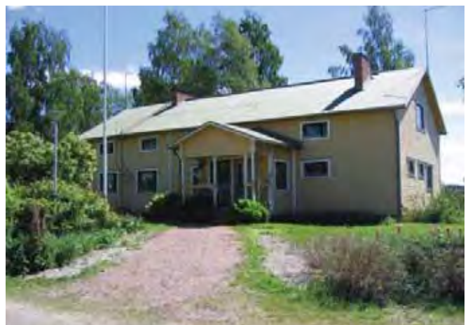
Asuinrakennus luoteen suunnasta. Asuinrakennus /1/ on rakennettu sodan jälkeen, vuonna 1949-1950 ja jatkettu 1985.
