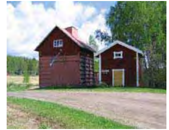
Kuivurirakennus /10/ ja vilja-aitta lounaan suunnasta.
