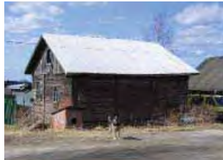
Rakennuksen /5/ runko on osittain hirttä, laajennettu katoksella luoteispuolelle.
