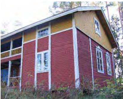
Sivurakennuksen siiven pääty, näkymä lounaasta.
