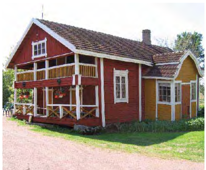
Sivurakennuksen koillispääty ja luoteissivua.
