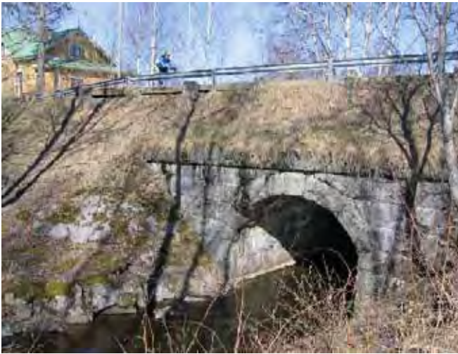
Västilänjoen silta Puharilan puolelta, näkymä länteen. Myllymäen silta Västilässä maantiellä 3280 on valmistunut vuonna 1935, suunnittelija oli Bruuno Kivisalo. Kiviholvisilta on vapaa aukoiltaan 3,4 m leveä. (Lähde: Siltarekisteri, Tiehallinnon Hämeen piiri)
