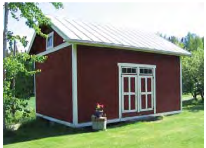
Asuinrakennusta vastapäätä oleva aitta-talouksrakennus 1/2 pohjoisen suunnasta. Katteena saumapelti, runkotolpat, vaakaponttilaudoitusta, punamullan punaiseksi maalattu.
