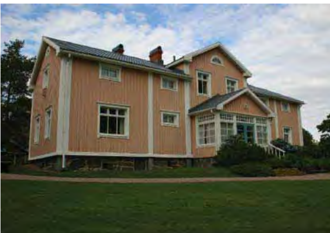
Poukan päärakennus peltorinteen puolelta, lounaan suunnasta nähtynä (syyskuu 2010)..
