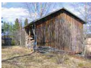
Liiteri-kalustovaja tms rakennus /3/ etelän suunnasta, taustalla uudehko pieni saunarakennus /4/.
