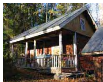
Syytinkiaittarakennus kaakon suunnasta nähtynä. Vieressä sijaitsee lautarakenteinen liiteri /11/, jota näkyy hiukan kuvan oikeassa laidassa.
