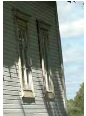
Asuinrakennuksen/1/ päätyikkuna ja koilliskulman vanhat ikkunat.
