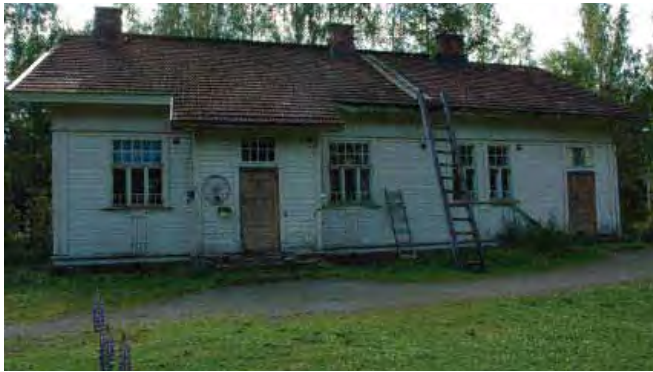
Asuinrakennus /1/ luoteesta (pihalta) kuvattuna.
