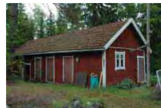
Piharakennus /3/ luoteesta kuvattuna.
