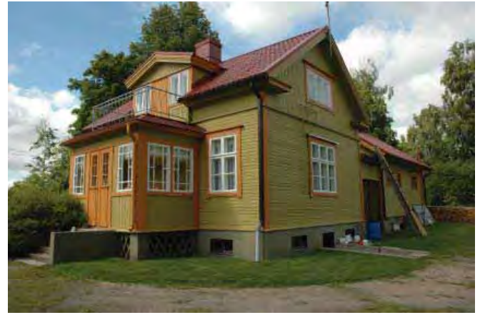
Asuinrakennus/1/ etelästä ja kaakosta kuvattuna.
