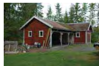
Autotallirakennus /4/ kaakosta kuvattuna.
