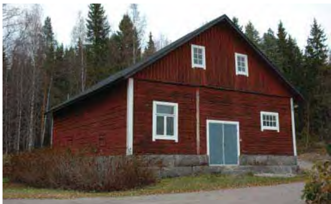
Lyhytnurkkainen hirsirakenteinen talli /3/ lounaasta kuvattuna. Rakennuksen päätykolmio on pystyrimalautaa ja siinä on jäljellä alkuperäiset ikkunat (1 T-karmi ja pieniä pikkuruutuisia ikkunoita)
