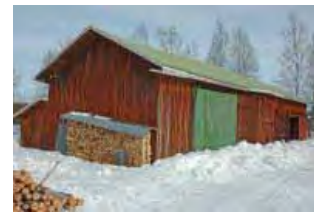
Kone-heinälato /5/ lounaasta kuvattuna. Ladon itäpäätty on hirsirakenteinen pitkällä nurkilla.
