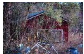
Piharakennus /8/ luoteesta kuvattuna.
