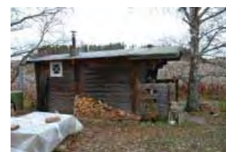
Jalassauna /3/ etelästä kuvattuna.
