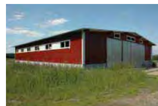
Peltirakenteinen pihatto /8/ kaakosta kuvattuna.
