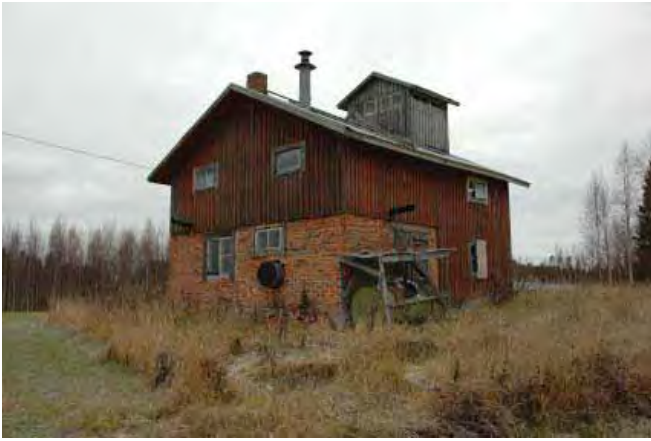
Vanhasta pihapiiristä luoteeseen peltokappaleen toisella reunalla mäellä sijaitseva tiili-puurunkoinen satulakattoinen rakennus/5/ lienee alkujaan ollut pieni navetta, joka lienee sitten muutettu viljan kuivuriksi.
