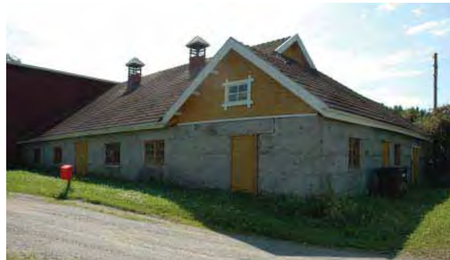
Navetta/4/ koillisesta kuvattuna.
