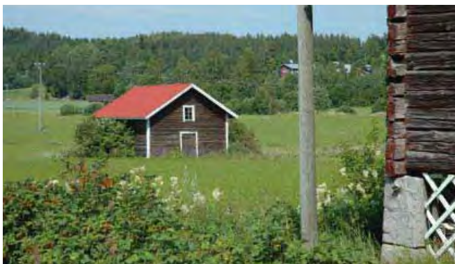
Satulakattoinen, aaltopellillä katettu, suorakaiteen muotoinen lyhyellä nurkalla veistetty täyshirsinen kiville perustettu makkasiini/3/ on pihapiirin tuntumassa. Se on omistajien mukaan rakennettu n. 1930, mutta vaikuttaisi vanhemmalta.
