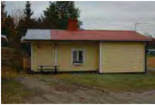
Vanha asuinrakennus /5/ (kuva luoteesta) on muuttunut laajennusten (19970-l ja 1990-l.) myötä. Vanhin osa on hirttä.
