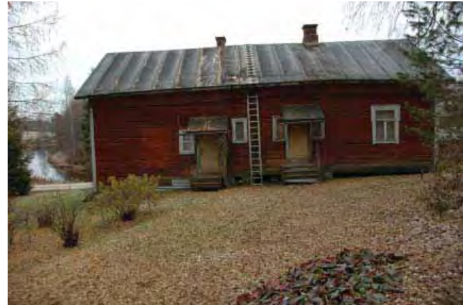
Asuinrakennus /1/ etelästä ja luoteesta kuvattuna.
