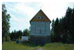
Peltirakenteinen kuivuri/7/ pohjoisesta kuvattuna.
