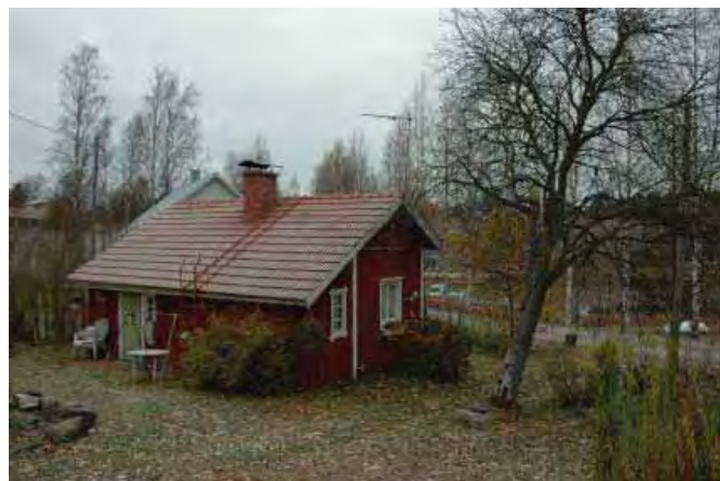
Nykyisin loma-asuntona oleva Puhelinyhdistyksen talo /1/ kuvattuna luonaasta. Takana näkyy Laurilan kaupan kattoa.
