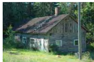
Navetta /4/ pohjoisesta kuvattuna.
