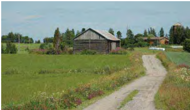
Sisääntulotien varressa on komea pitkänurkkainen pyöröhirsinen satulakattoinen aaltopellillä katettu lato, on rakennettu 1960-luvulla vanhoista hirsistä.
