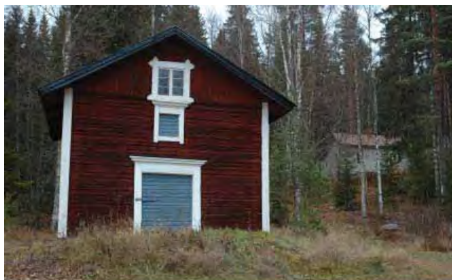
Oikealla lyhytnurkkainen hirsirakenteinen Jyvääitta /6/ lounaasta kuvattuna.
