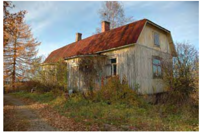
Vanha asuinrakennus /2/ etelästä ja kaakosta kuvattuna.
