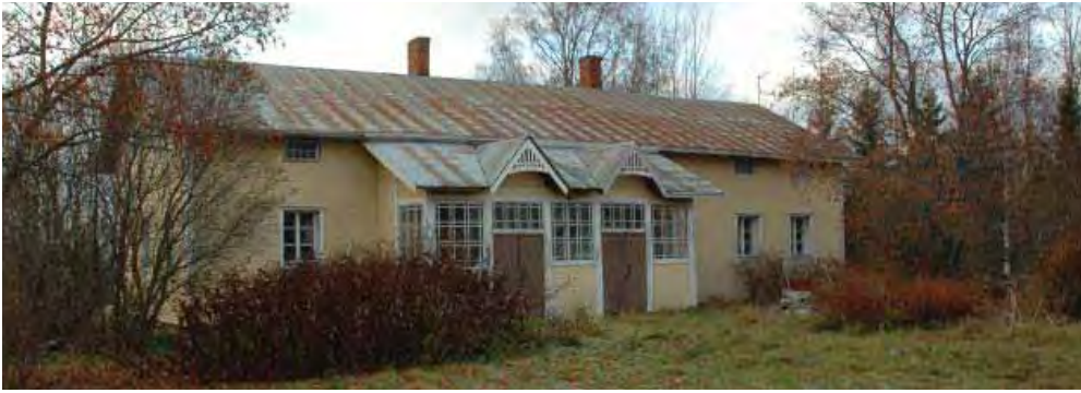
Asuinrakennus /1/ kaakosta kuvattuna.
