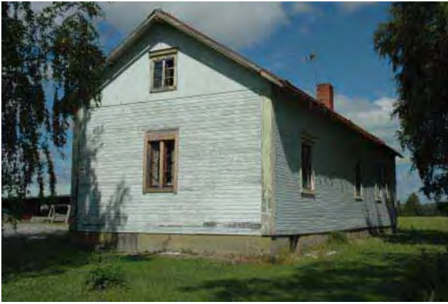
Asuinrakennuksen/1/ vanhin osa kaakosta kuvattuna.
