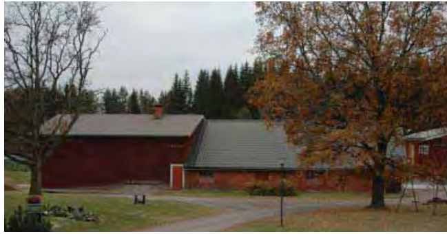
Entinen navetta /6/ kaakosta. Satulakattoinen, tiilirunkoinen karjasuoja ja lautaverhoiltu lato toimivat nykyisin sahatiloina.
