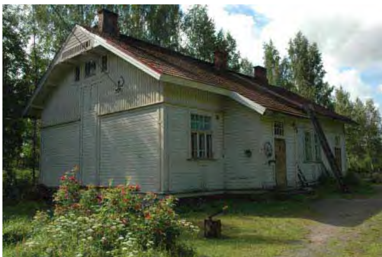
Asuinrakennus /1/ pohjoisesta kuvattuna.
