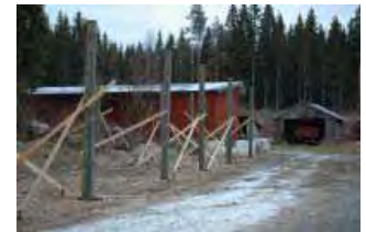
Kuvassa vasemmalla lautarakenteinen puutavaravarakatos /14/, sen takana näkyy hieman sekataravaravastoa /15/ ja oikealla hirsirakenteinen entinen puimuritalli ja lato /16/
