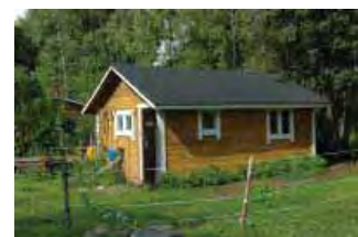
Kanala /3/ idästä kuvattuna.
