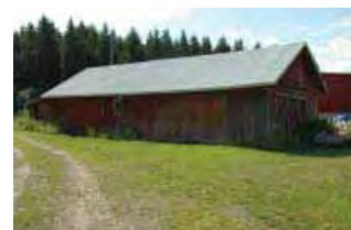
Satulakattoinen suorakaiteen muotoinen lautarakenteinen lato/6/ on katettu aaltopellillä ja vuorattu punamullalla maalatulla pystylaudalla.
