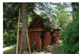
Talousrakennus/2/ pohjoisesta kuvattuna.
