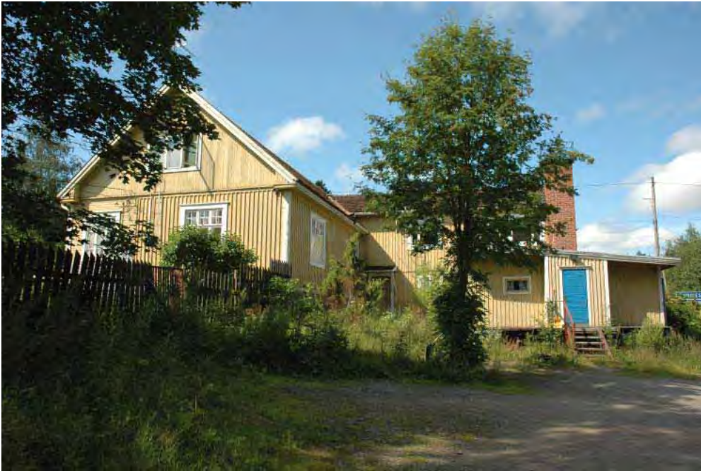
Kaupparakennus /1/ koillisesta kuvattuna. Vanhin osa kuvassa vasemmalla ja laajennus oikealla.
