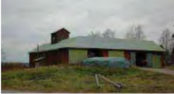
Lautarakenteisessa peltikateisessa L-runkoisessa kuivurissa /10/ on sekä lämmin että kylmäilmakuivaus ja siilot kuva koillisesta.
