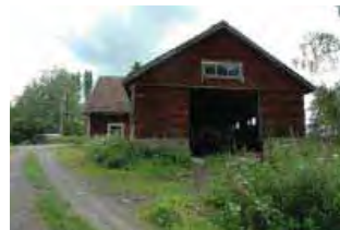
Vanha navetta /6/ lännestä ja pohjoisesta kuvattuna.
