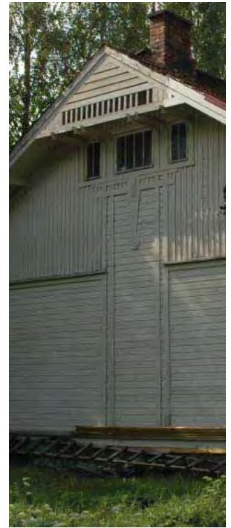
Asuinrakennuksen /1/ itäpäädyn koristepaneloinnit.
