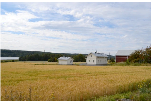
Uudisrakennus Sarkolantien länsipuolella.
