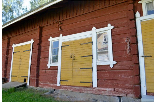
Ristikkein menevät ikkunan- ja ovenpielet ovat tyyppillisiä 1900-luvun alun navetoissa.
